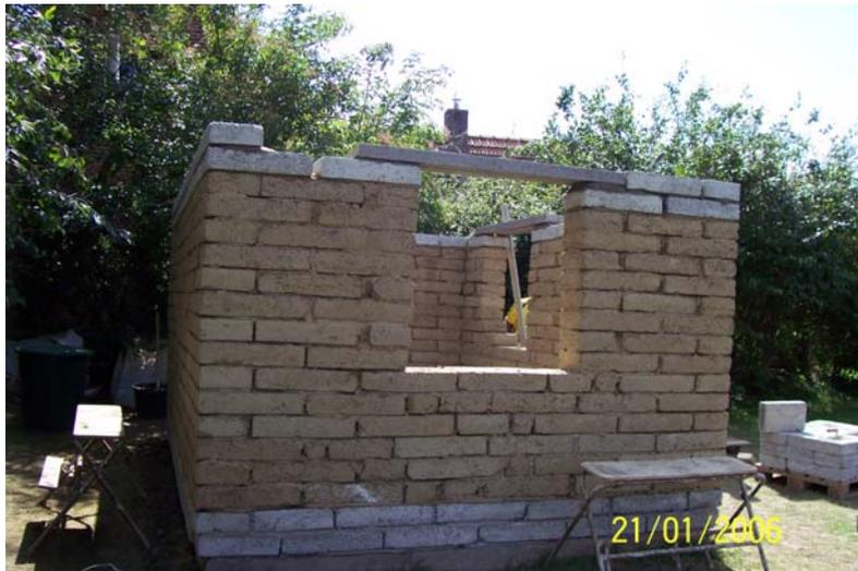
Bild 23: Außenwände monolithisch aus Lehmsteinen
