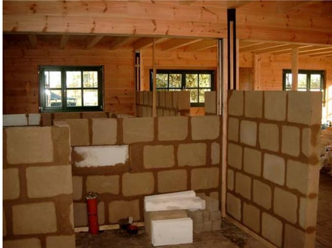
Bild 20: Erstellen von Innenwänden mit dem zweiseitig verputzten Kernelement
