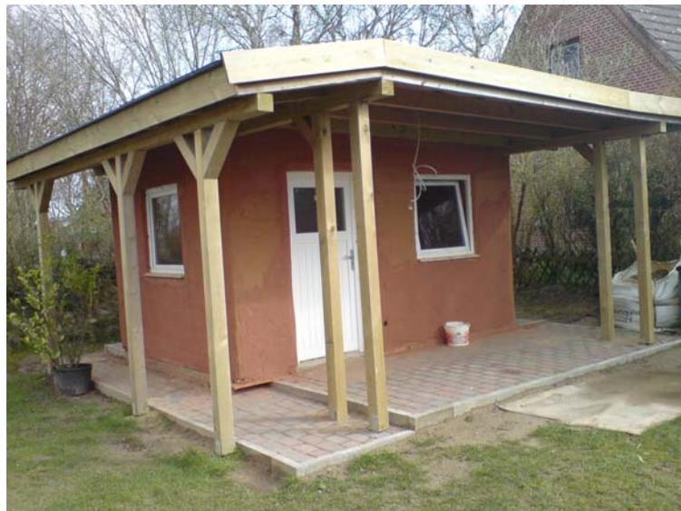
Bild 24: Außenwände mit Lehm verputzt
