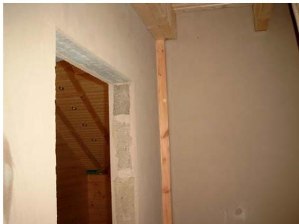
Bild 28: Fertig verputzte Lehmwände aus großformatigen Lehmsteinen
