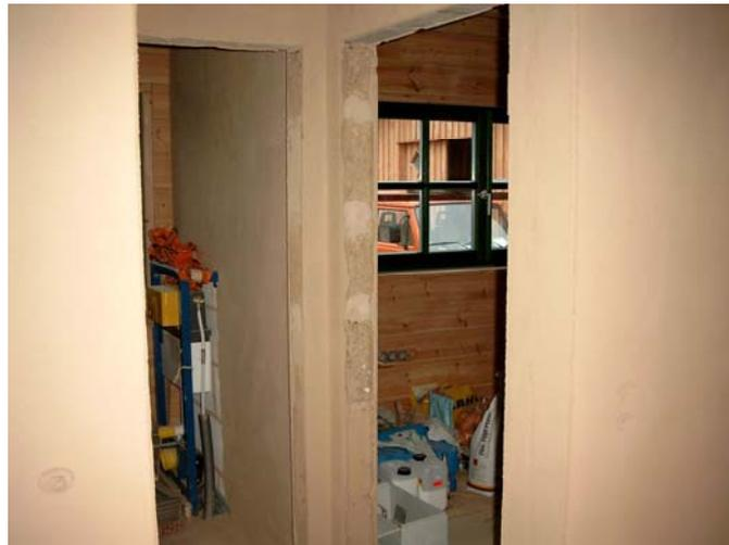
Bild 21: Die trockenen Lehmwände werden mit Lehmputz verputzt.
