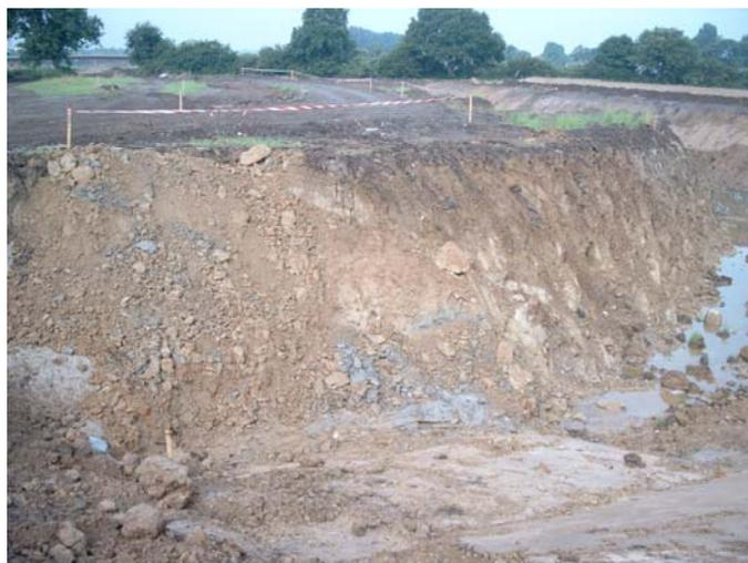
Bild1: Lehmaushubstelle für eine Pflanzenkläranlage
