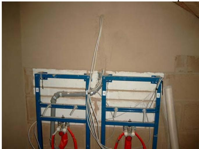
Bild 22: Detaillösung für die Befestigung von wandhängenden Toiletten
