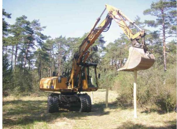
Abb. 17: Die Robinienpfosten wurden mit der Baggerschaufel in vorher aufgemeißelte Pfostenlöcher gedrückt.
