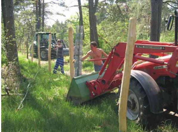
Abb. 16: Einbau des Knotengeflechtzauns bei den Hirschen.
