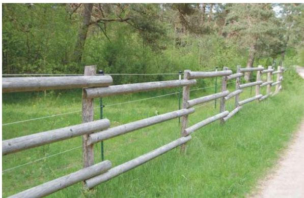
Abb. 20: Der fertige Pferdezaun mit innenliegendem, separatem Elektrozaun.
