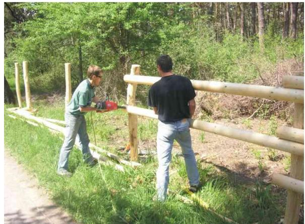
Abb. 19: Die Fichtenquerriegel am Pferdegatter wurden überlappend auf der Außenseite angenagelt.
