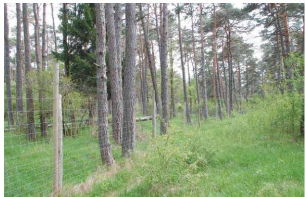
Abb. 21: Der fertige Rothirschzaun. Um eine durchgehende Höhe von 2 m zu gewährleisten, wurde der Zaun an Stellen, wo sich auf der Innenseite Hangkanten befinden, um weitere 50 – 100 cm durch zusätzliche Drähte erhöht.
