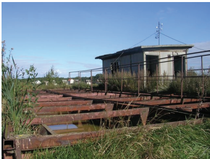
Abb. 11 Die Kläranlage in Rybachy
