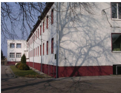
Abb. 45 Die Biologische Station in Rybachy
