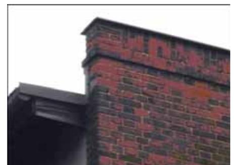
Ungedämmte Attika als Wärmebrücke
