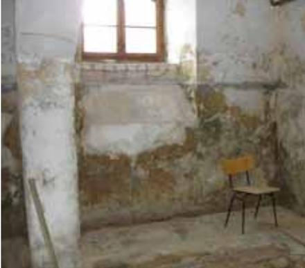
Feuchteschäden und Ausblühungen im Souterrain der Mittelschule
