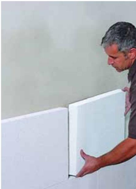
Einbau von Kalziumsilikat-Innendämmung
