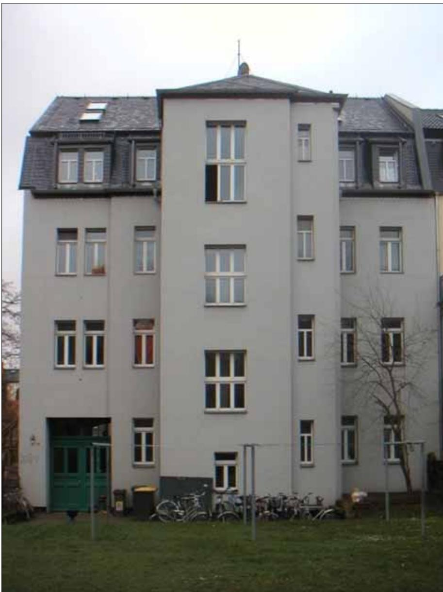
Hoffassade mit neuer Wärmeschutz-Vorsatzfassade, Zustand Februar 2007
