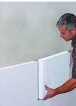
Abb. 41: Einbau von Calziumsilikat-Innendämmung
