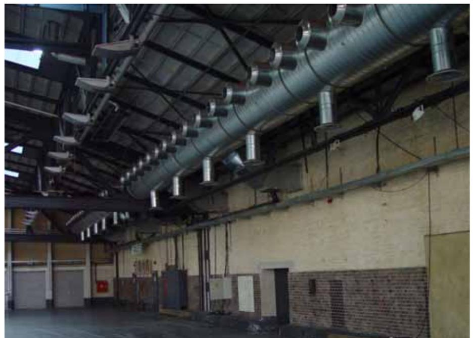
Die Erwärmung der Halle erfolgt nicht mehr wie im historischen Original über die zugeführte Luft, sondern durch an der Decke montierte Gas-Dunkelstrahler. Diese Technik ermöglicht die Absenkung der Raumlufttemperatur um bis zu drei Grad, bei gleich empfundener Behaglichkeit. Insgesamt sind 23 Gas-Dunkelstrahler für den kurzfristigen Wärmebedarf mit Nennleistungen zwischen 14 und 23 kW installiert.
