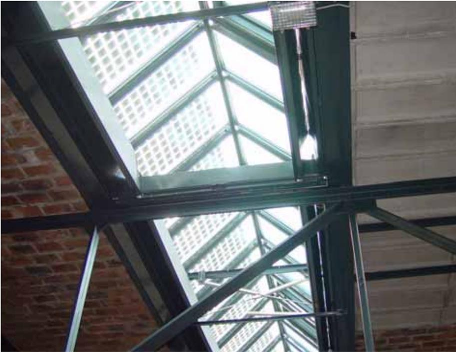
Bei Veranstaltungen ist es meist gewünscht, den Veranstaltungsraum zu verdunkeln. Diesem Zweck dient ein Klappelement (siehe Pfeil), durch das die Lichttrauben innen geschlossen werden können. Dieses Element wurde durch das Büro demel architekten entwickelt und patentrechtlich geschützt. Es ist ebenfalls eingesetzt, um Wärmeverluste zu reduzieren und durch eine zur Raumseite aufgebrachte absorbierende Fläche die Raumakustik zu optimieren.
