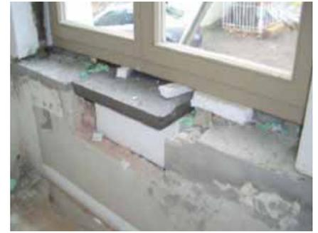
Einbau der Energiefensterbank mit Aussparung für die Wärmerückgewinnung
