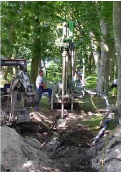
Einbringen von Kanälen zur Erdwärmennutzung
