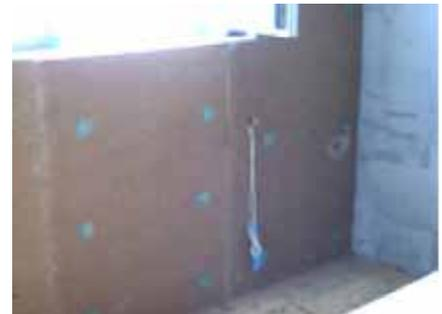
Innendämmung aus Holzweichfaserplatten
