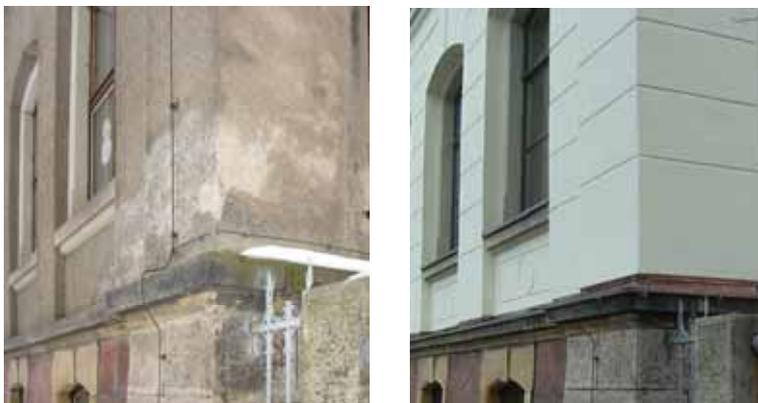
Abb. 39: Schäden an der Schulfassade und Nordost-Ecke nach Behebung der Schäden
