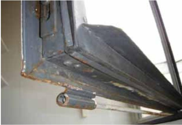
Abb. 34: Ungedämmter Fensterrahmen mit Korrosionsschäden. Quelle: sol id ar
