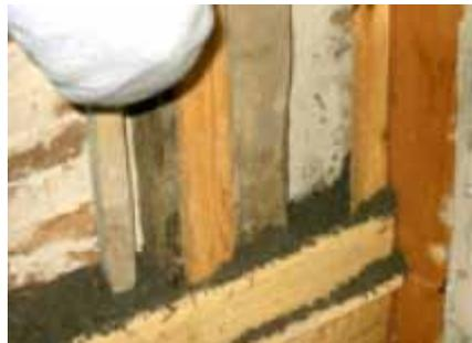
Innendämmung aus Wärmedämmlehm
