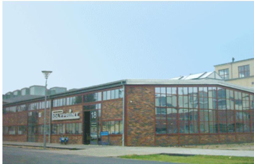
Außenansicht mit sichtbarem Tragskelett, Klinkerausfachung und Stahlfenstern
