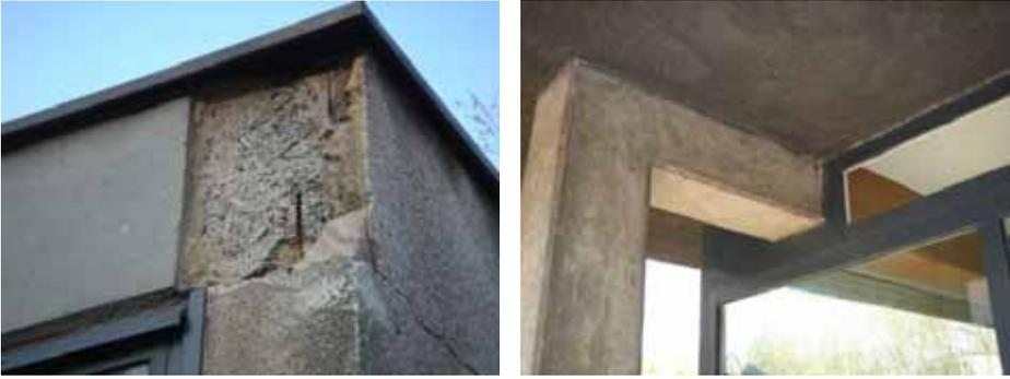
Abb. 9: Details Gebäudebestand: Bauschäden und Wärmebrücken
