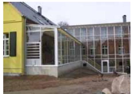
Die Südfassade wird mit Innendämmung und Dämmputz energetisch aufgewertet.
