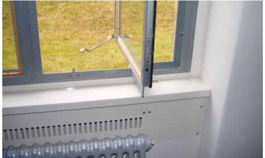
*Ein wesentlicher Beitrag zur denkmalverträglichen Integration der kontrollierten Lüftung erfolgte bei der baulichen Ausbildung von Zu- und Abluftöffnungen. Diese wurden durch eine Eigenentwicklung minimalisiert, so dass sie unsichtbar und damit denkmalgerecht unter dem Fenstersims integriert werden konnten.*
