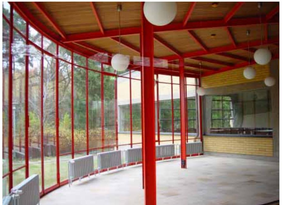
*Der durch Überbauung verloren gegangene Wintergarten wurde auf dem noch vorhandenen Original-Fundament wieder hergestellt. Die filigrane Stahlfensterkonstruktion wurde rekonstruiert.*
