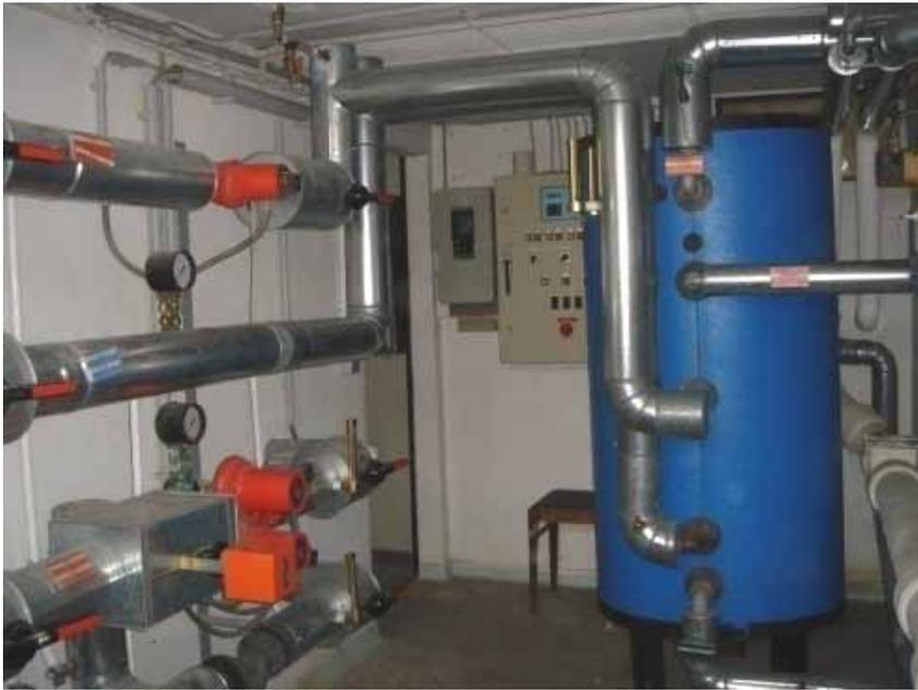
Abb. 11: Dezentrale Trinkwassererwärmung im Gebäudekeller
