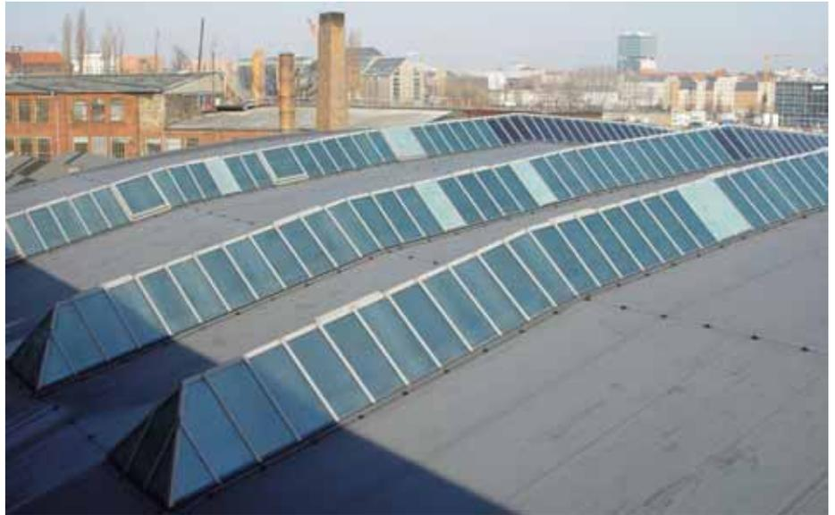
*Ursprünglich war in den Lichtraupen eine Einfachverglasung verbaut, die durch eine hochwertige Wärmeschutzverglasung ersetzt wurde. Anstelle des Drahtglases kam ein Ornamentglas zum Einsatz, das eine dem Original ähnliche Transparenz und Lichtstreuung aufweist und den Vorstellungen der Denkmalpflege entspricht.*
