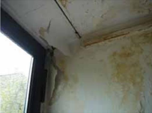
Abb. 10: Feuchtigkeitsschäden in den Gebäuden: Wärmebrücken und fehlende Lüftungseinrichtungen in den Feuchträumen führten zu feuchten Wänden, Schimmelbildung und Korrosionsschäden. Allein schon aus diesen Gründen ist eine Sanierung der Gebäude unumgänglich.
