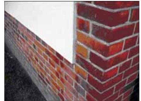
Außenwand-Eckdetail mit Randabschluss des Wärmedämmputzfeldes (Bristolstr. 1)
