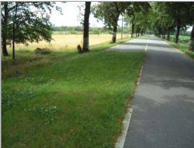
Teilentsiegelung einer Straße mit Belassung von Ausweichbuchten (Bild-Autor: Ralf Rudolf)
