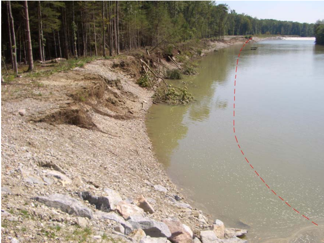
Abb. 7-4: Blick in Fließrichtung von Rampe 16,4 auf Rampe 17,0; (Photo: WWA Donauwörth), Situation nach dem HW 2005 und ungefähre Uferlinie vor dem HW
