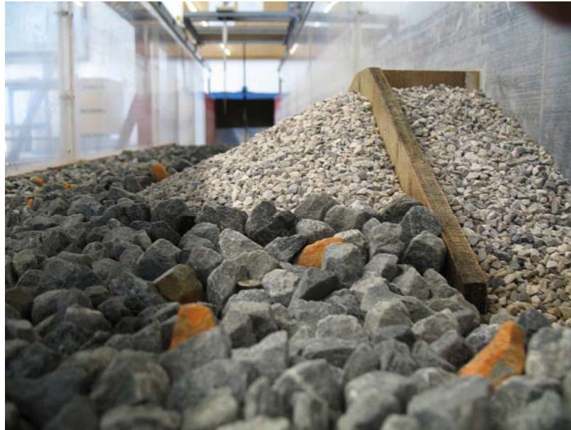
Abb. 6-54: Erstellung der Seitenstrukturen in Steinsatz (Bauzustand)
