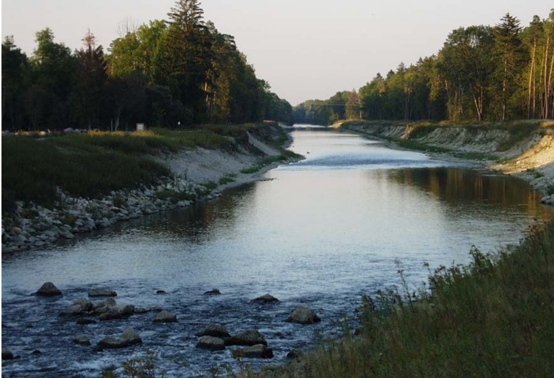
Abb. 7-21: Wertach Fkm 13,0 nach dem Auguthochwasser 2002; Blick in Fließrichtung (Photo vom August 2003)
