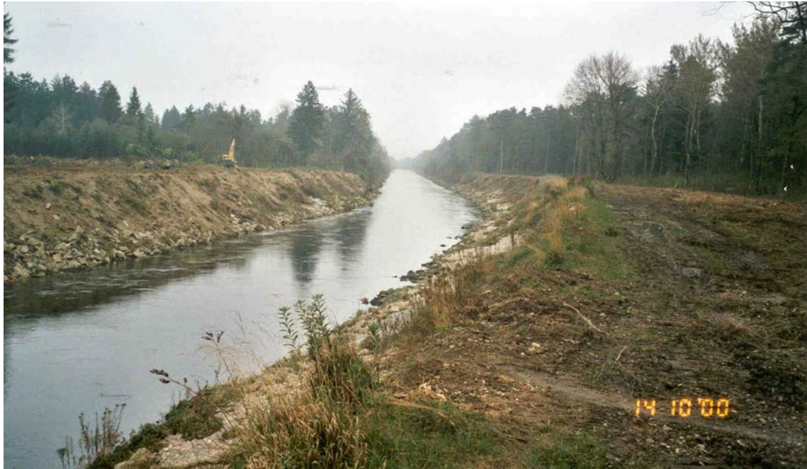
Abb. 7-19: Wertach Fkm 13,0 vor den Baumaßnahmen; Blick in Fließrichtung (Photo: WWA Donauwörth)
