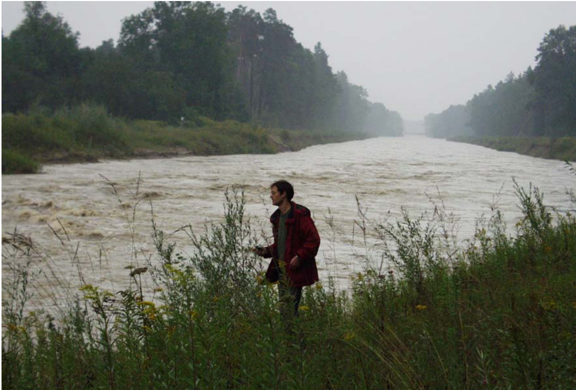
Abb. 7-23: Wertach Fkm 13,0 während des Augusthochwassers 2005; Blick in Fließrichtung
