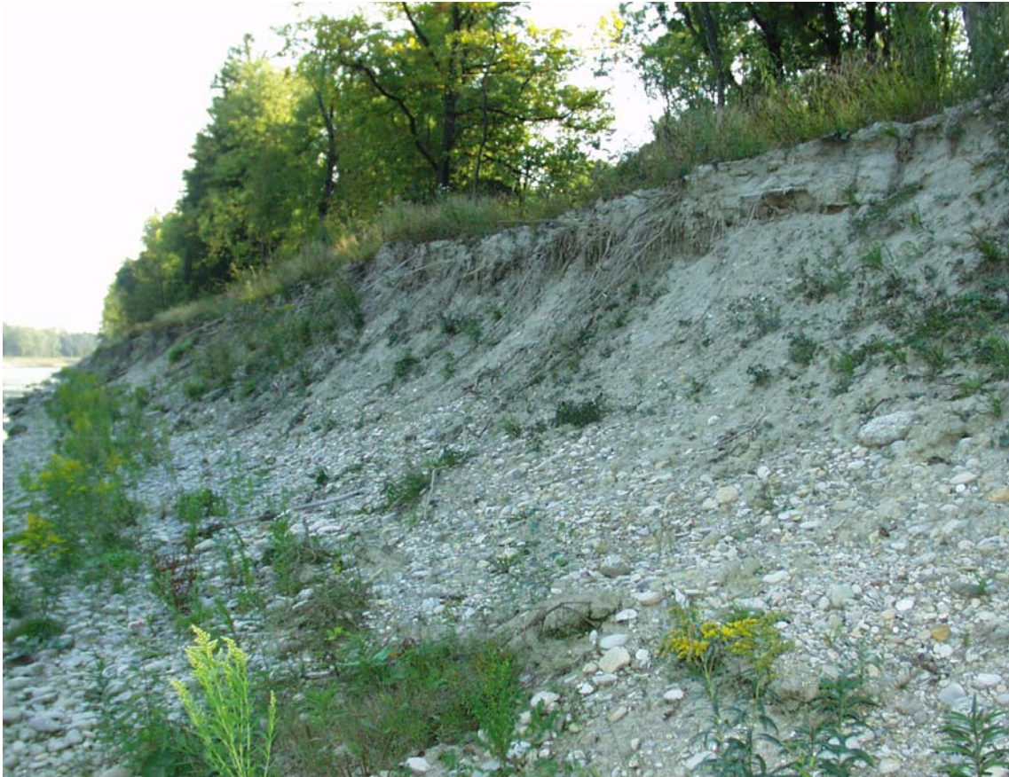
Abb. 7-25: Böschungssituation; Feinteilschichtung und Kies
