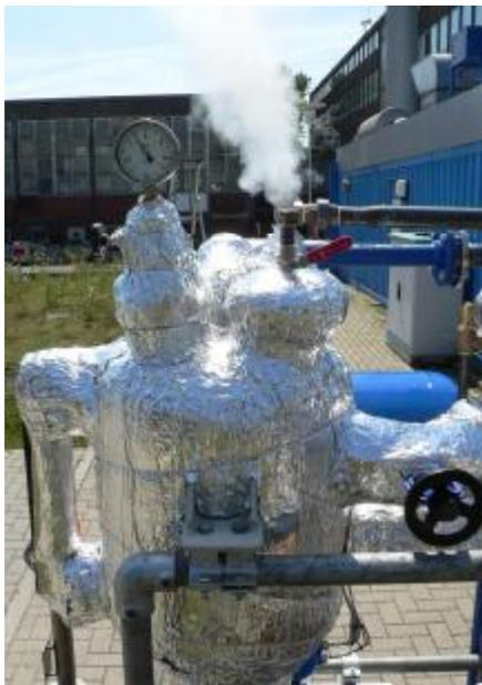
Abbildung 10: Dampftrommel der Solar DSKM
