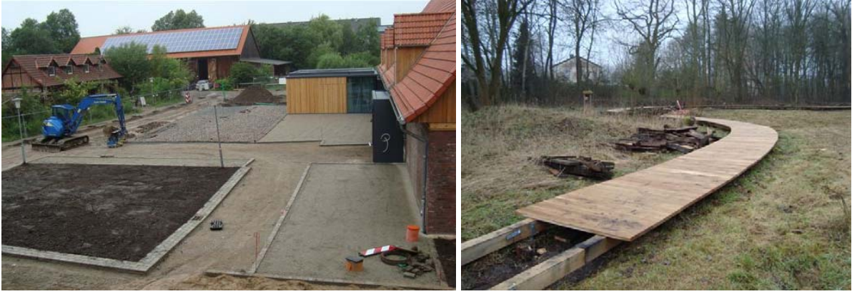
Abb.79,80: Die Hoffläche wurde völlig überarbeitet. Der Bohlensteg musste erneuert werden.
