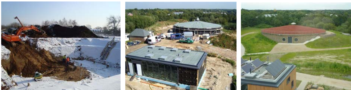
Abb.66-68: Riesige Baustelle bis zur Fertigstellung von Wärmespeicher und gläsernem Energiehaus
