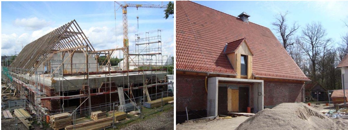
Abb.5,6: Für die Dachdämmung mussten alle Sparren abgebaut, gekennzeichnet und wieder aufgestellt werden. Der Eingangsbereich wurde als moderner Gegensatz zum Altbestand gestaltet.
