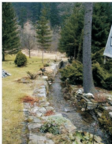
Nekapacitní koryto mezi skládanými zidkami /rovnaninami - spodní úsek v zahradách chat, Mnichov, III/O1.
