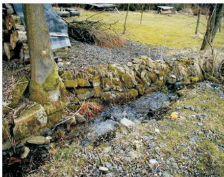
Jasan rostlý do skládané zidky ji svými kořeny vhodně stabilizuje, zahrady nad č. Mnichov - Točna, III/O1.
