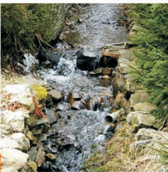
Překážky /bariéry v korytě mezi skl. zidkami (rovnaninami) v zahradách, vyústění odpadního potrubí, nad č. Mnichov - Točna, III/O1.
