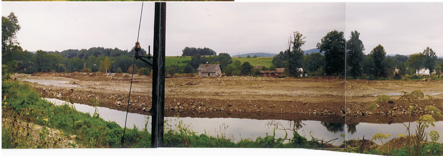
Zasypávání povodňového koryta řeky Bělé v Mikulovicích, dnes mj. obchvat na silnici I/44, stav v r. 1997
