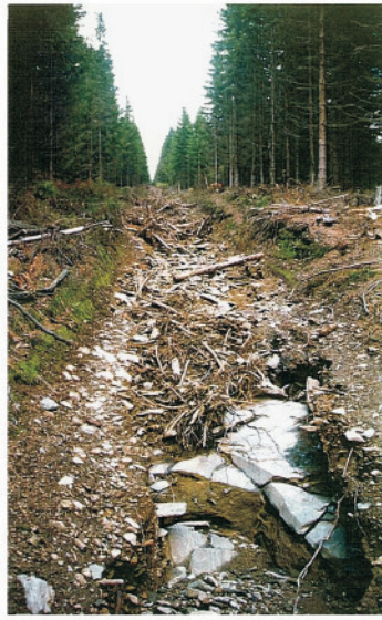
Přibližovací linka , Černý vrch 8.7. 1997, Erodovaný zpevňující průsek - linka, 08/ 1997. Zcela vlevo zářezová strana linky na Jeleních loučkách v červenci 1999
