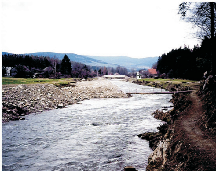
Vlevo a vpravo nahoře dosypávky povodňového rozšířeného koryta řeky Bělé, Hradec - Nová Ves - Mikulovice. Nahoře stav v r. 1997/8, vpravo stav v r. 1999 - 2000. Patrné zúžení průtočného profilu.
