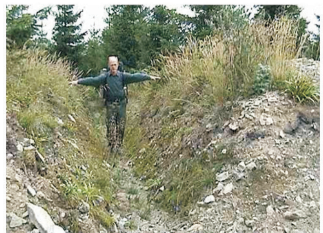
Odvodňovací příkop na svážnici, Jelení loučky 09/ 2004
