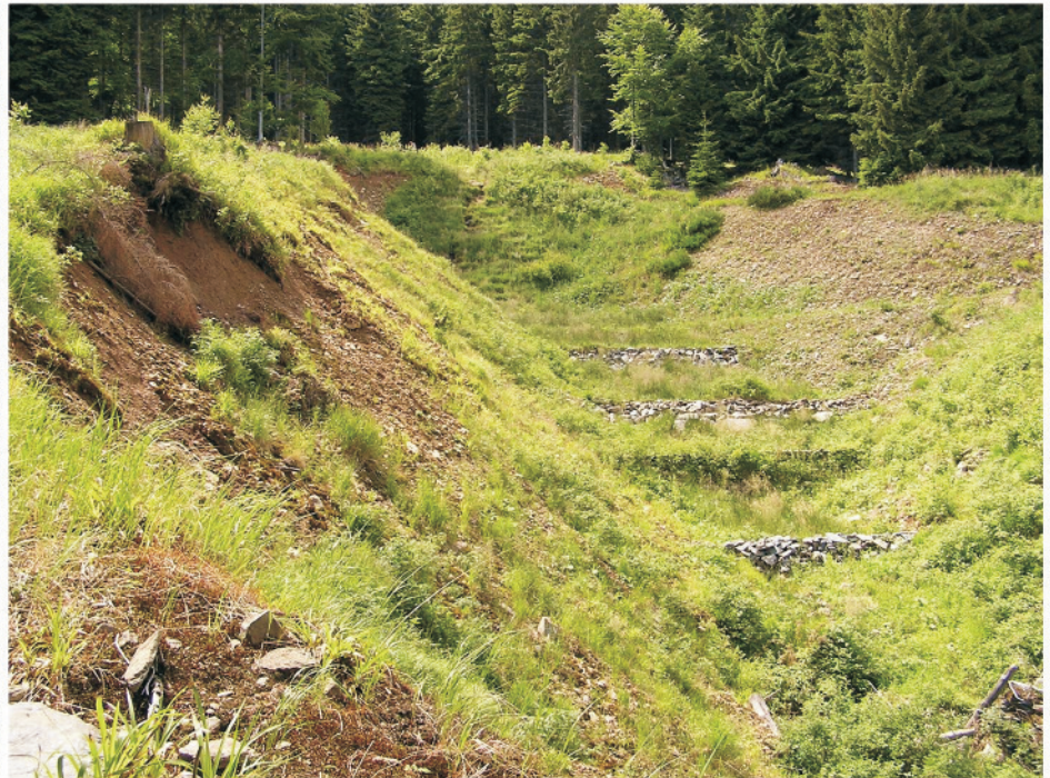
Sesuv v pramenné oblasti Sokolího potoka na V úbočí Orlíka, 06/2007. Neasanované, stále erodující svahy.
