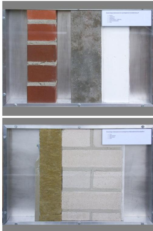
Die Schnittmodelle wurden nach eigenen Zeichnungen in einer Modellbauwerkstatt angefertigt. Sie zeigen die wesentlichen Konstruktionen des Demonstrationszentrums Gebäudesanierung in Gelsenkirchen-Buer, die sanierten und unsanierten Altbauten in Münster und ausgewählte Standardkonstruktionen verschiedener Baujahre (z. B. nachträglich gedämmtes zweischaliges Mauerwerk).
