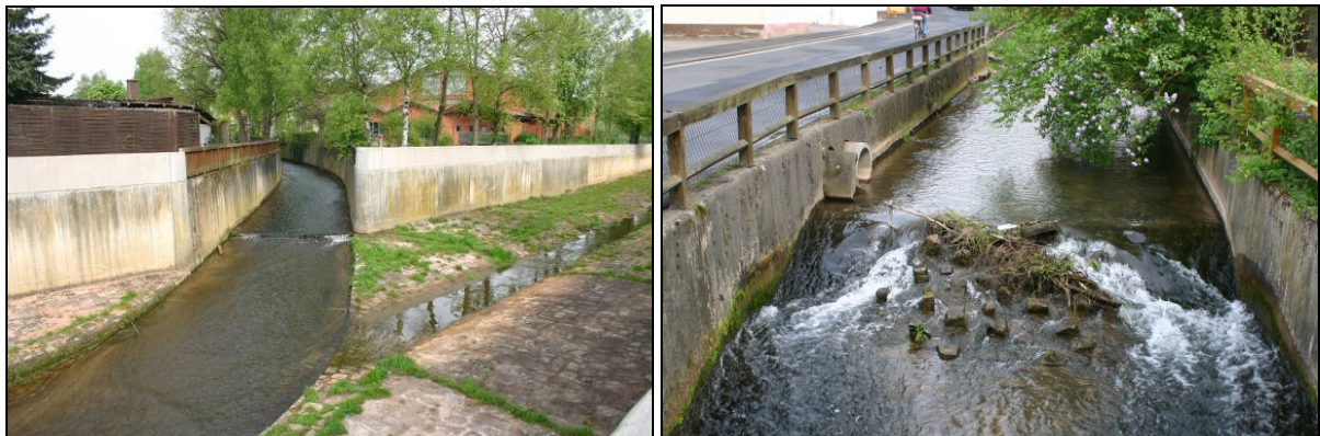
Abb. 34: Naturfern ausgebauter Unterlauf der Aura in Burgsinn
