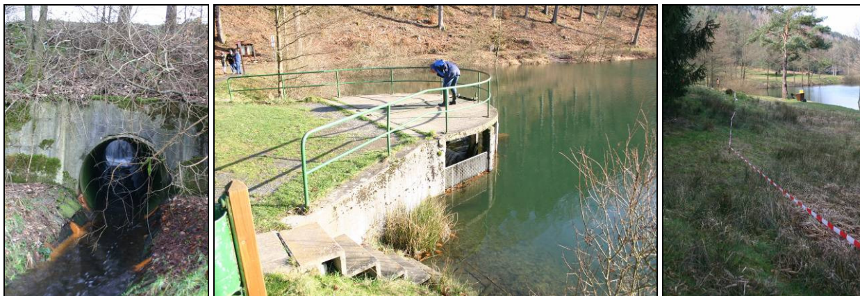
Abb. 27: Ein Rohr mit Absturzbauwerk am Haselweiher stellt ein unüberwindbares Hindernis für wandernde Gewässerorganismen dar. Der Bau eines Umlaufgerinnes scheiterte jedoch an einem geschützten Borstgrasrasenbestand (Bild rechts, geplante Verlauf des Umwegungserinnes mit Baustellenband markiert).
