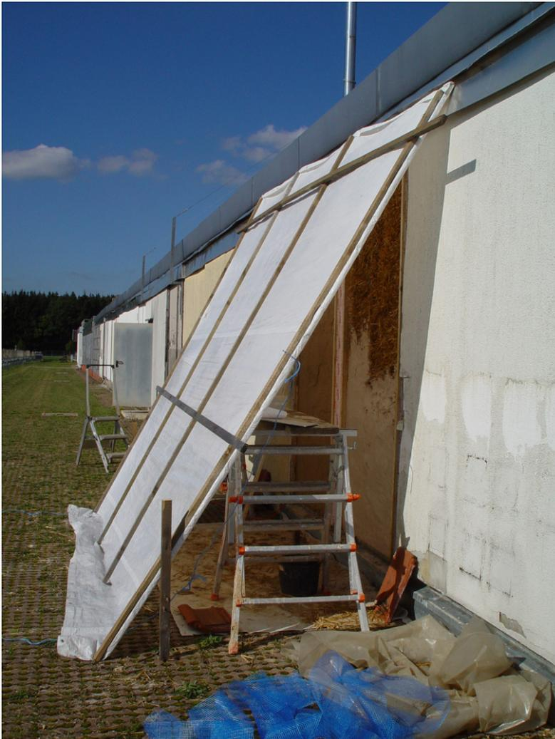
Bild 10-9: Wetterschutz während der Putzarbeiten.
