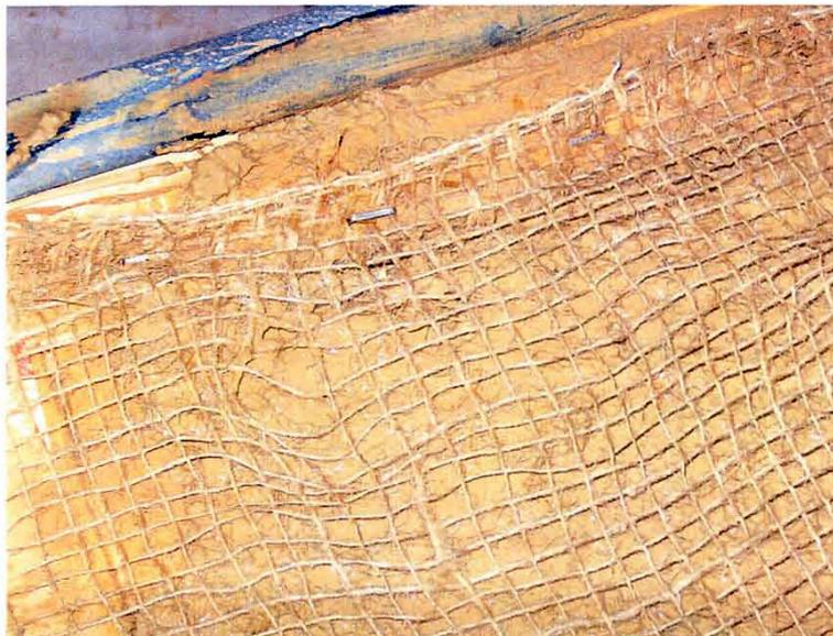
Bild 5: In eine erste Lage Lehmputz wird das Gewebe eingebracht und am Holzrahmen mittels Heftklammern befestigt.
