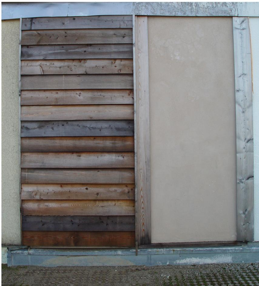
Bild 10-13: Mit Lärchenholz verschalte Versuchswand im Juni 2007.
