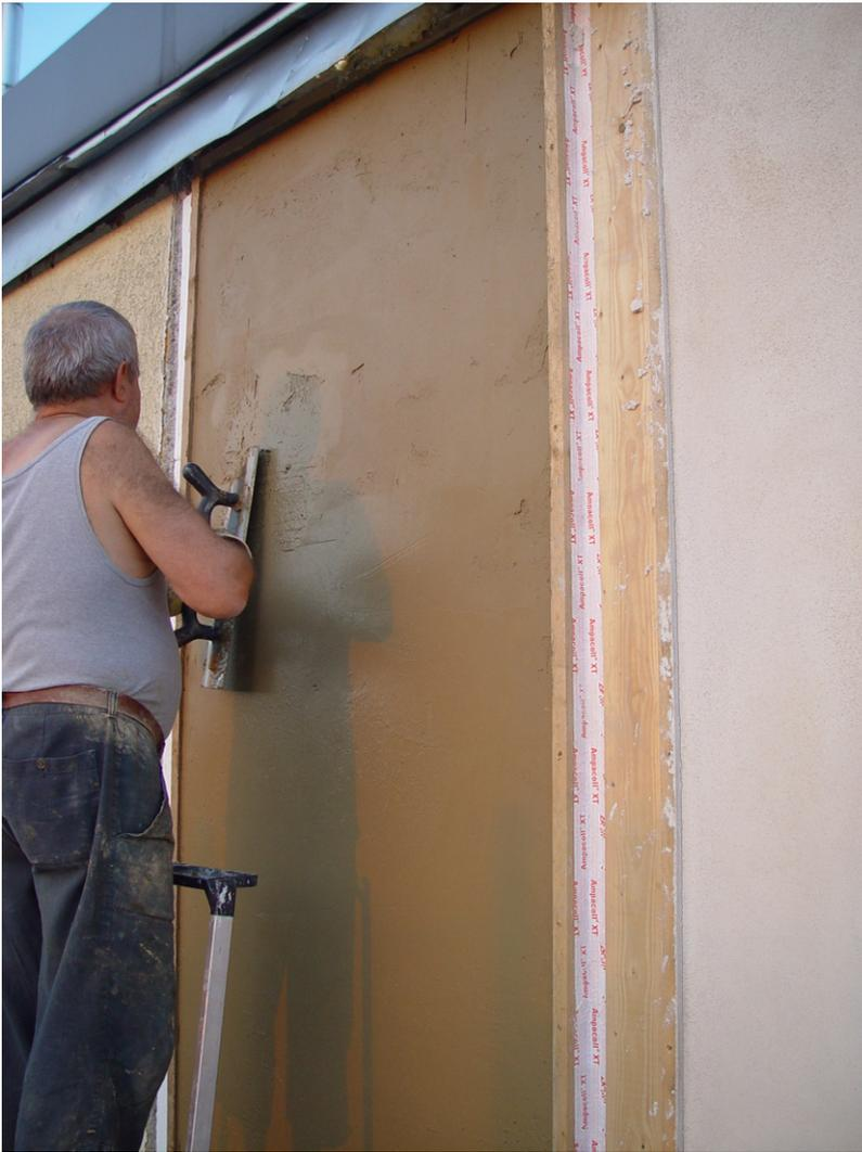
Bild 10-8: Auftragen der letzten Lehmputzschicht außen.
