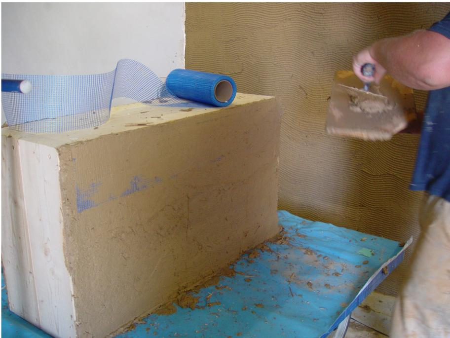
Bild 10-10: Muster vom Wandaufbau zur Durchführung von Probennahmen.
