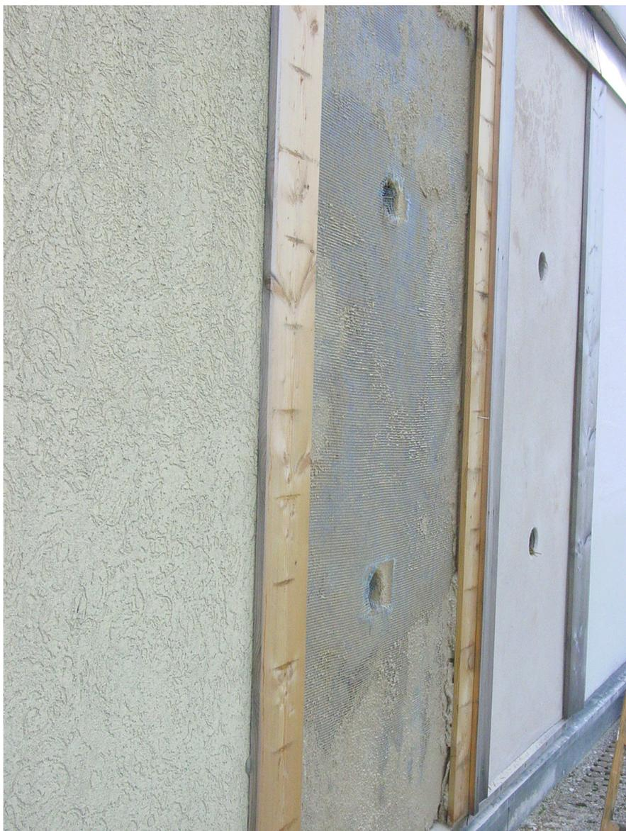
Bild 10-15: Probennahme aus der Strohballenversuchswand
