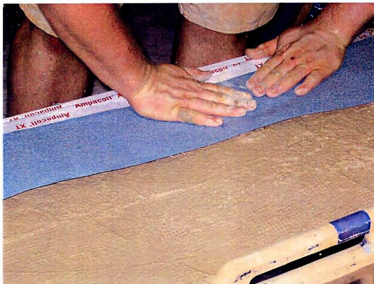
Bild 6: Nachdem das Gewebe mit einer weiteren Schicht Lehmputz bedeckt wurde, wird das mit dem Klebeband befestigte Windpapier umgeklappt und angedrückt.
