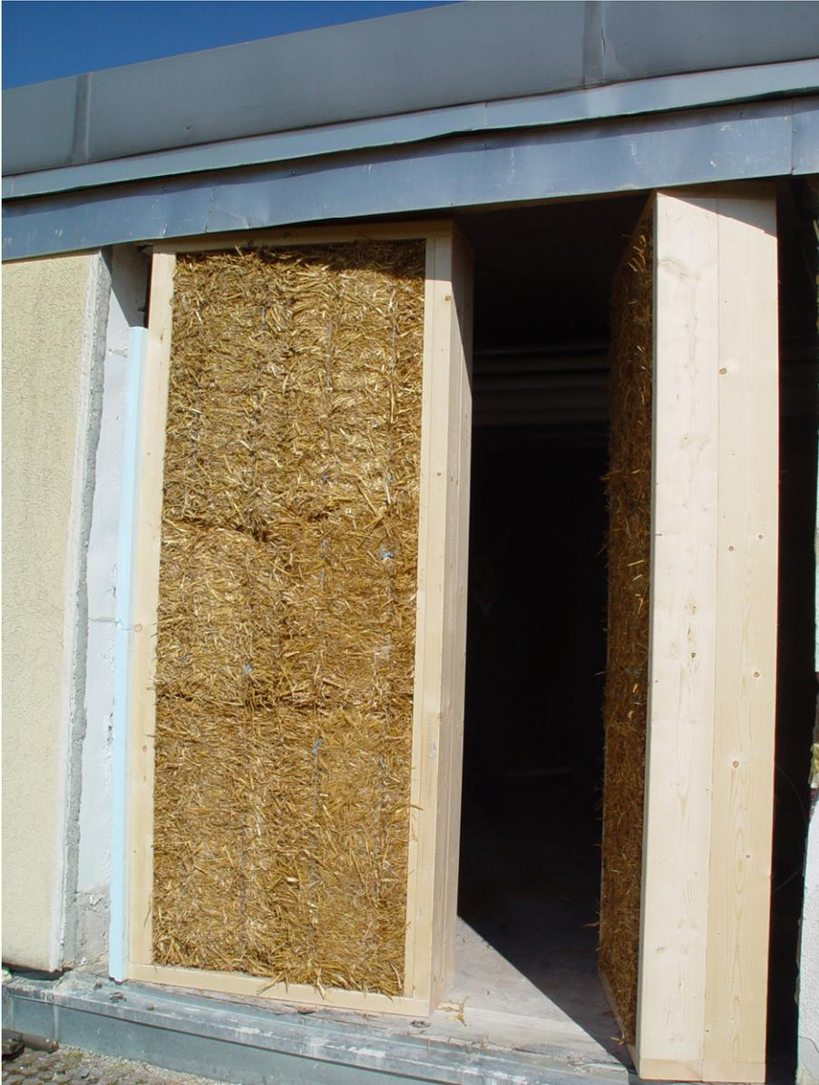
Bild 10-4: Holzrahmen mit Strohballendämmung beim Einbau in das Versuchsgebäude.
