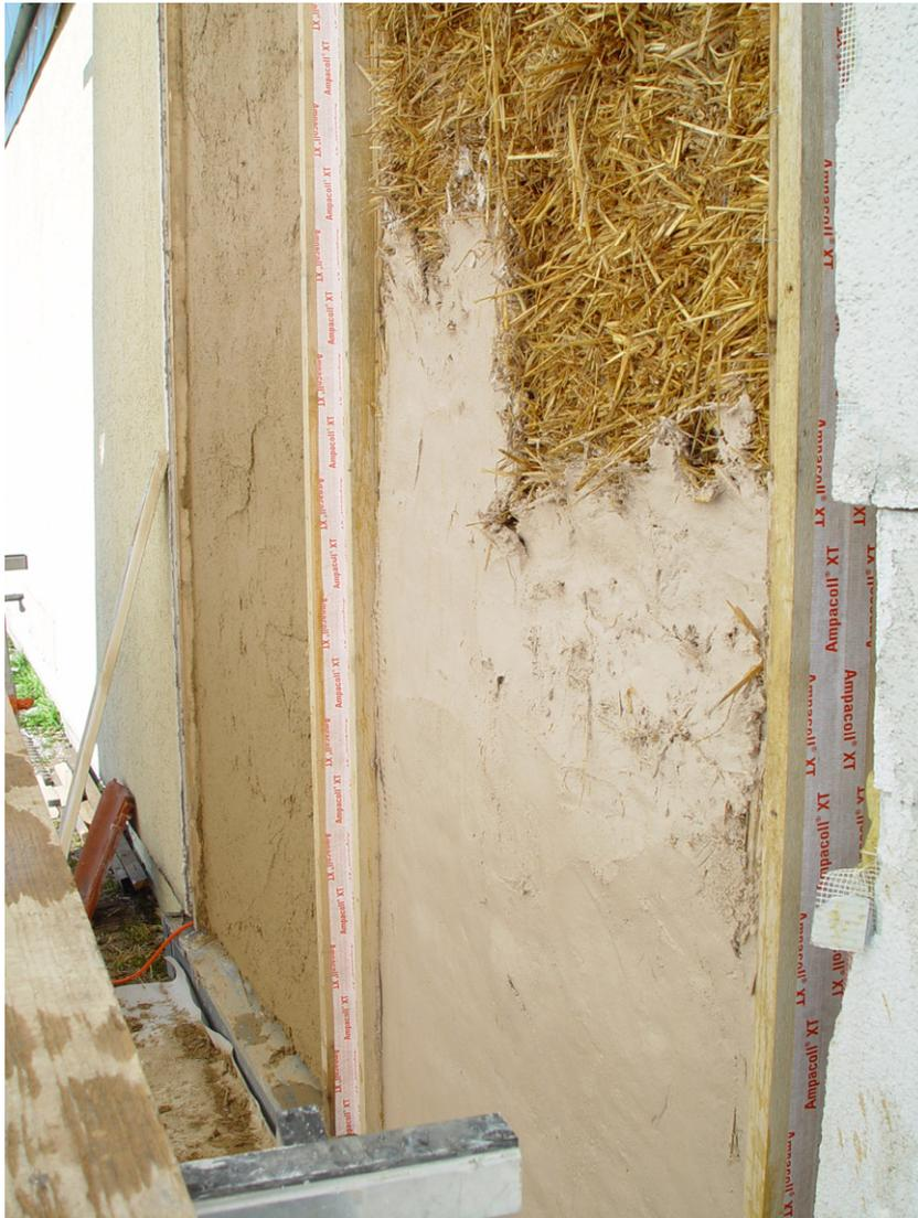
Bild 10-7: Aufbringen der ersten Kalkputzschicht außen.
