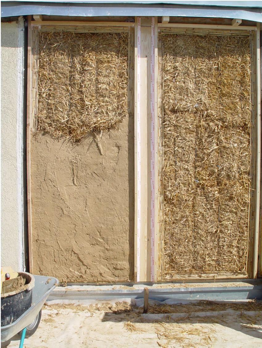
Bild 10-6: Aufbringen der ersten Lehmputzschicht außen.
