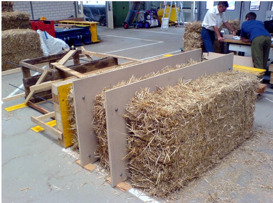
Abbildung 4-2: Wandelement I beim Zusammenbau; Schablonen zwischen den Strohballen
