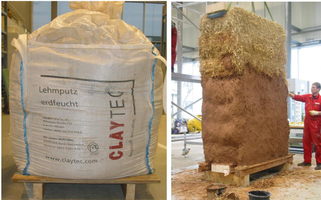
Abbildung 5-1: Verwendeter Lehmputz, manueller Auftragung der ersten Putzschicht
