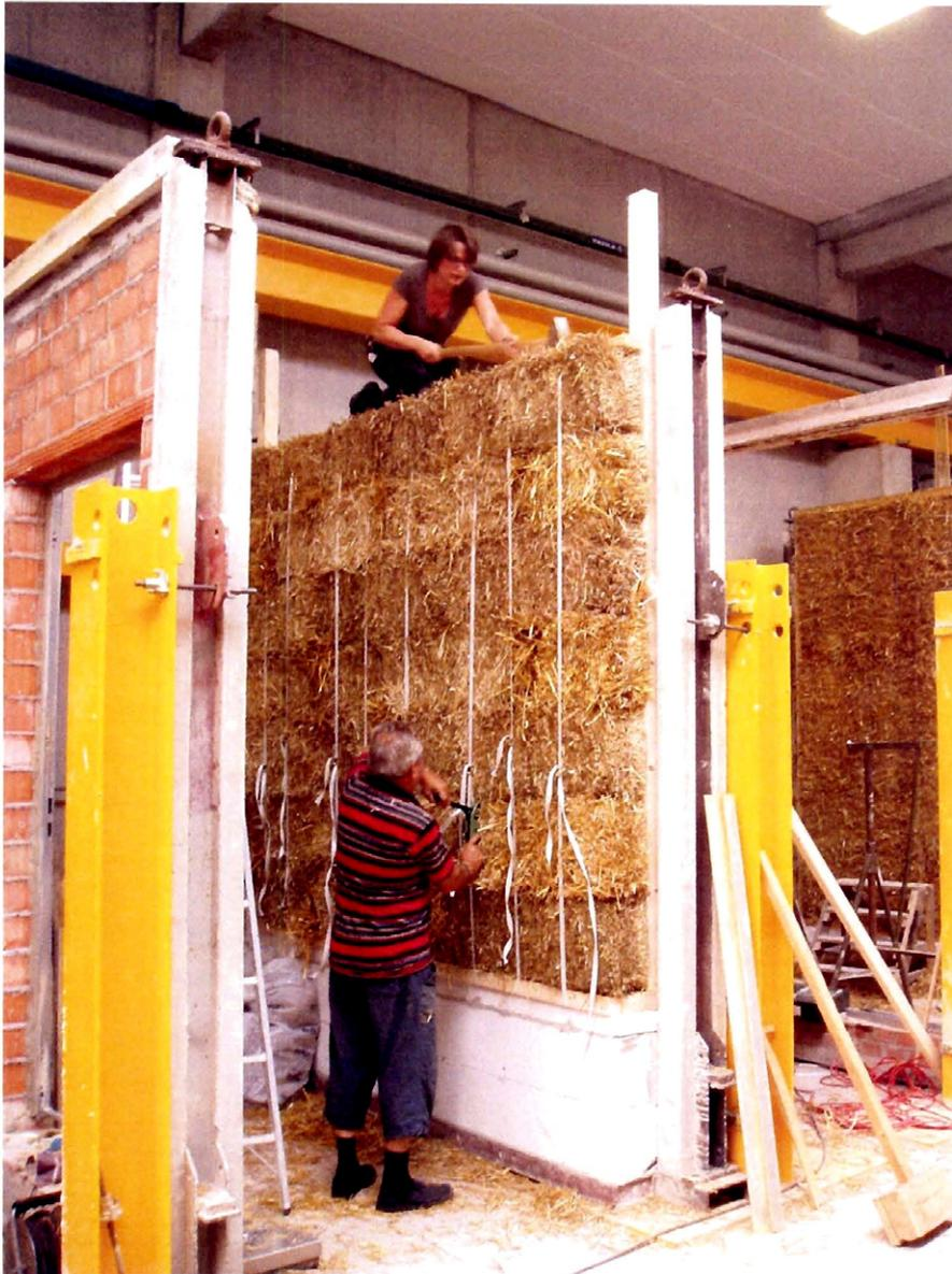
Abb. 1: Wand während des Aufbaues (Komprimierung)
