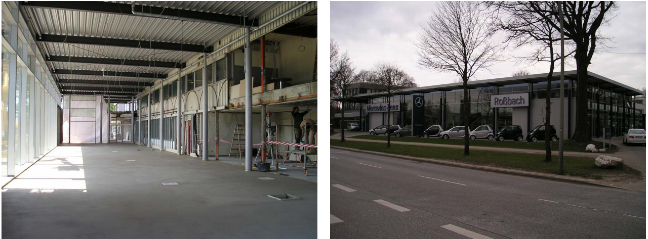
Abbildung 4: Präsentationsraum des Autohauses Roßbach während der Bauphase und nach Fertigstellung
