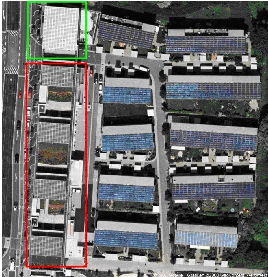
Abb. 13: Solarstromanlagen in der Solarsiedlung
