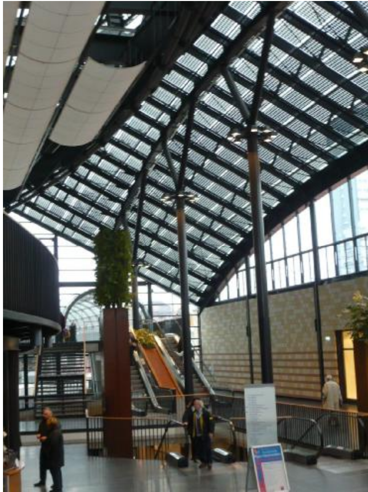
Abbildung 39: Fertiggestellte glasintegrierte PV-Anlage im Dach der „Plaza“ erzeugt elektrischen Strom und übernimmt Sonnenschutzfunktion
