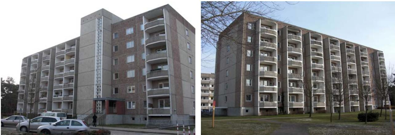
**Abb. 30:** Spendergebäude der Typenserie WBS 70 mit Mittelgangerschließung (Templin)
