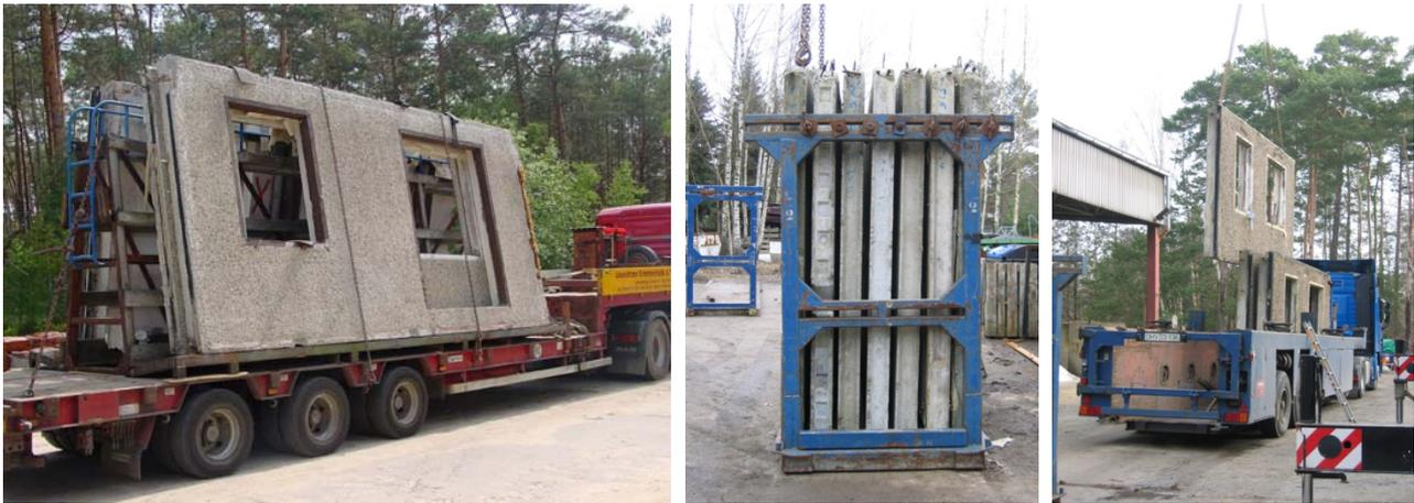
**Abb. 4:** Wandtransport mittels Schrägbockgestell (li.) oder Kassetten für den Innenlader-Transport (mi. / re.)
