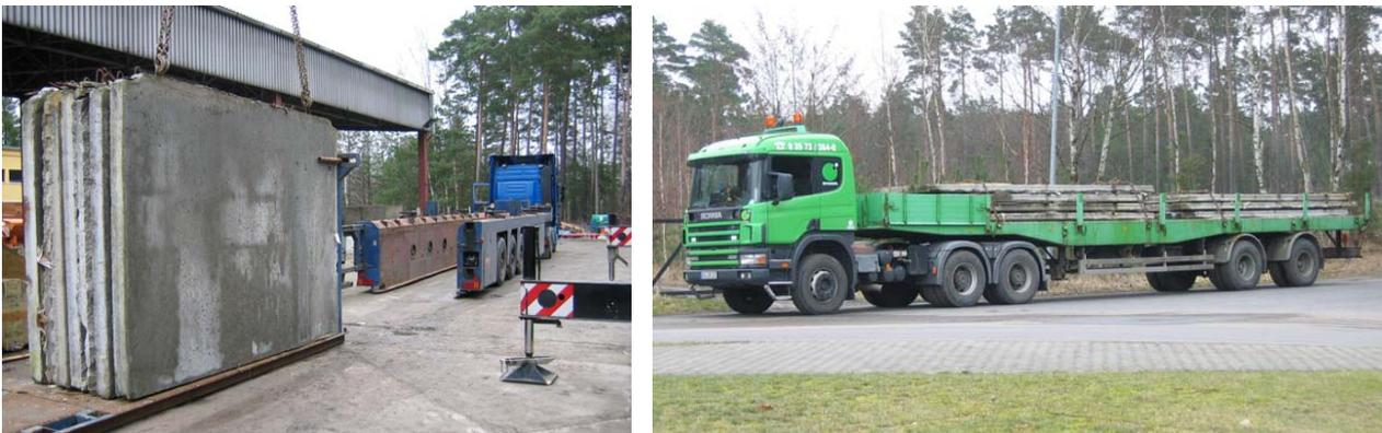
**Abb. 3:** LKW-Transport – Wandtransport mit Innenlader und Kassetten (li.), Deckentransport (re.)
