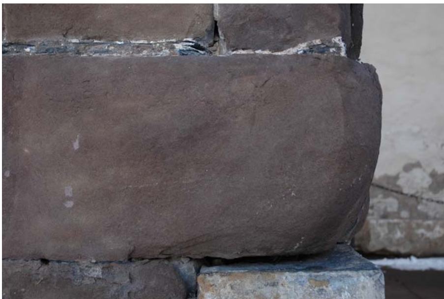
Bild 4-4: Absandungen an einem Bossenquader aus Lettenkohlsandstein
