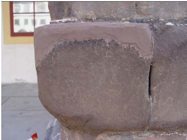
Bild 6-10: Nach Westen exponierte Fläche des Pfeilers TF-3: Oberflächenformulierung nach dem Antrag des Steinerfüllungsmörtels an einer zurückgewitterten Steinkante
