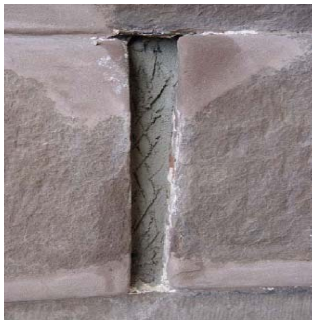
Bild 6-13: Nach Süden exponierte Fläche des Pfeilers TF-3: Neue Tiefenverfugung mit Oberflächenstrukturierung für eine gute Anbindung der Deckverfugung
