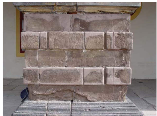
Bild 6-9: Nach Westen exponierte Fläche des Pfeilers TF-3: Zustand nach dem Abschluss der Ober- flächenformulierung mit Steinerfüllmörtel
