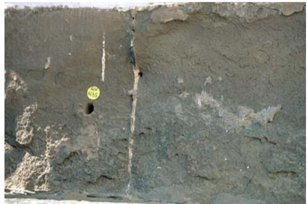
Bild 3-6: Die Fuge ist sehr schmal (etwa 0,5 cm). Auch in der Vertikalfuge sind Abstandshalter aus Schiefer eingelegt.
