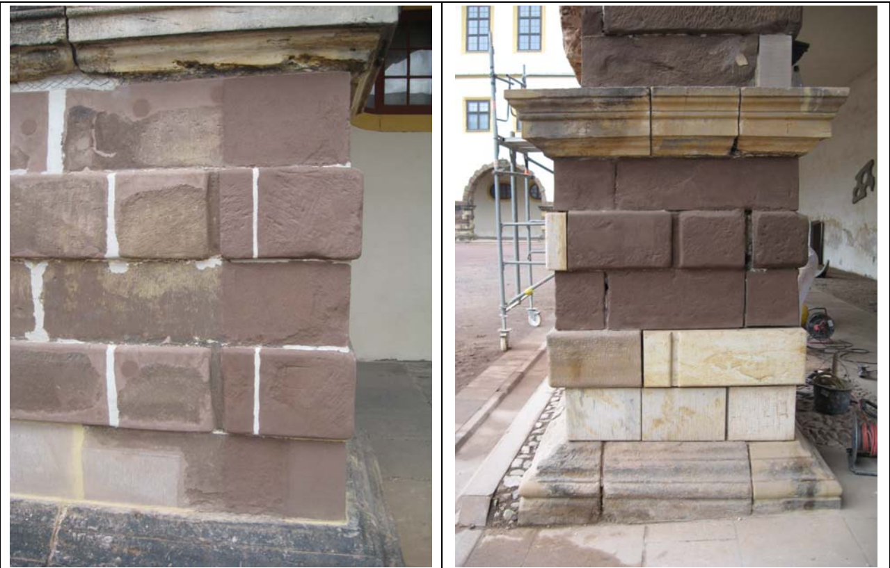
Bild 8-9 und Bild 8-10: Schlammproben an Musterpfeilern
