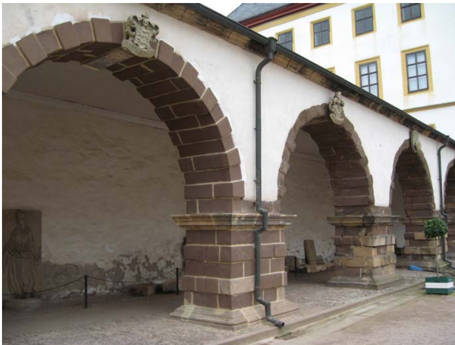
Abb. 10-1: Endzustand eines Arkadenbogens der Musterfläche (linke Bildhälfte) im Vergleich zu einem Bogen der nicht restauriert wurde (rechte Bildhälfte)
