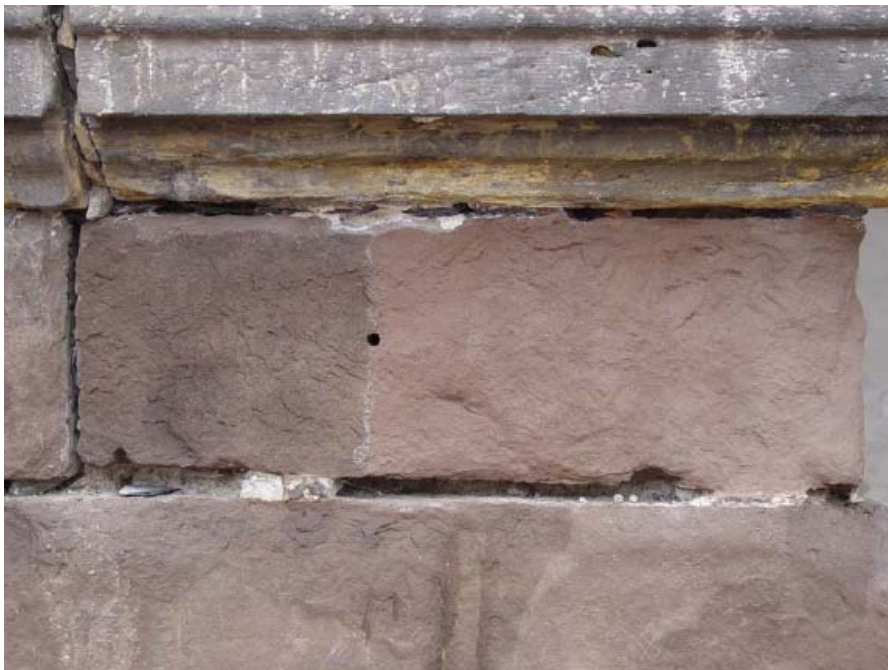
Bild 6-6: Nordseite des Pfeilers TF-2: Probefläche mit konservatorischem Oberflächenverschluss mit Schlämme
