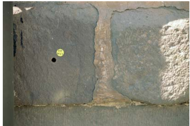
Bild 3-8: Fugenüberarbeitung mit einem hellen Mörtel. Der Mörtel ist farblich über eine Retusche auf Steinfarbigkeit abgestimmt.
