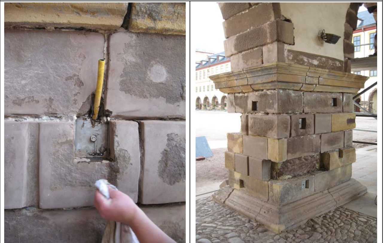
Bild 8-3: Einkleben von Mauerankern zur statischen Ertüchtigung der Pfeiler
