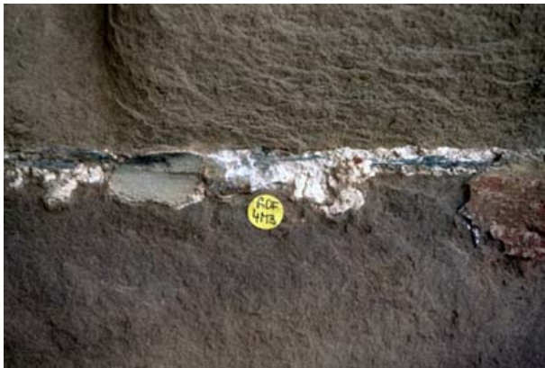
Bild 3-5: In der Fuge sind Schieferstücke als Abstandshalter eingelegt. Der Mörtel ist sehr fein und enthält kaum Gesteinskörnungen. (Durchmesser gelber Punkt 19 mm)
