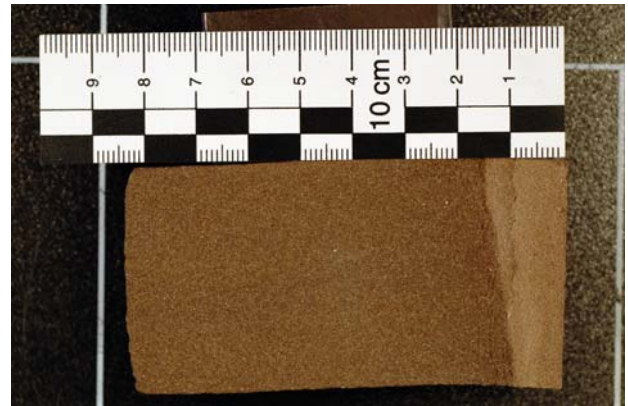
Bild 9-3: Profilschnitt des Bohrkerns BK2 von der Nordseite des Pfeilers Nr. 6
