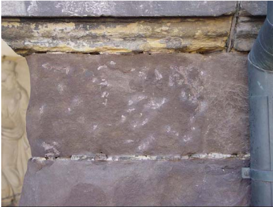
Bild 6-7: Nordseite des Pfeilers TF-2: Probefläche mit konservatorischem Oberflächenverschluss durch Anbösch (helle Stellen auf der Steinoberfläche)
