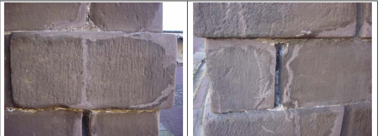
Bild 8-1 und 8-2: Steinerergänzungen und Schalenanböschungen aus Acrylatmörtel
