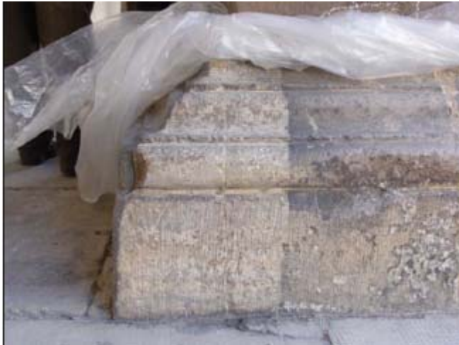
Bild 6-3: Teilbereich des Sockels auf der Nordseite des Pfeilers TF-3 nach der Reinigung mit einem Feinsandstrahlgerät
