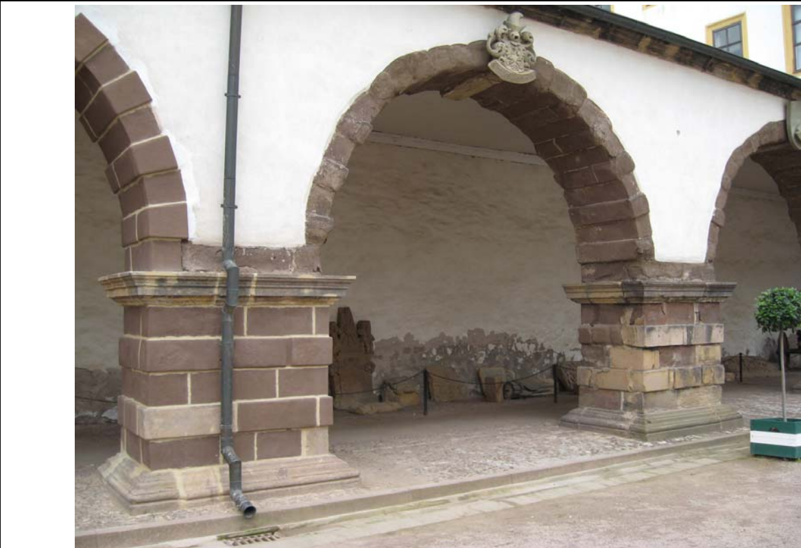
Bild 8-11: Endzustand eines Arkadenbogens der Musterfläche nach der Verlegung (linke Bildhälfte) im Vergleich zu einem Bogen der nicht restauriert wurde (Bildmitte und rechts)
