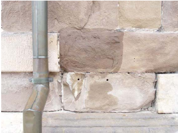
Bild 6-4: Nordseite des Pfeilers TF-2 mit einer Probefläche unmittelbar nach der Festigung mit KSE 300 E
