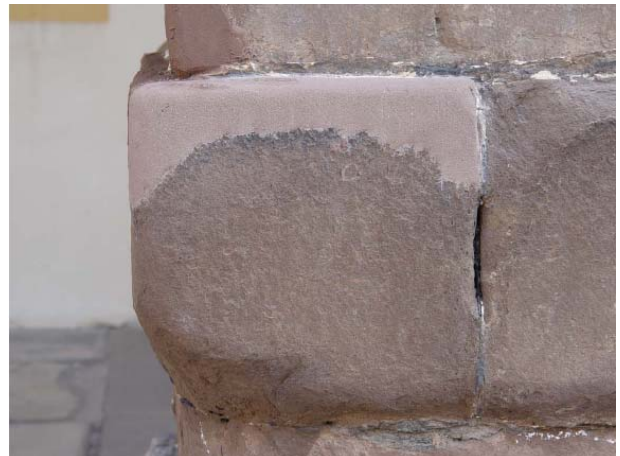
Bild 6-11: Nach Westen exponierte Fläche des Pfeilers TF-3: Steinkante nach dem Anpassen der Oberflächen des Steinerfüllungsmörtels an den ursprünglichen Bestand
