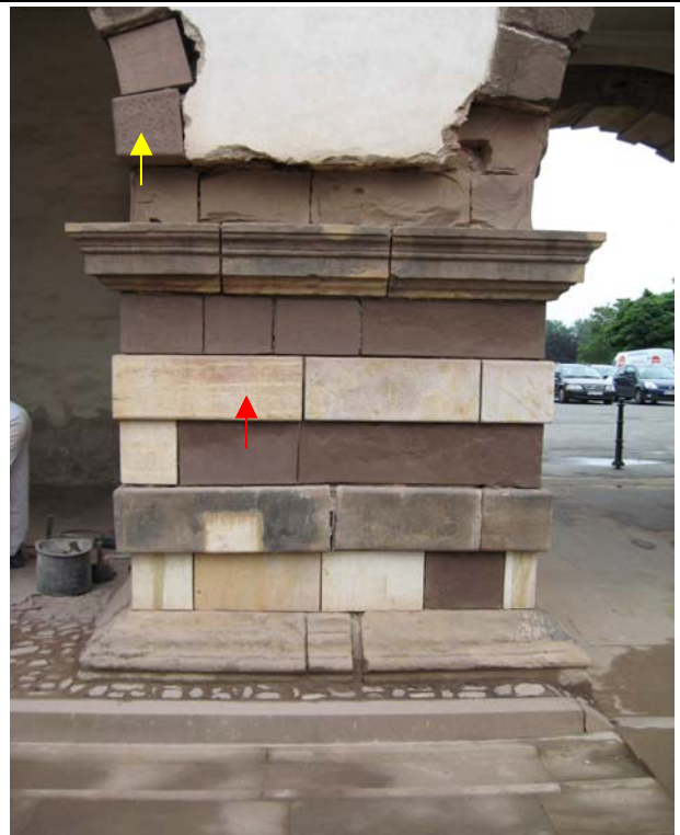
Bild 8-8: Vierungen aus Freudenbacher Lettenkohlendstein (gelber Pfeil) und Seeberger Sandstein (roter Pfeil)
