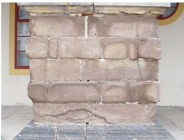
Bild 6-8: Nach Westen exponierte Fläche des Pfeilers TF-3: Vorzustand vor Oberflächenformulierung mit Steinerfüllmörtel
