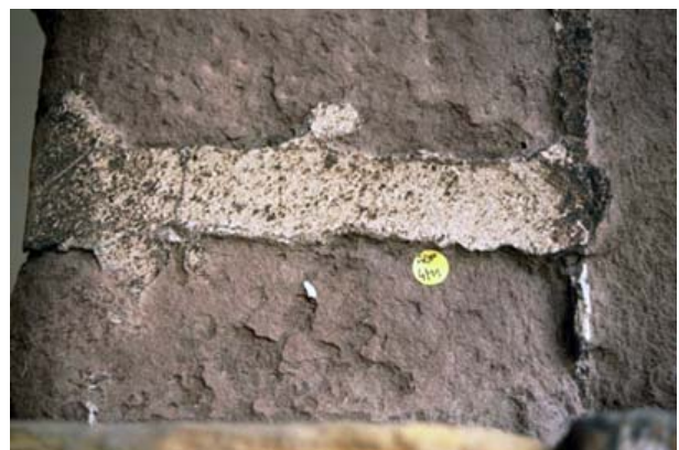
Bild 3-8: Fugenüberarbeitung mit einem hellen Mörtel. Der Mörtel ist farblich über eine Retusche auf Steinfarbigkeit abgestimmt.
