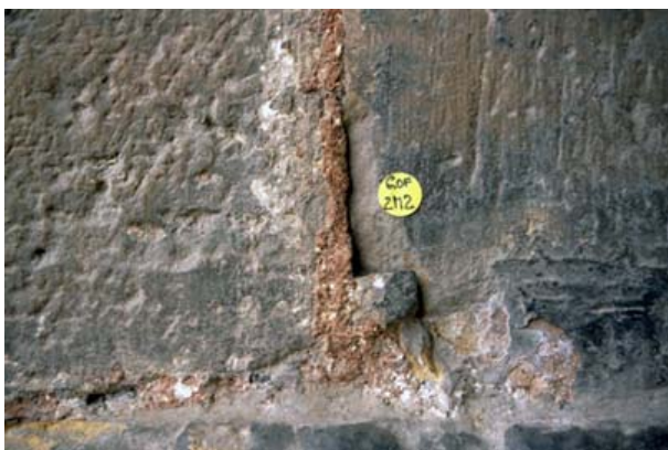
Bild 3-7: Fugenüberarbeitung mit einem sehr dunklen, dichten, hydraulisch gebundenen Mörtel. (Durchmesser gelber Punkt 19 mm)
