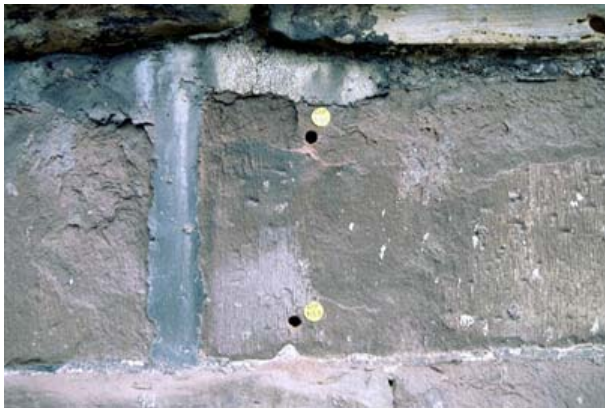
Bild 3-7: Fugenüberarbeitung mit einem sehr dunklen, dichten, hydraulisch gebundenen Mörtel. (Durchmesser gelber Punkt 19 mm)
