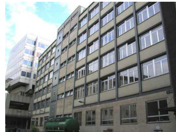
Abbildung 221 Schering AG Berlin Gebäude M 085
