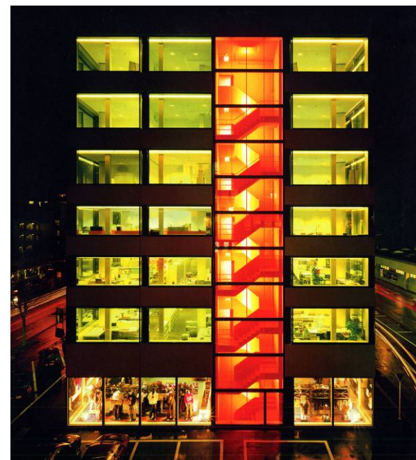
Abbildung 357 Ansicht nach der Sanierung (Quelle: Baumeister 6/03)
