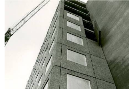
Montage Fassadenplatten 1968 (Quelle: Fotos BGG)
