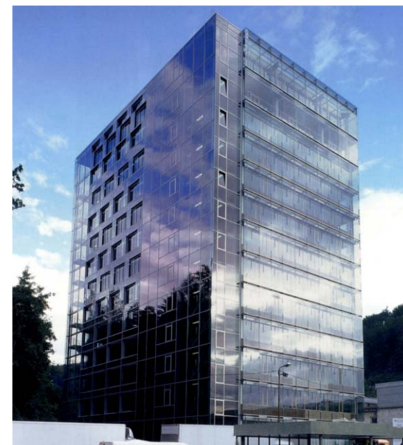
Abbildung 361 nach der Sanierung (Quelle: Baumeister 6/03)
