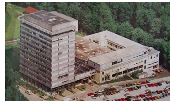
Abbildung 360 vor der Sanierung (Quelle: Glas 6/2003)
