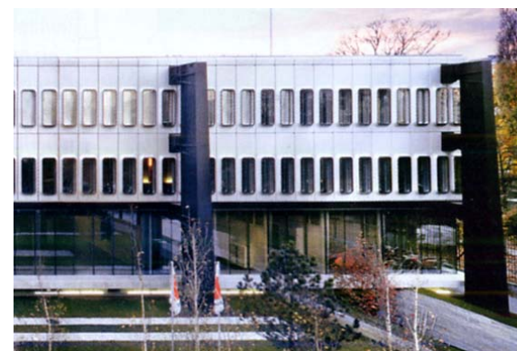
Abbildung 365 nach der Sanierung (Quelle: Bauwelt 3/06)
