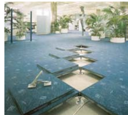
Abbildung 96 Zugänglichkeit Doppelboden
