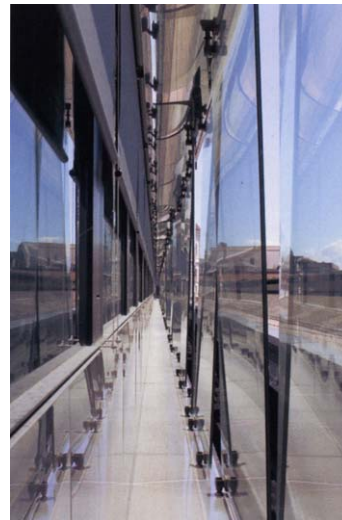
Abbildung 339 Doppelfassade + Sonnenschutz 01 (Quelle: Quelle: werk, bauen und wohnen 11/05)
