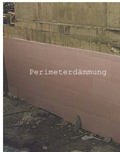
Abbildung 173 Montage der Perimeterdämmung ( www.greenpeace-stuttgart.de )
