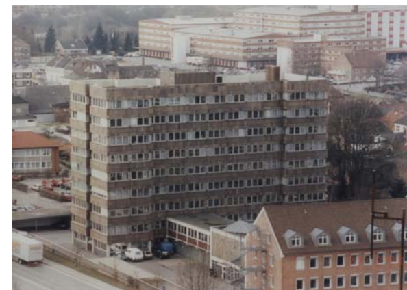
Abbildung 353 vor der Sanierung (Quelle: Baumeister 6/03)
