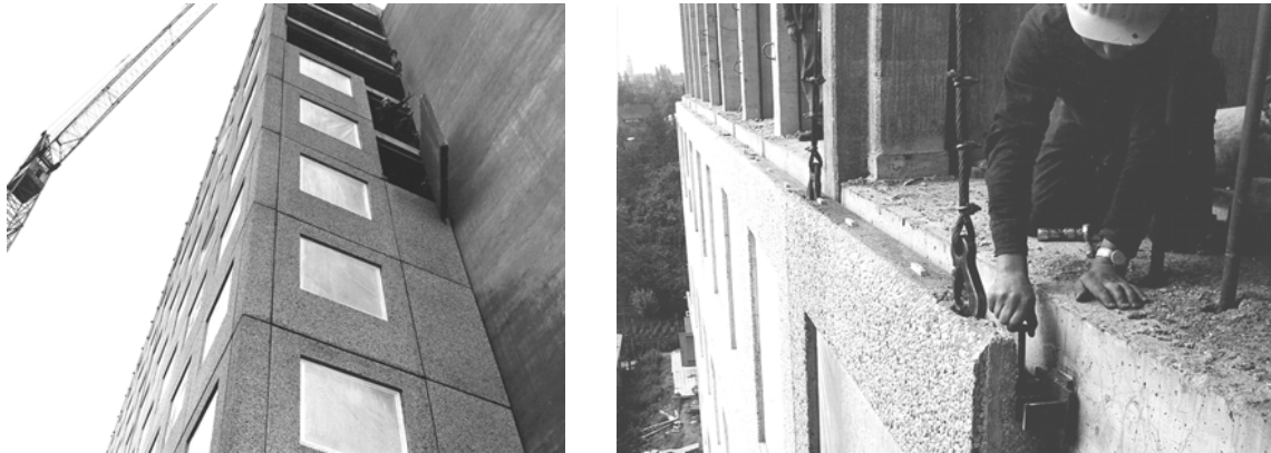
Abbildung 148 BBG Braunschweig - Betonfertigteile als vorgehängte Elementfassade (Quelle: BBG)
