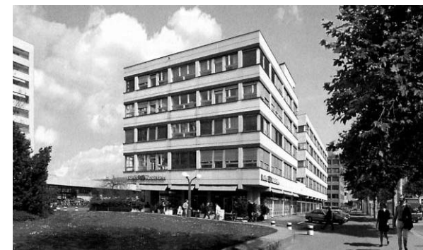
Abbildung 356 Ansicht vor der Sanierung (Quelle: Baumeister 6/03)
