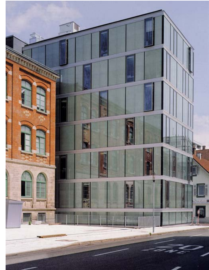
Abbildung 350 Beispiel Fassade ohne Balkon (Quelle: Glas Architektur und Technik 9/05)
