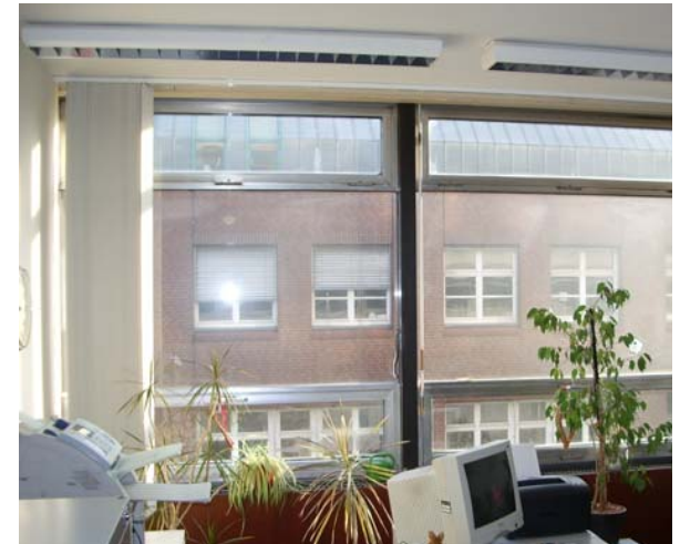
Abbildung 189 Büroraum Fenster / Blendschutz
