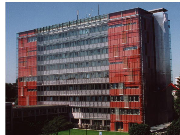
Abbildung 354 nach der Sanierung (Quelle: Baumeister 6/03)
