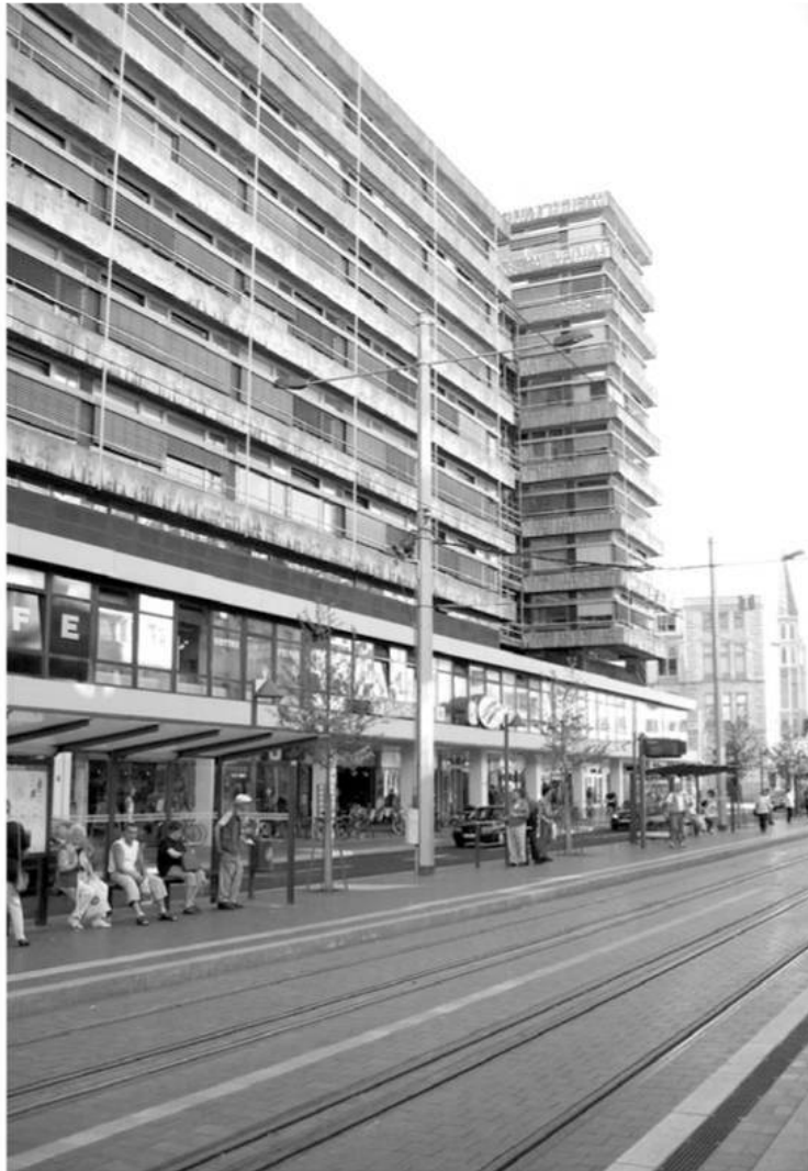
Abbildung 273 Fassade Rathaus Neubau - Bestand
