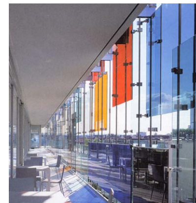
Abbildung 342 Doppelfassade + Sonnenschutz 02 (Quelle: Ark 4/05)
