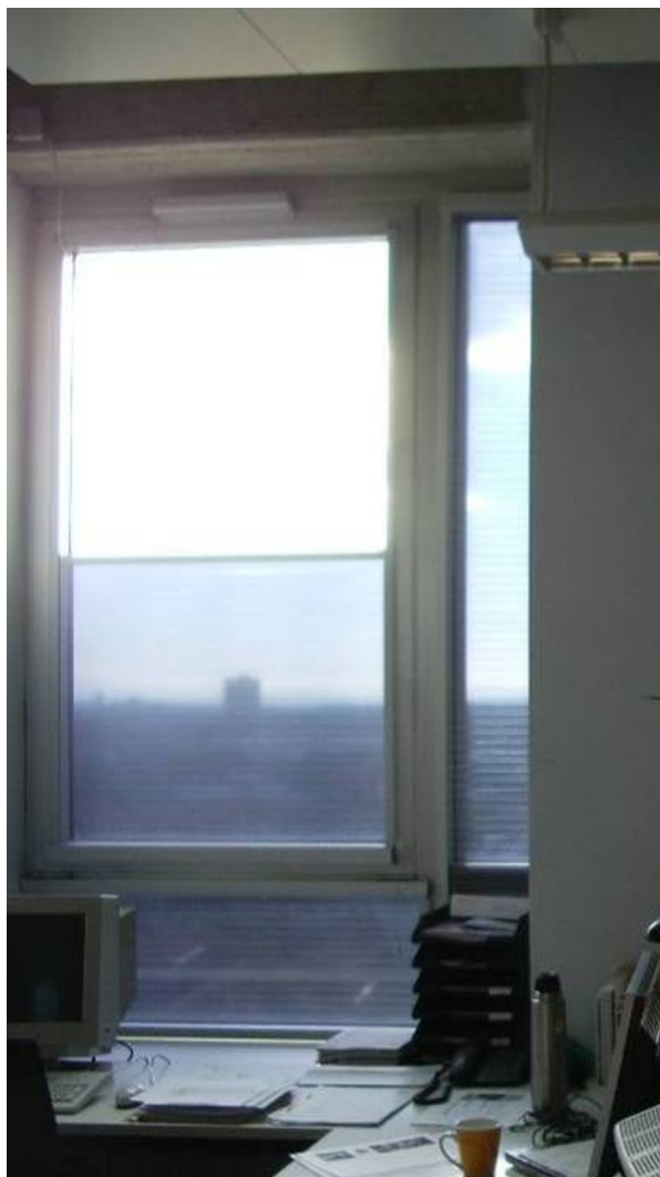
Abbildung 181 und Abbildung 182 tageslichtoptimiertes Sonnen-/Blendschutzsystem (Folie)
