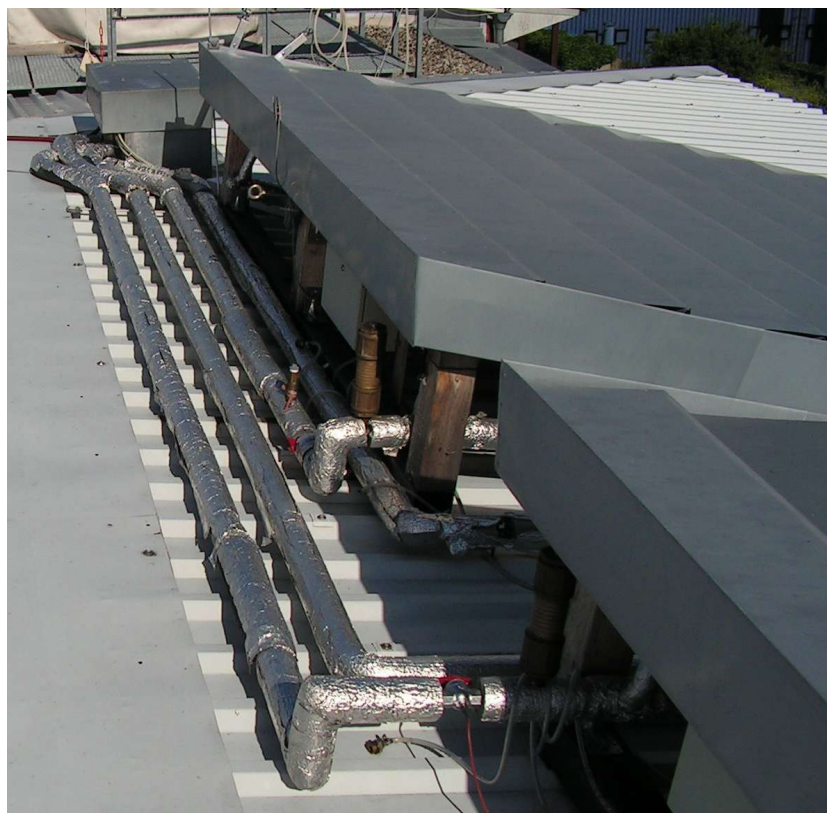
Abbildung 26: Verrohrung der beiden Kollektorfelder. Im Hintergrund: Dachdurchbruch.
