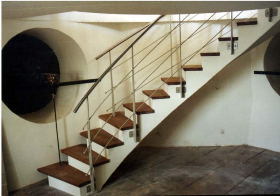
Abb. 13: Die Treppe von der Uhrenebene zur Türmerstube; die Antriebskonstruktion für die Zeiger mußte umgebaut werden.
