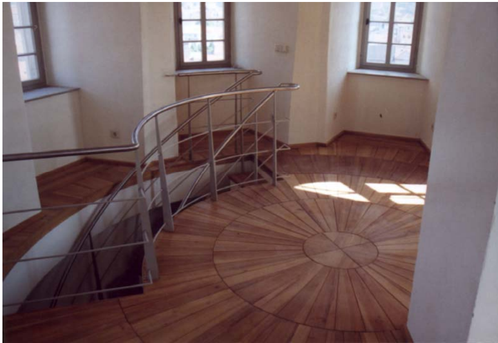
Abb. 15: Der Fußboden in der Türmerstube, Austritt des unteren Treppenlaufes
