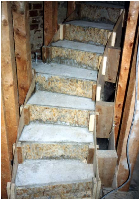
Abb. 11: Die Holzdecken und -treppen im schwammgeschädigten Bereich sind ausgebaut und werden durch Massivtreppen ersetzt
