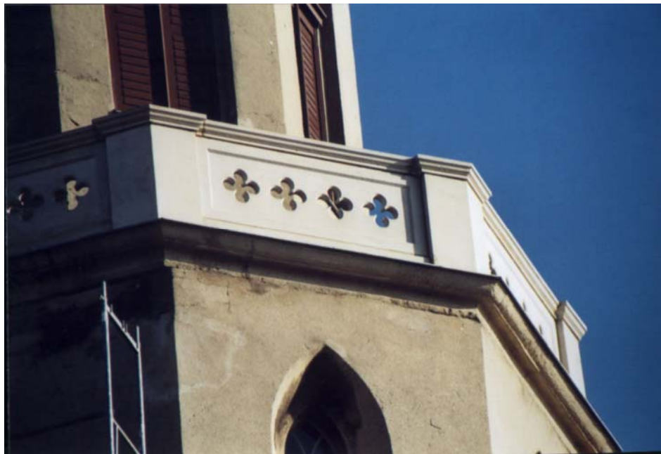
Abb. 4: Blick auf die neue Sandsteinbalustrade
