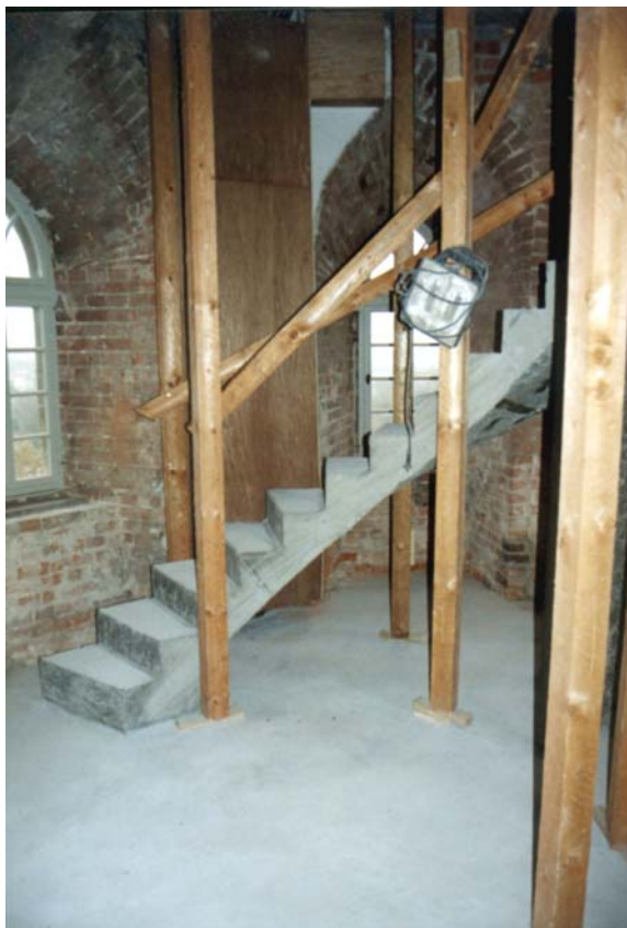
Abb. 12: Die neue Treppe von der Türmerstube zur Aussichtsplattform ist ausgeschalt
