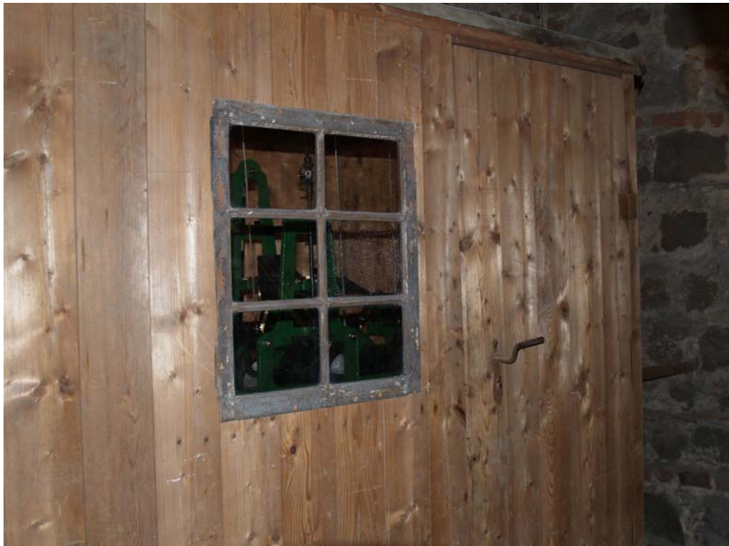
Abb. 21: In die Uhreneinhausung eingebautes Fenster zur Beobachtung des Uhrwerkes, Wiederverwendung eines alten Fensters
