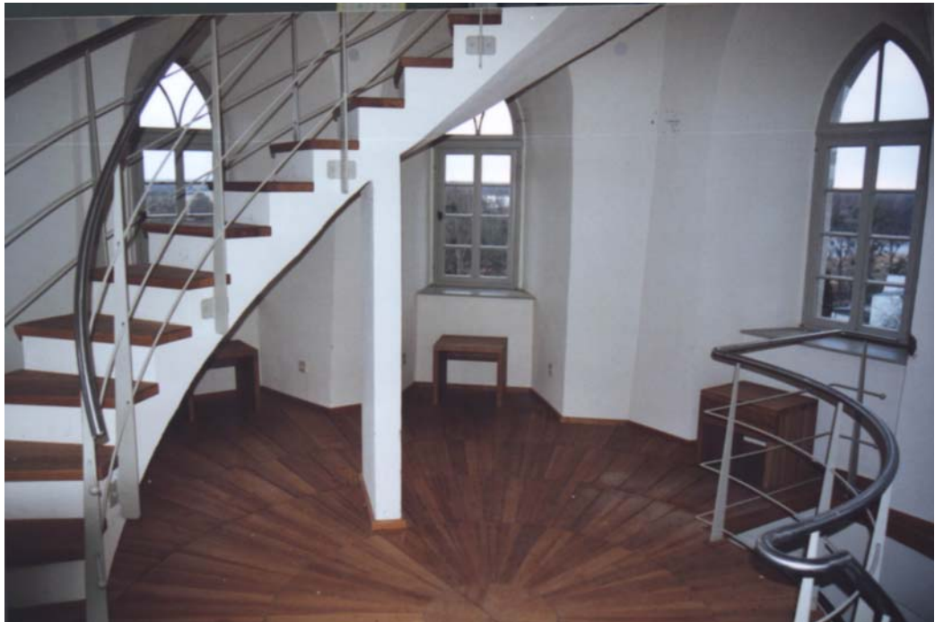
Abb. 16: Die Treppe von der Türmerstube zur Aussichtsebene (vergleiche Abb. 5 und 6!)
