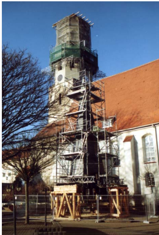
Abb. 2: Blick von Südosten, die Spitze ist zur Sanierung abgehoben worden
