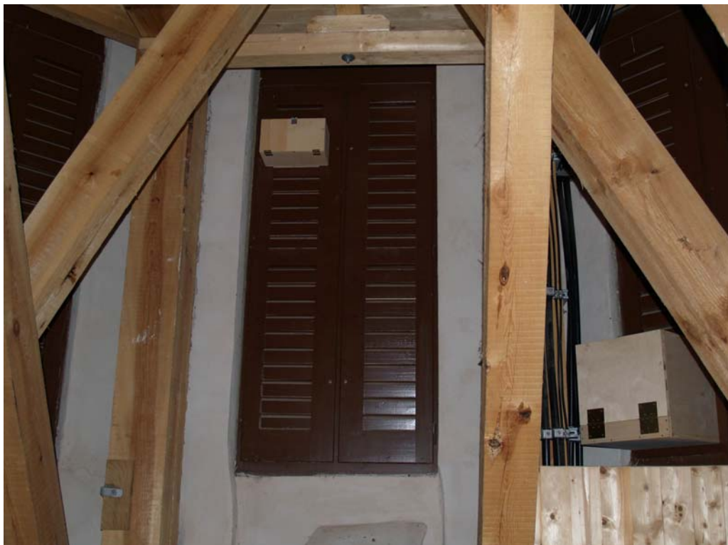
Abb. 22: Einbau von Nistkästen in der oberen Turmebene, sichtbar für die Besucher, ohne Störung für die potentiellen „Bewohner“
