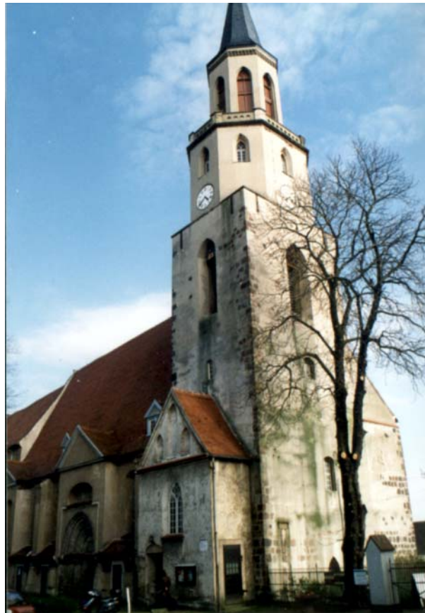
Abb. 1: Kirchturm von Nordwesten
