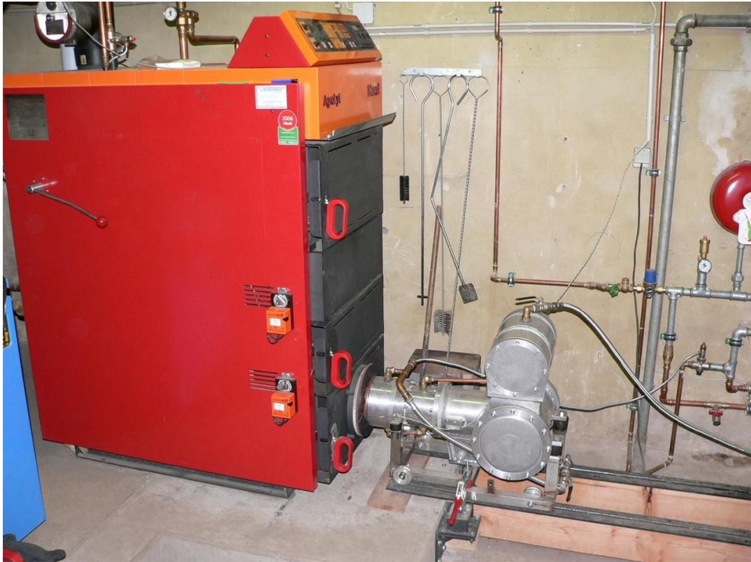
Abbildung 3: Scheitholzessel-Stirlingmotor-BHKW im Versuchsbetrieb
