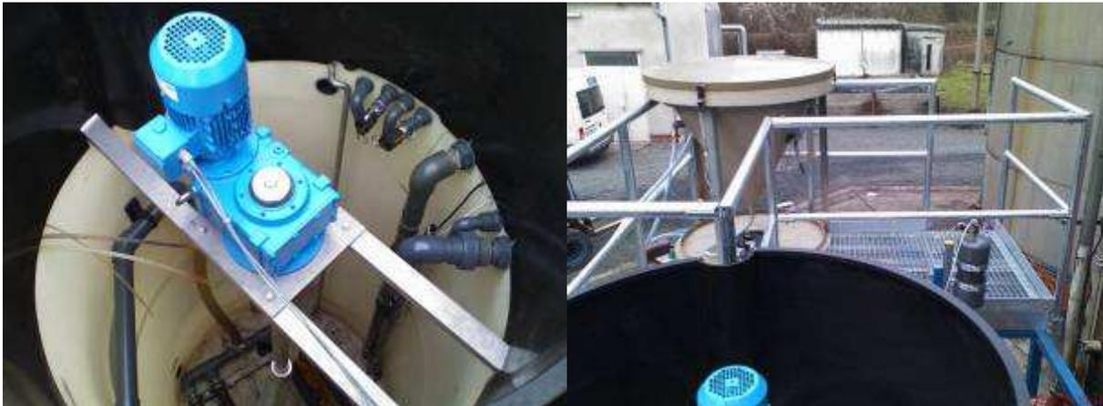
Abbildung 7-5: Links: Bioreaktor mit Rührwerk und Belüftungseinheit, Rechts: Blick vom Bioreaktor auf die Zwischenklärung
