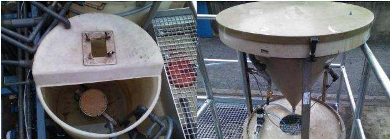
Abbildung 7-6: Links: aerobe Vorbehandlung, Rechts: Zwischenklärbecken
