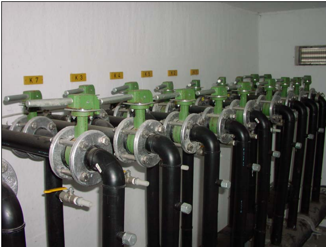
Abbildung 5-7: Gasstation der Zentraldeponie Altenberge
