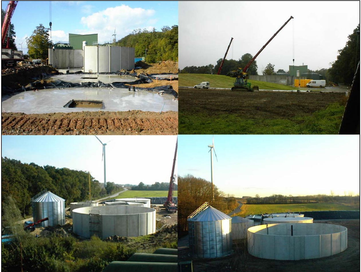
Abbildung 5-1: Fotoreihe der einzelnen Bauabschnitte der BGA
