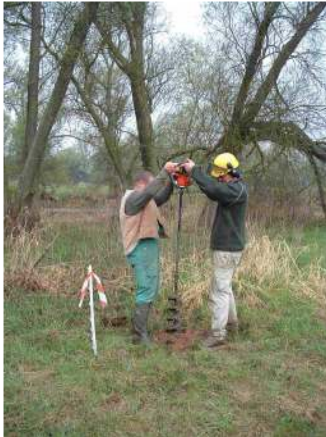
Abb. 22: Einsatz eines Pflanzlochbohrers mit Verlängerung für Setzstangen Alle Pflanzstellen wurden unmittelbar nach der Pflanzung angegossen (Abb. 23).
