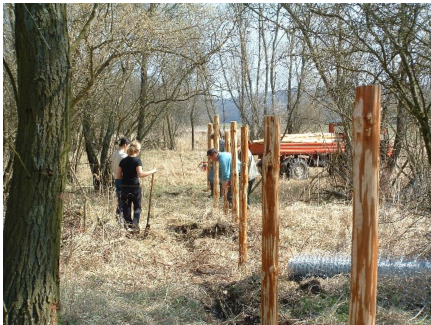
Abb. 8: Errichtung des Wildzauns
