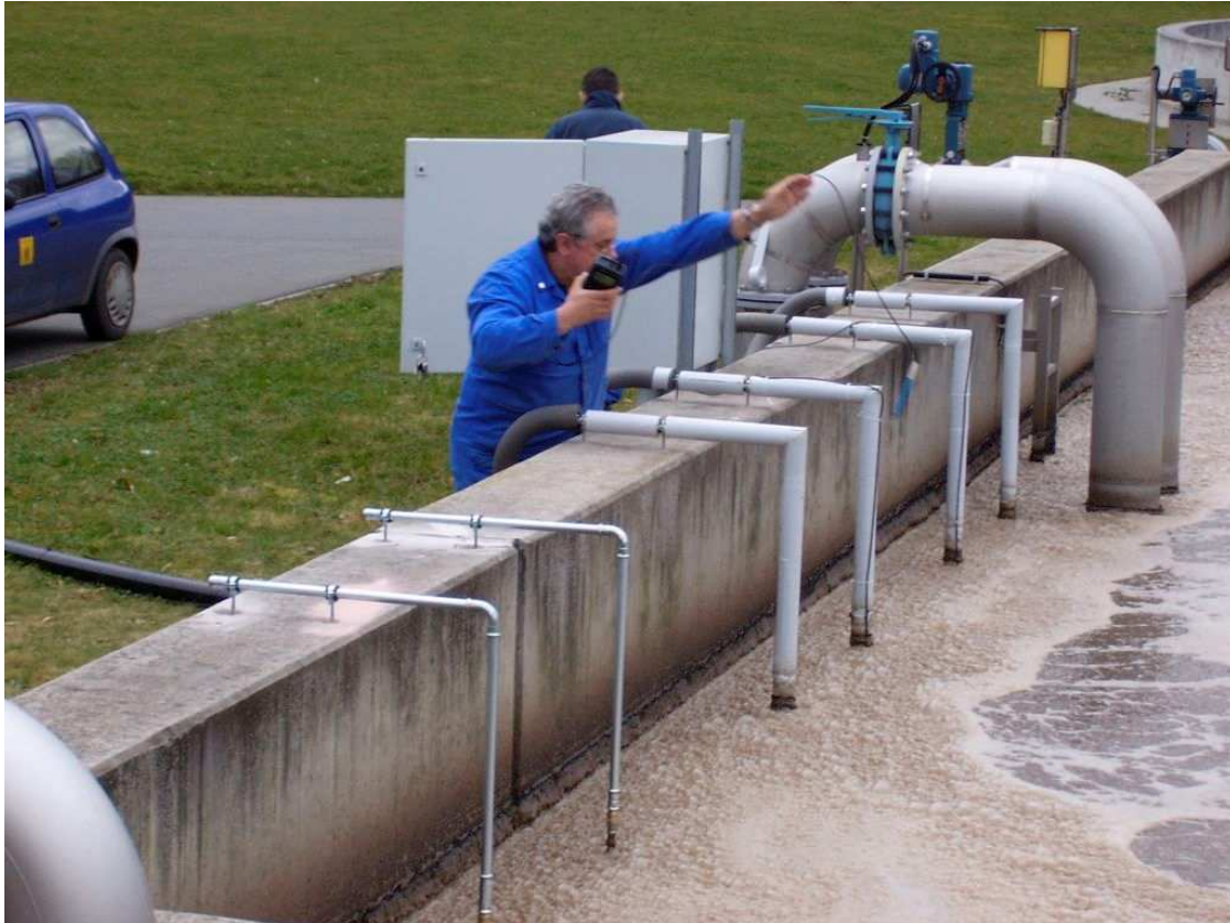
Bild 6: Ein unbeheiztes und zwei beheizte Festbetten in Betrieb
