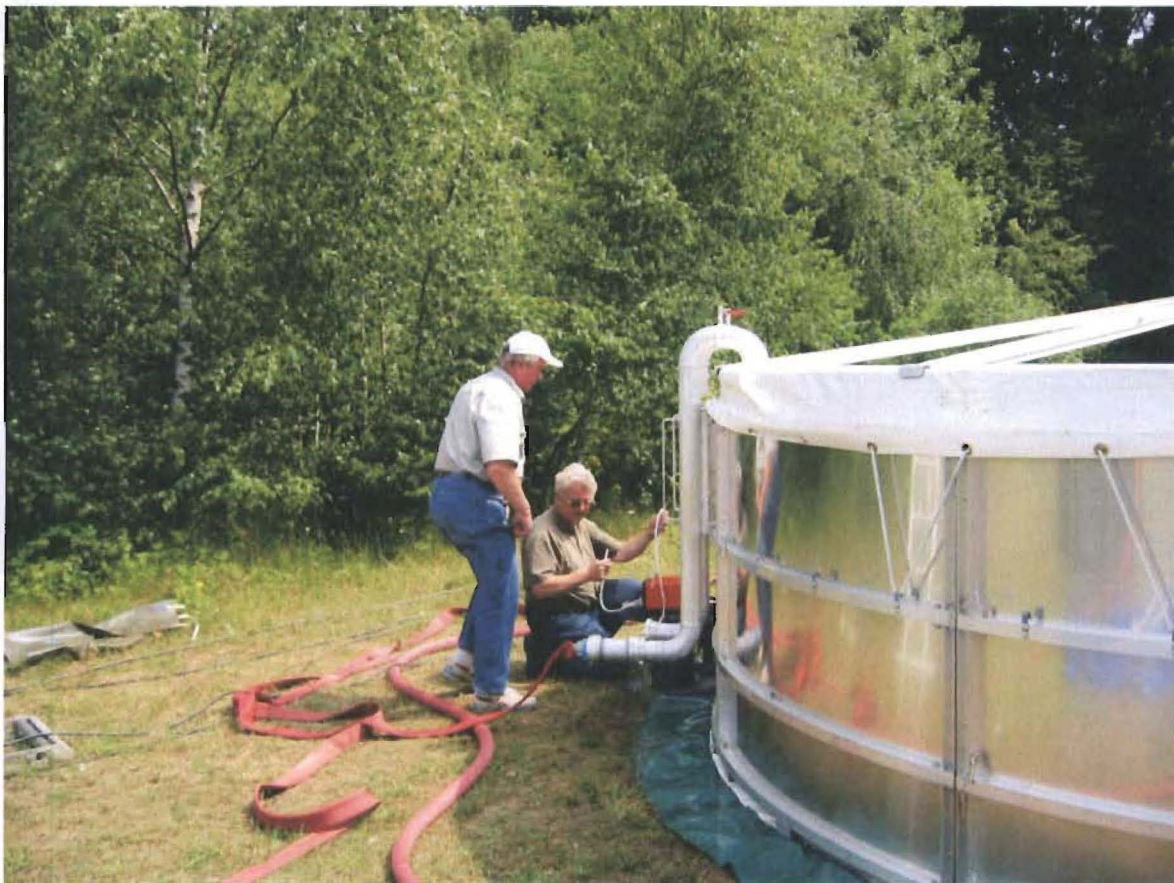
Abb. C-28: Installation Statikmischer am THW –Fällungs-/Flockungsbecken
