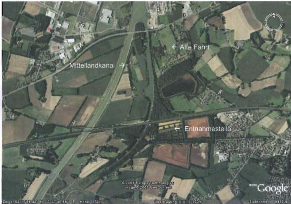
Abb. C -24 : Mittellandkanal mit der Alten Fahrt westlich von Püsselbüren
