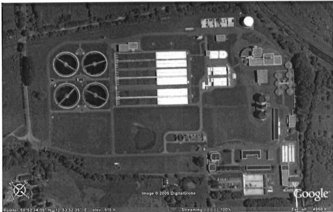
Bild 2.10 Luftbild der KA Chemnitz (Quelle: Google Earth)
