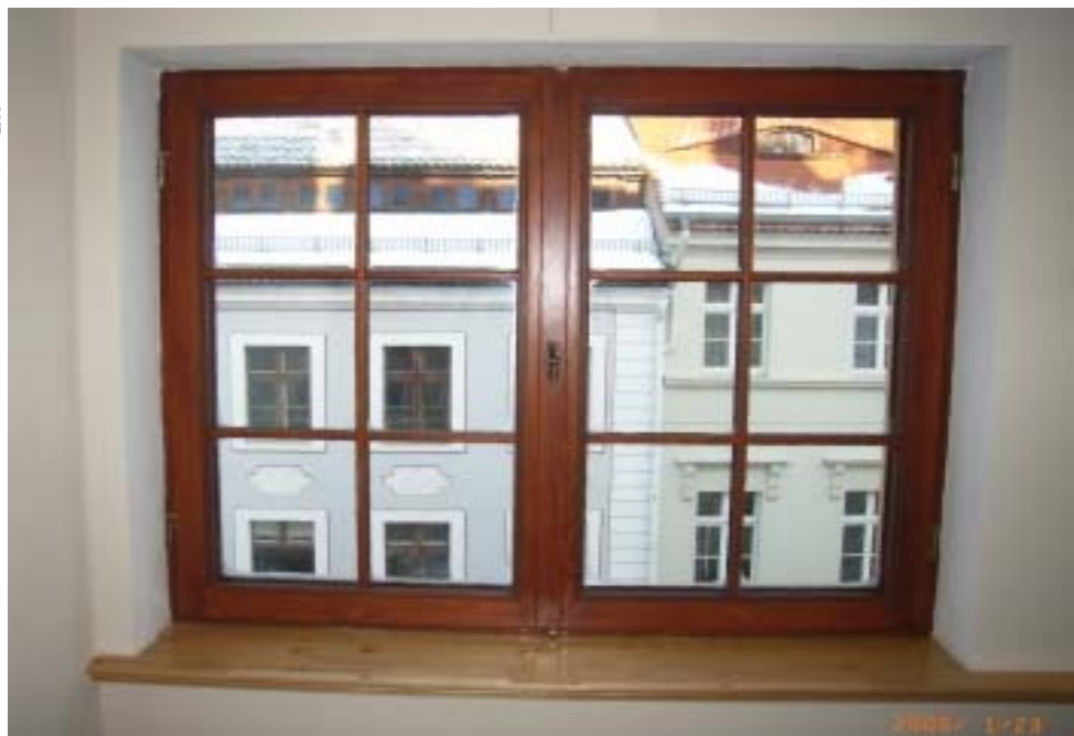
Abb. 2.3: Holz-Einfachfenster mit 3-Scheiben -Wärmeschutzverglasung aus Solarglas, Innenansicht
