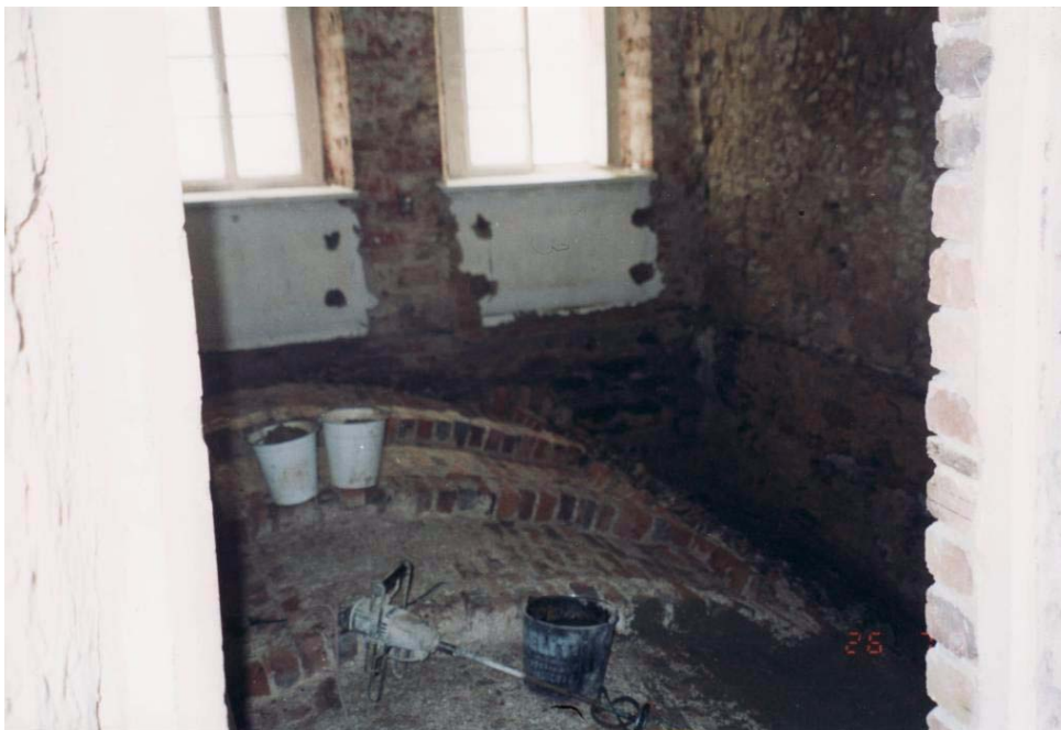
Abb. 2.25: 1. Obergeschoss, Erdgeschossgewölbe aus Bruchsteinmauerwerk und Ziegelmauerwerk mit Aussteifungsbögen beim Aufbringen des Spritzbewurfes
