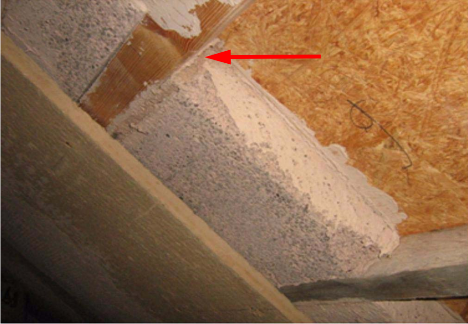
Abb. 2.42: HAACKE CELLCO®-Wärmedämmlehm-Platte (WDP) als Untersparrendämmung, Fuge mit HAACKE CELLCO®-Wärmedämmlehm (WDL), Detail
