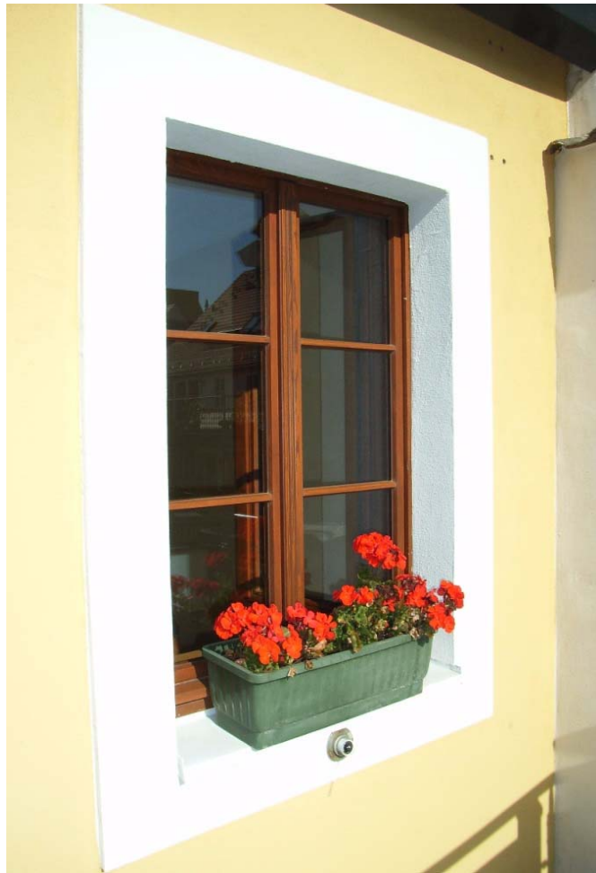
Abb. 2.20: Fenster im 1. DG Süd, Wärmedämmverbundsystem mit Mineralwolllamellen, aufgesetzten Faschen und gefilztem Putz, Beibehaltung des historischen Erscheinungsbildes; Messstrecke mit Temperaturfühler (Ntc) und Pyranometer
