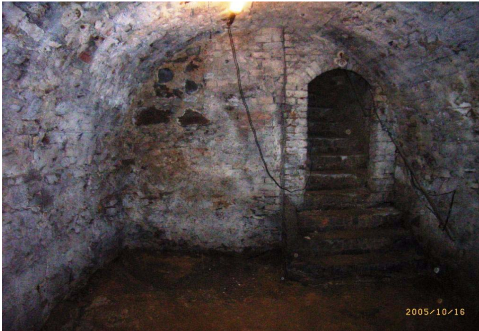
Abb. 2.24: Keller, Tonnengewölbe aus Bruchsteinmauerwerk
