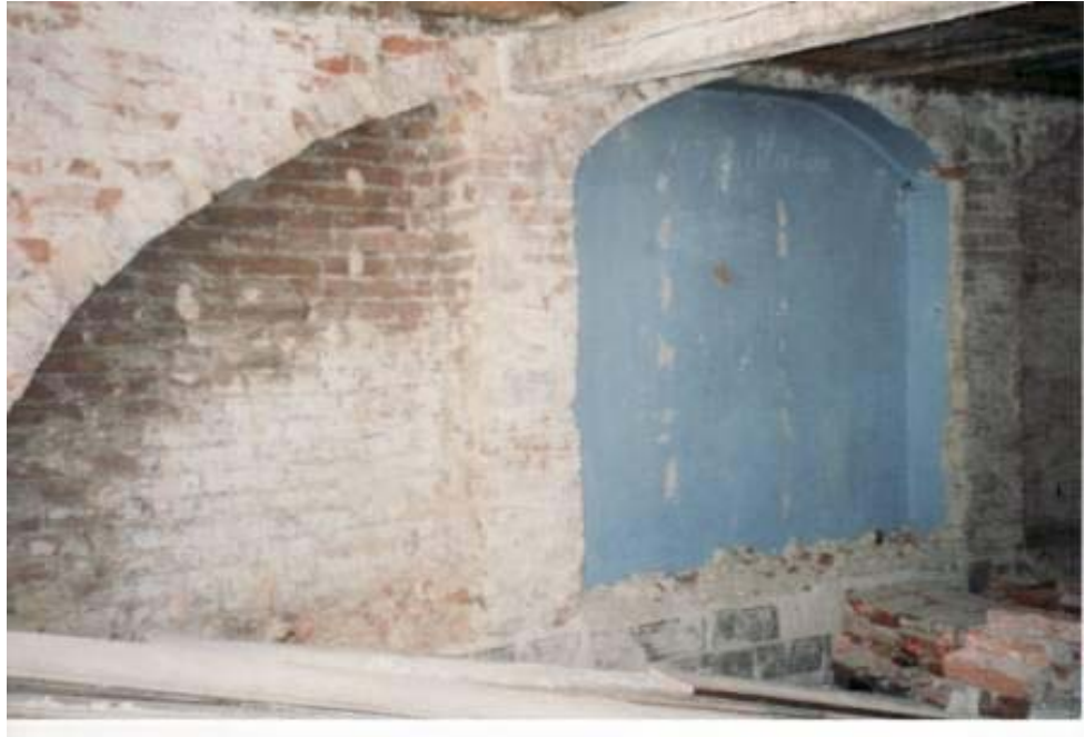
Abb. 2.12: Innenwände aus Ziegelmauerwerk im 1. Dachgeschoss
