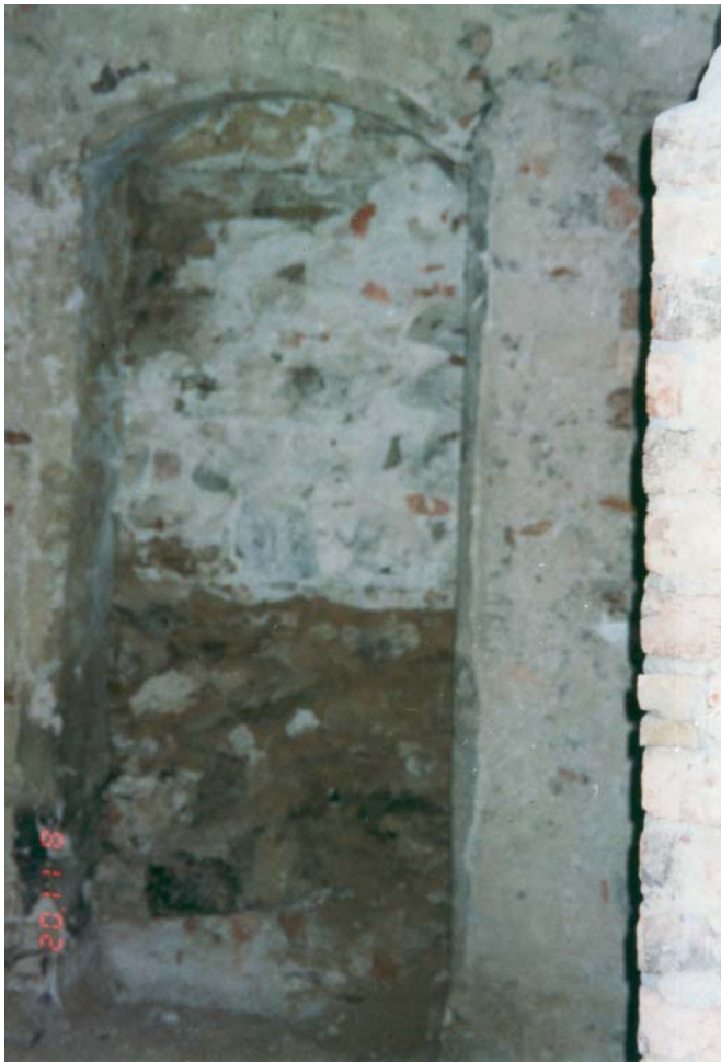
Abb. 2.11: 2. OG, Innenwände aus Mischmauerwerk, Nische zum Nachbargebäude
