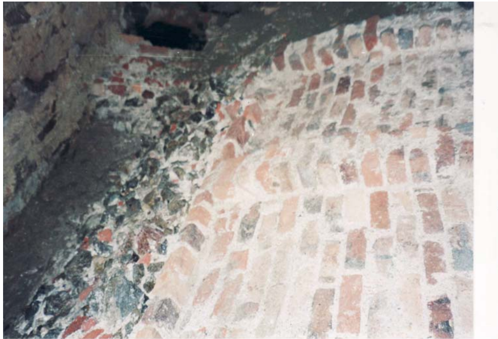
Abb. 2.26: 1. Obergeschoss, Erdgeschossgewölbe aus Bruchsteinmauerwerk und Ziegelmauerwerk mit Aussteifungsbögen vor dem Aufbringen des Spritzbewurfes, Detail
