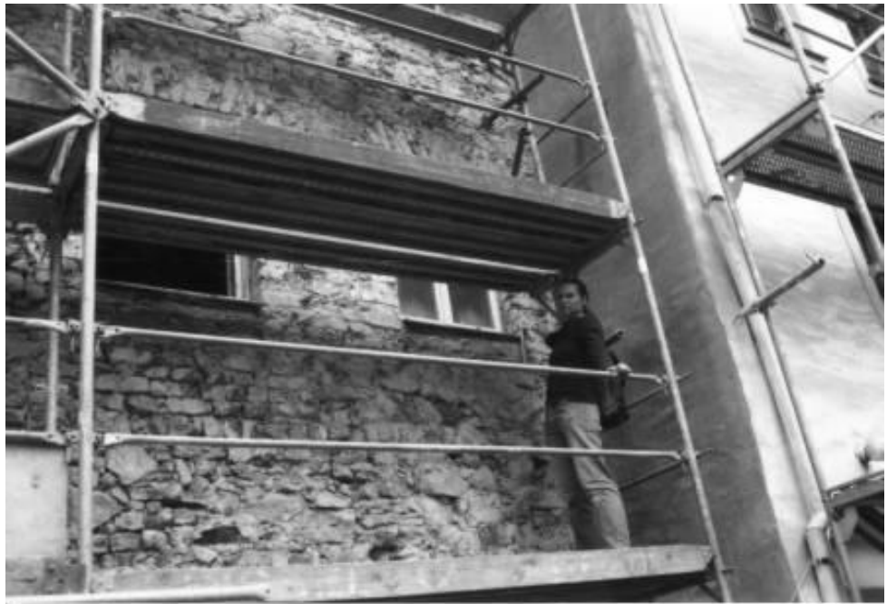
Abb. 2.6: Hoffassade, Außenwand aus Granit-Basaltmischmauerwerk mit Bruchziegelbestandteilen mit Lehm- oder Kalkmörtelverfugung
