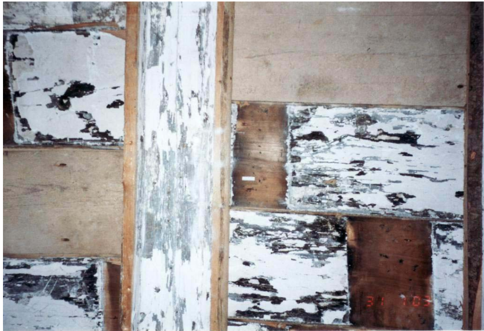
Abb. 2.28: 2. Obergeschoss, Decke über 2. OG, zweitverwendete Einschubbretter
