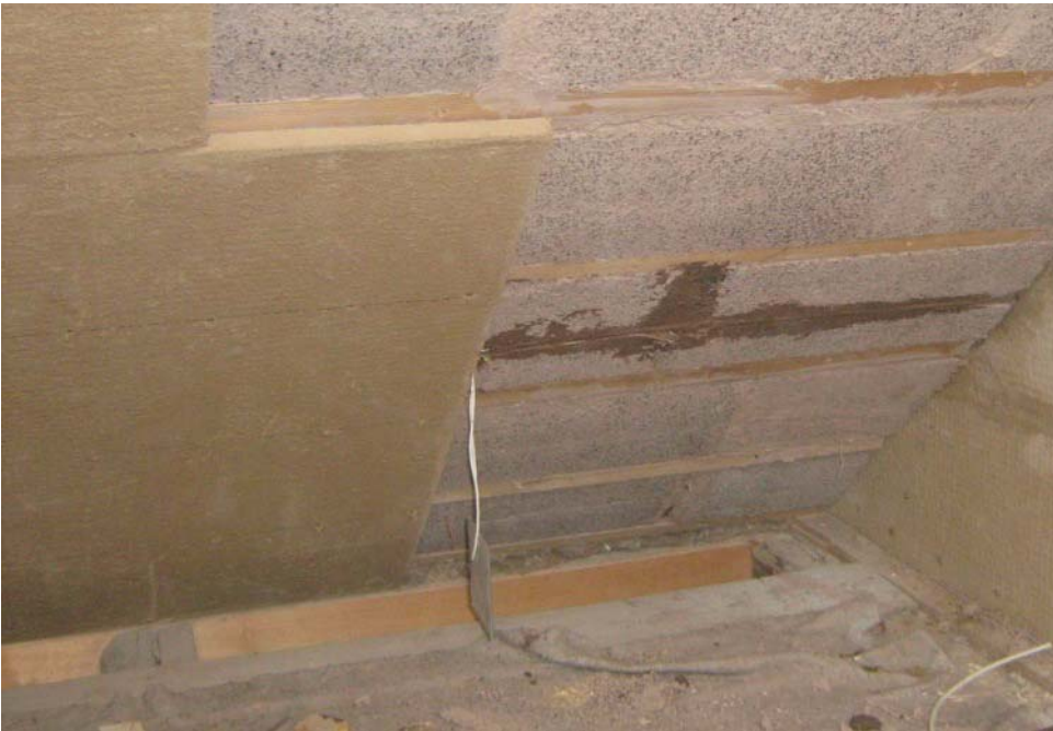
Abb. 2.43: HAACKE CELLCO - Wärmedämmlehm-Platte (WDP) als Untersparrendämmung, Messfeld WDP
