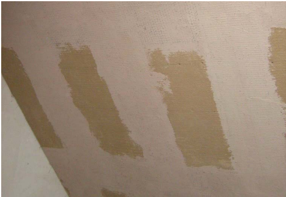
Abb. 2.45: Lehmbauplatten, Fugen armiert mit CELLCO – Contact - Mörtel und einen Gewebe, Machenweite 8 x 8 mm, Überdeckung von je 10 cm, nach einem Tag Standzeit
