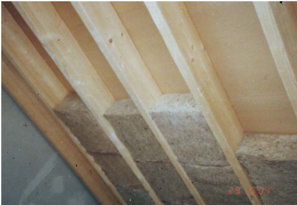
Abb. 2.40: Dachkonstruktion, Zwischensparrendämmung aus Hanf
