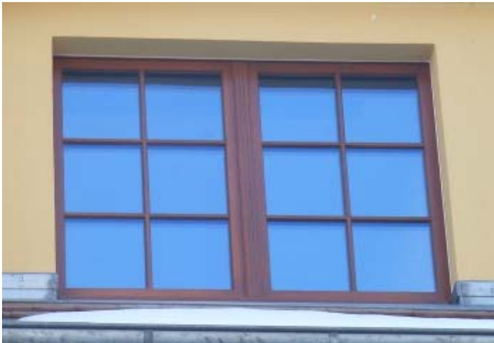
Abb. 2.4: Holz-Einfachfenster mit 3-Scheiben -Wärmeschutzverglasung aus Solarglas, Außenansicht
