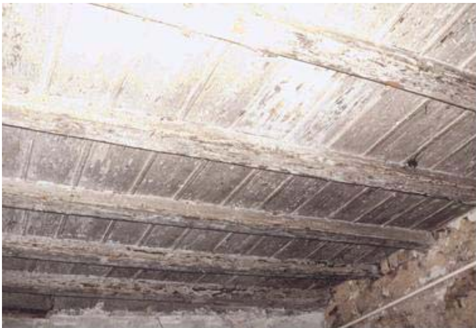
Abb. 1.6: Decke über dem 1. OG Süd vor der Restaurierung
