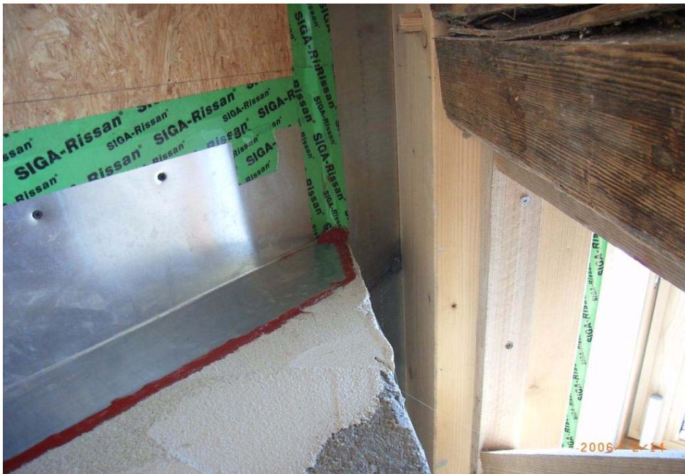
Abb. 2.37: Dachkonstruktion, dauerhafter luftdichter Anschluss Schornstein/ OSB-Platten, Anbindung der Verblechung mit Hochtemperatursilikon (temperaturbeständig bis 800 °C)
