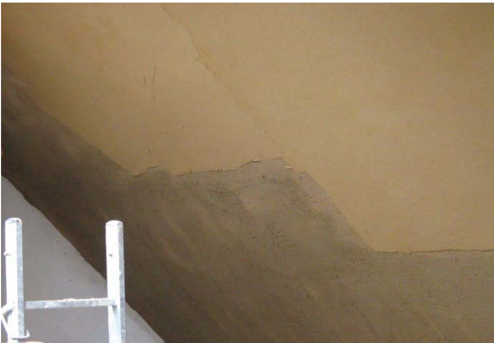
Abb. 2.46: Lehmbauplatten, vorgehästeter Unterputz bei dem Anbringen des Lehmfeinputzes
