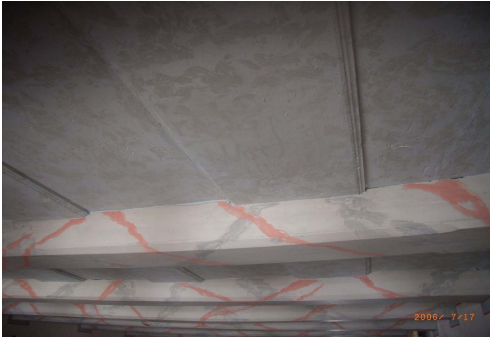
Abb. 1.5: Decke über dem 1. OG Nord, Kriech- und Deckerdecke nach der Restaurierung
