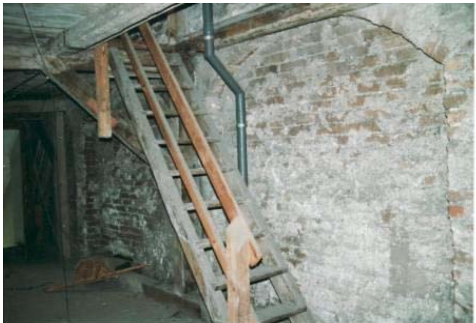
Abb. 2.13: Innenwände aus Ziegelmauerwerk im 2. Dachgeschoss
