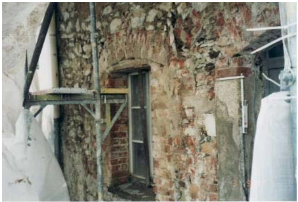
Abb. 2.7: Straßenfassade, Mischmauerwerk aus Granit, Basalt und Ziegelresten
