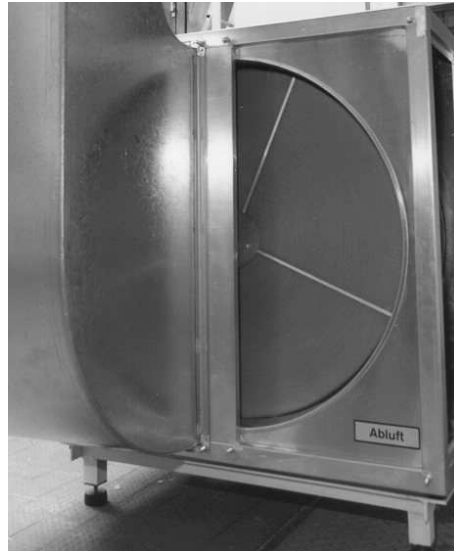
Abbildung 2.4: Sorptionsrotor (Versuchsanlage der TUHH)
