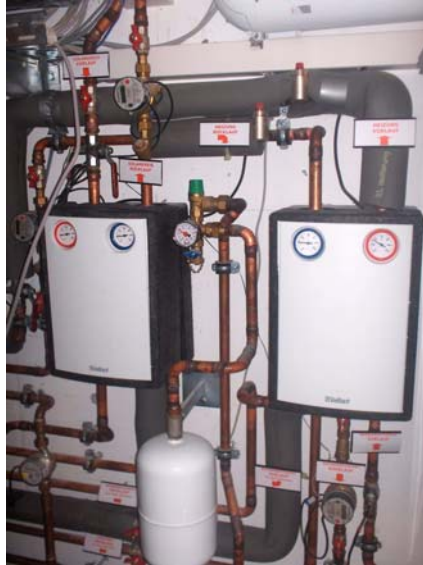
Abbildung 4.3: Hydraulikblock
