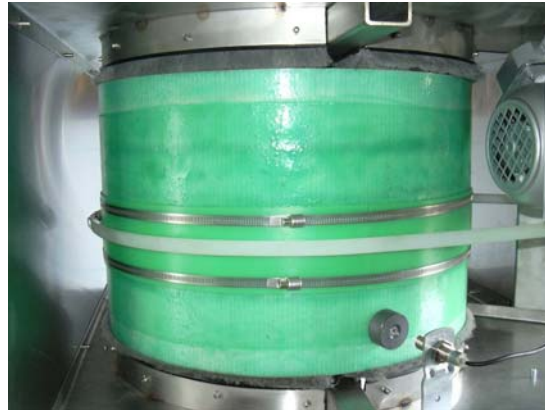
Abbildung 3.9: Eingebauter Sorptionsrotor im Lüftungsgerät
