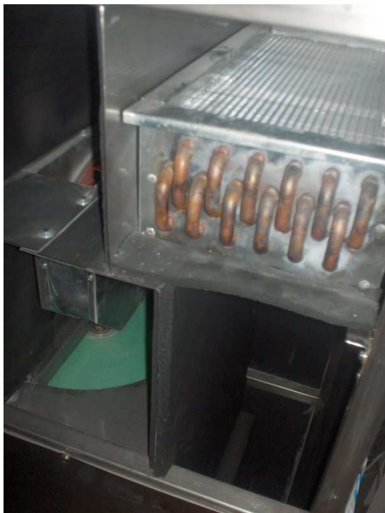
Abbildung 3.10: Kühler im Lüftungsgerät (links) und Ventilatoren (rechts)
