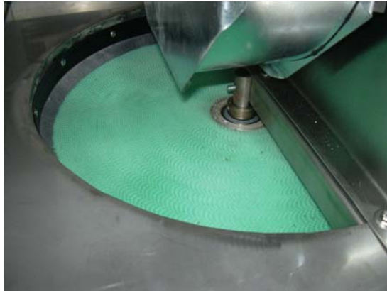
Abbildung 3.9: Eingebauter Sorptionsrotor im Lüftungsgerät
