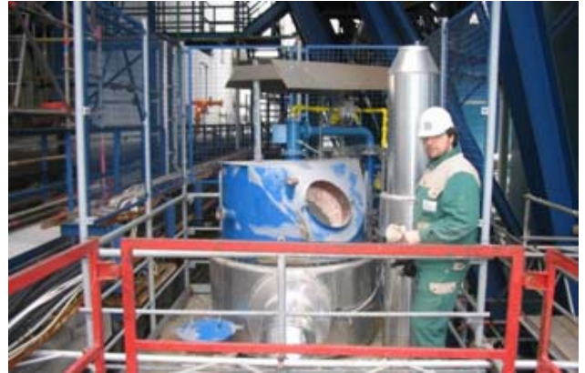
d) Brennkammerkopf
