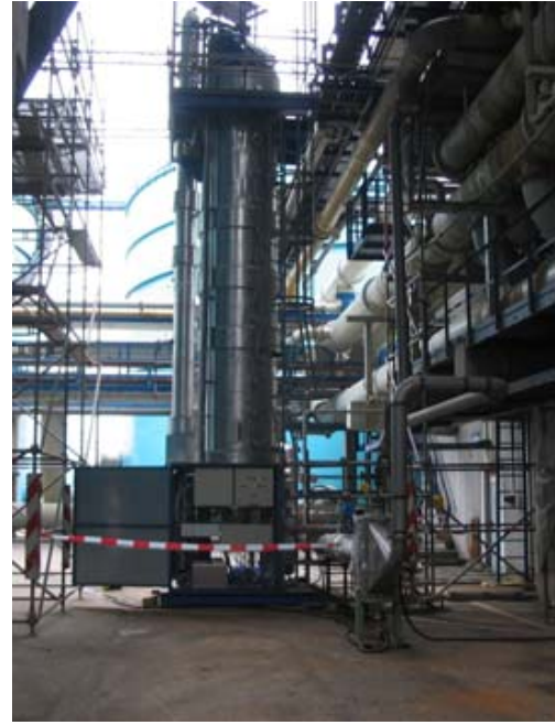
b) Aufbau der Pilotanlage (2)
