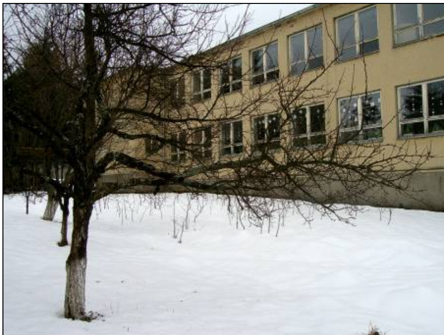
Abbildung 23 Potenzieller Bauort 2 für den „Garten für sauberes Wasser“
