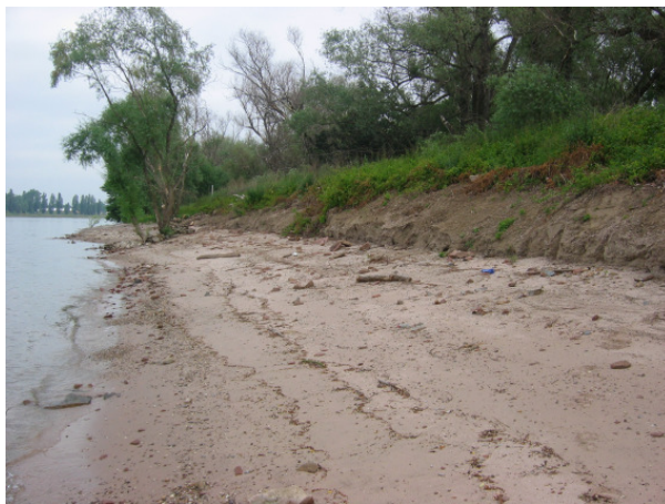
OR7 nach Durchgang verschiedener Hochwasser, Juni 2005
