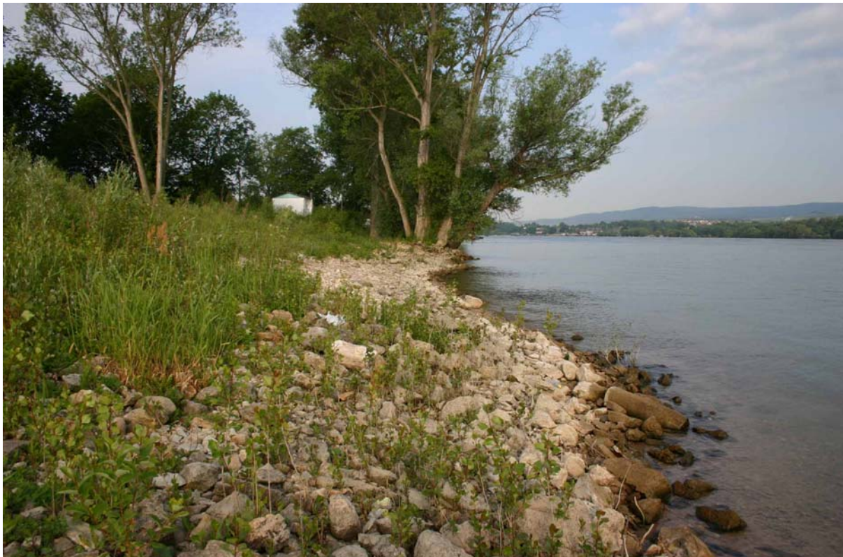
Ufersituation vorher, Juni 2004: Bauschuttreste bestimmen das Bild.
