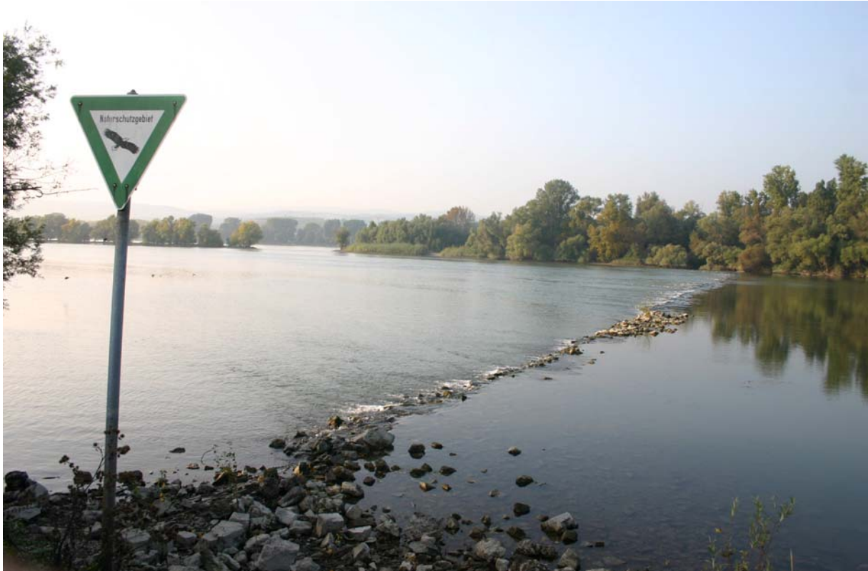
Querbauwerke sorgen für eine Verlandung der Stillwasserbereiche
