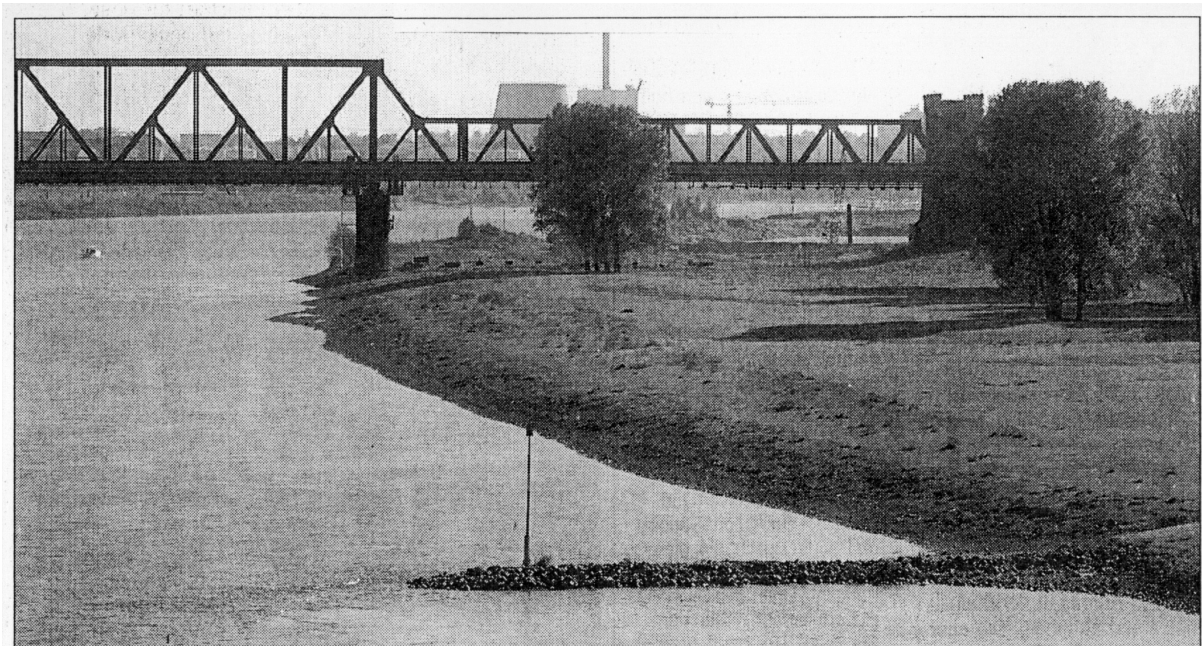
Das Rheinufer bei Rheinhausen von der Eisenbahnbrücke bis zur ersten Buhne wird renaturiert. (Foto: Angelika Barth)
