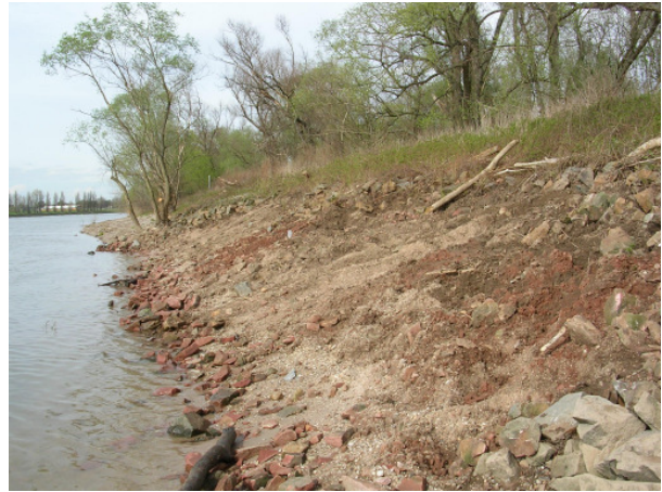
OR7 nach Rückbau der Befestigung, April 2005
