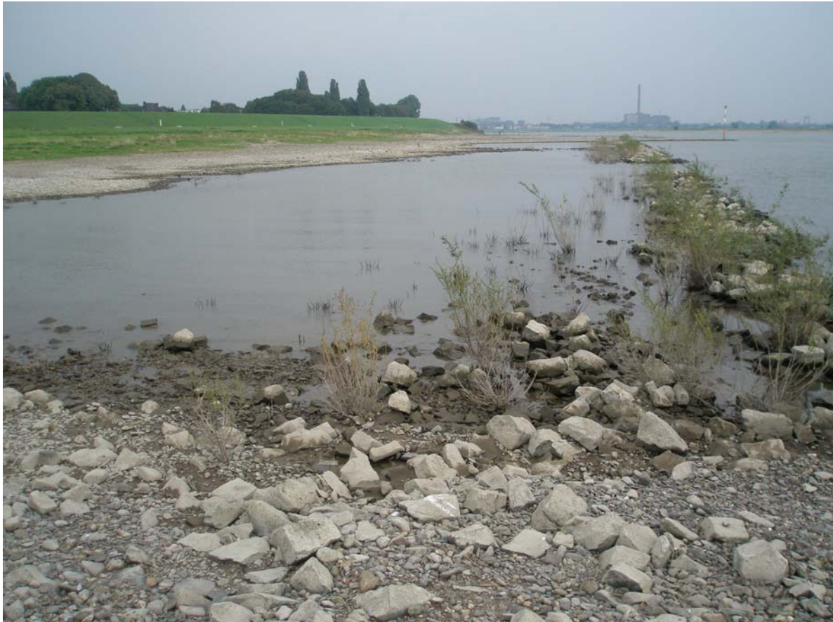
Flachwasserbereich hinter geschlitzter Parallelschüttung, September 2007
