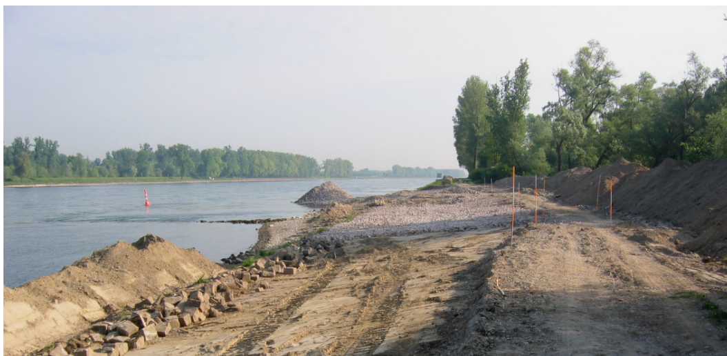
Einbau der Grundsicherung (OR1)
