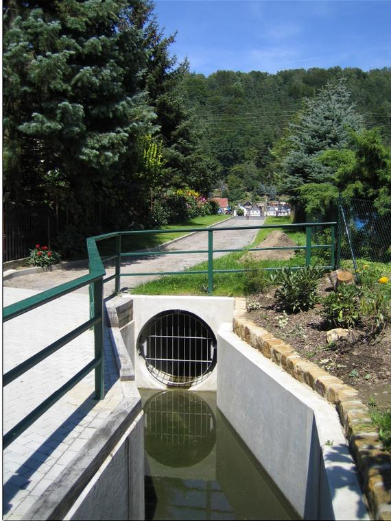
**Abbildung 13: Einlass in das Entwässerungsrohr in Richtung Elbe (THIEME 2007)**
