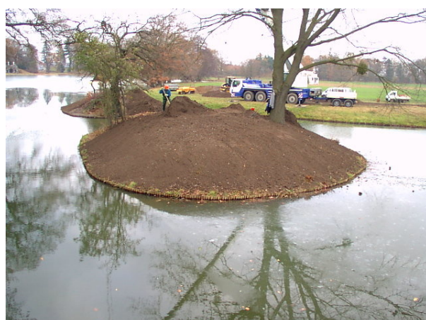
Links: Verfüllung eingebrochener Inselbereiche und Bodenabdeckung. Rechts: Feinprofilierung des Bodenprofils nach historischen Vorgaben. Fotos Horst Woche
