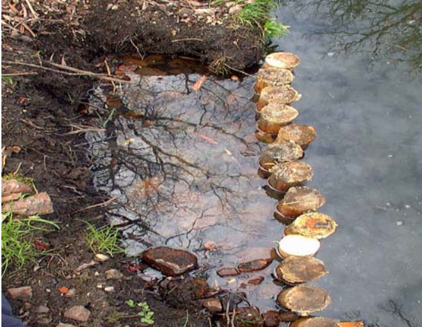
Links: Punktueller Sanierung der Pfahlreihe und des Auskolkungsbereiches. Rechts: Rückbau und Wiederherstellung eines größeren geschädigten Uferbereiches. Fotos Horst Woche
