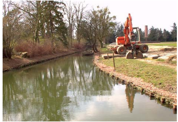
Links: Einbau von Faschinenpfählen. Überdeckung der Nadelholzfaschinen mit Wasserbausteinen. Fotos Horst Woche
