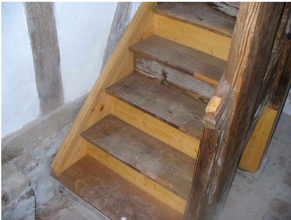
Restaurierung und Teilrekonstruktion der Treppenanlage im Pflanzturm. Foto Michael Wetzel
