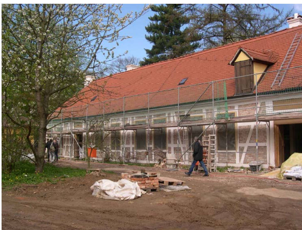
Luisium, Eyserbeckhaus 2003 Fachwerksanierung. Fotos Reinhard Alex
