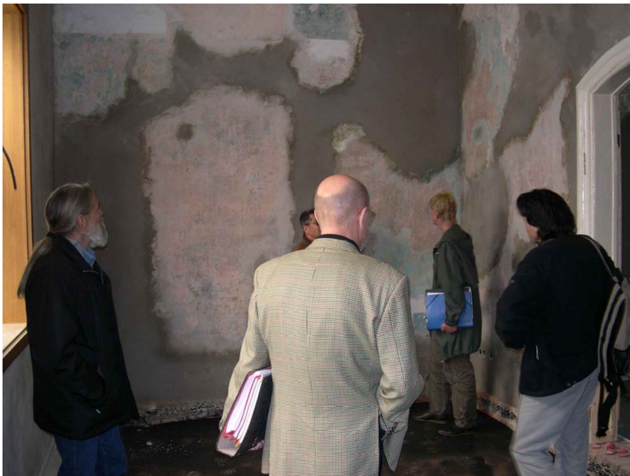
Luisium, Eyserbeckhaus 2004. Restaurierungsarbeiten im Inneren. Foto Reinhard Alex
