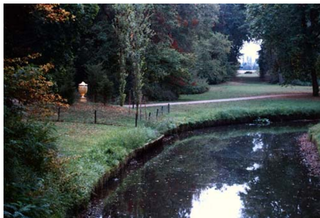
Links: Auskolkung des Ufers an der Goldenen Urne. Rechts: Ausgetrockneter Kanal an der Golden Urne mit abgerutschter Pfahlreihe. Fotos Silvia Matthes
