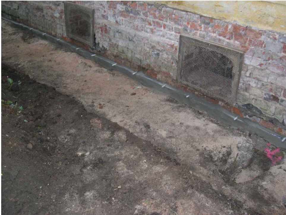
Luisium, Eyserbeckhaus 2003 Abdichtung des Kellers gegen das Erdreich. Foto Reinhard Alex
