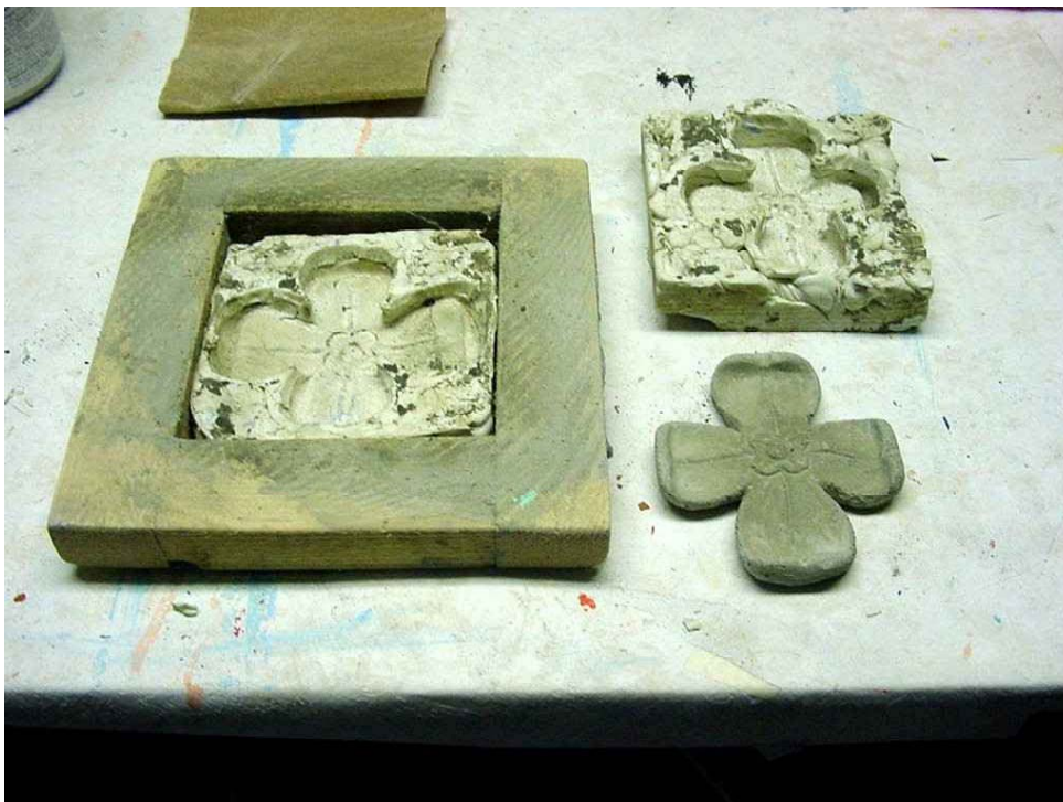
Restaurierung und Teilrekonstruktion der Fassadenzierglieder (Blüten und Triglyphen). Foto Michael Wetzel
