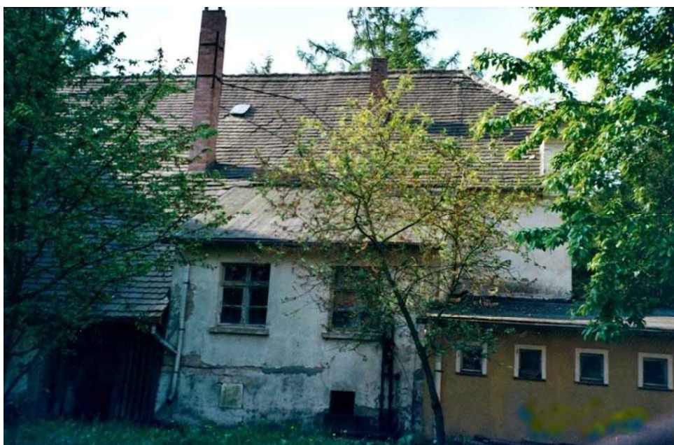
Vorzustand Orangerie 2002 mit später eingezogenen Zwischendecken und unpassenden Anbauten an der Hofseite. Fotos Michael Wetzel
