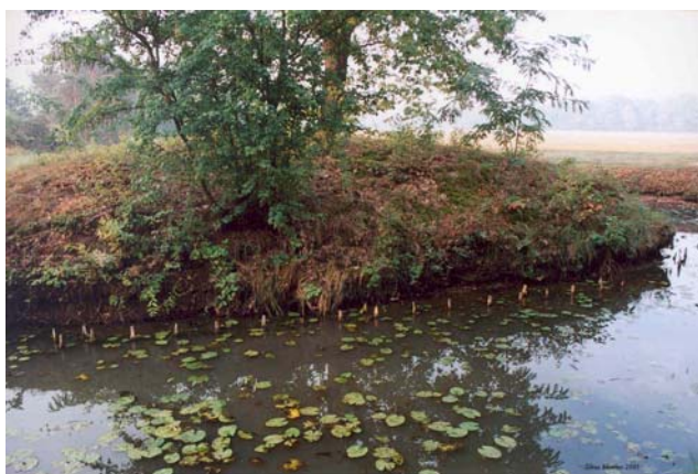
Links: Zerstörter Faschinenverbau der Insel 1. Rechts: Unterspülte Uferböschung der Insel 1. Fotos Horst Woche
