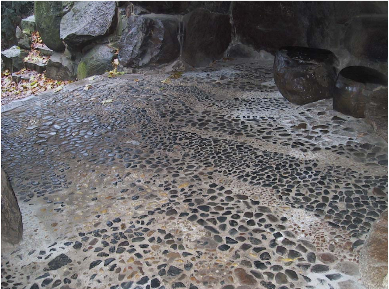
Restaurierung des als Flussbett gestalteten Fußbodens der mittleren Grotte 2004. Foto Annette Scholtka
