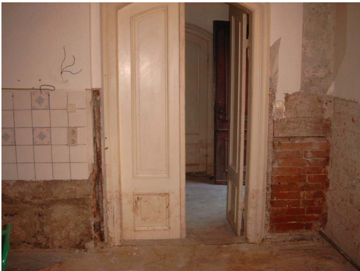
Luisium, Eyserbeckhaus 2002 nach Beginn der Trocknungsarbeiten. Foto Michael Wetzel
