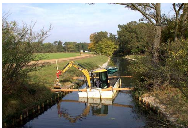
Links: Einbau von Faschinenpfählen und Dreifach-Nadelholzfaschinen. Rechts: Einbau von Wasserbauschotter. Fotos Silvia Matthes
