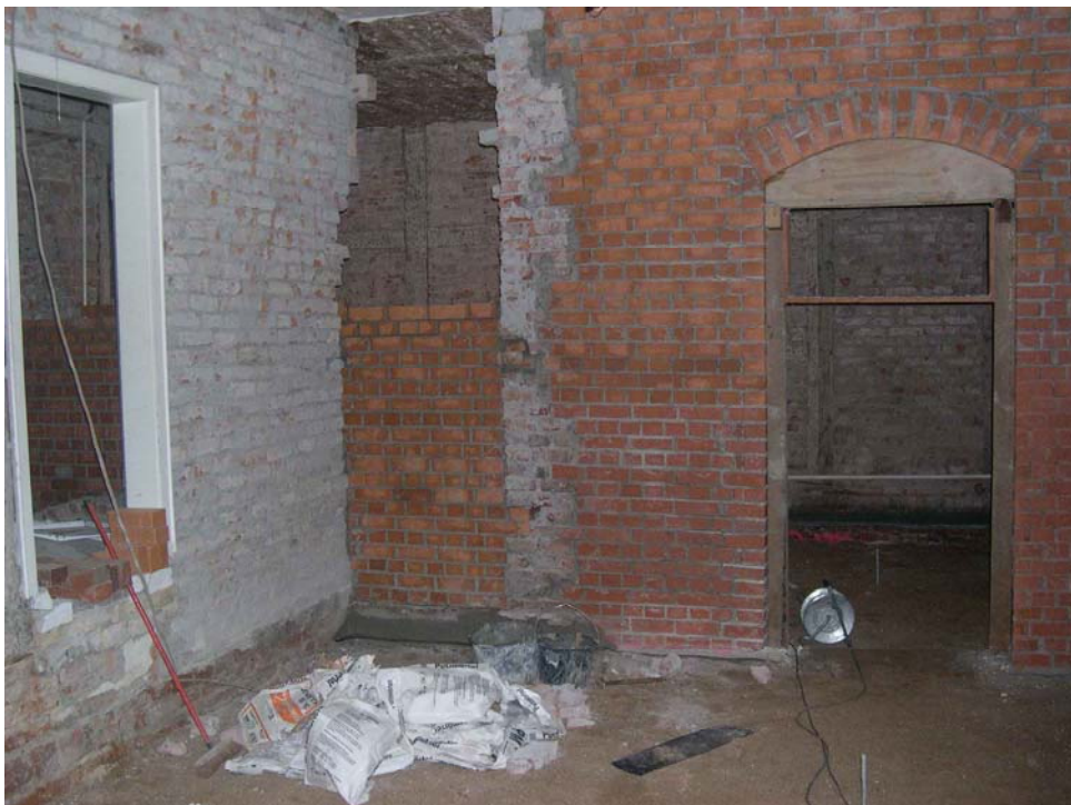
Luisium, Eyserbeckhaus 2003, Teilerneuerung von Wänden. Foto Michael Wetzel
