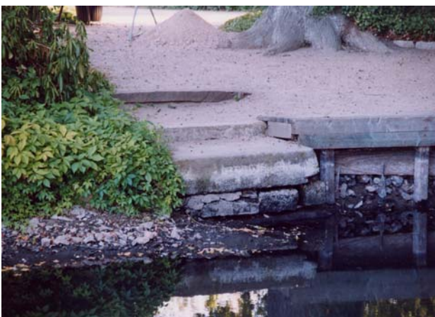
Links: Ausgekolktes und unterspültes Fundament der Stufenanlage vor der Anlegestelle. Rechts: Fundamentgründung aus Eichenkantholz. Fotos Horst Woche
