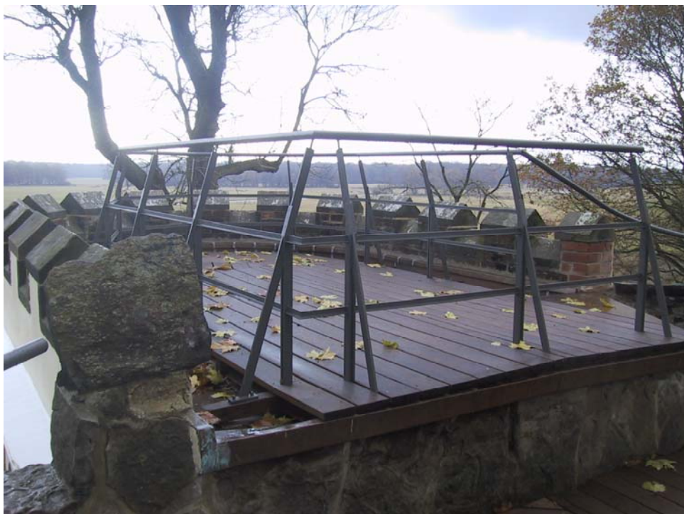
Luisenklippe 2004, Endzustand des Daches mit Aussichtsplattform. Foto pmp
