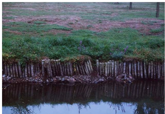
Links: Auf die Vegetationsflächen übergetretener Wasserspiegel des Wolfskanals. Rechts: Ausgekolkter Böschungsfuß und Pfahlreihe. Fotos Ludwig Trauzettel
