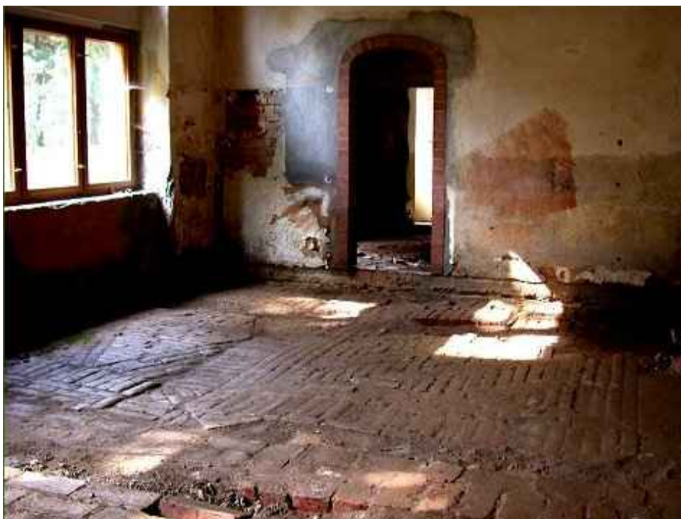
Ursprünglichen Ziegelfußboden. Foto Annette Scholtka
