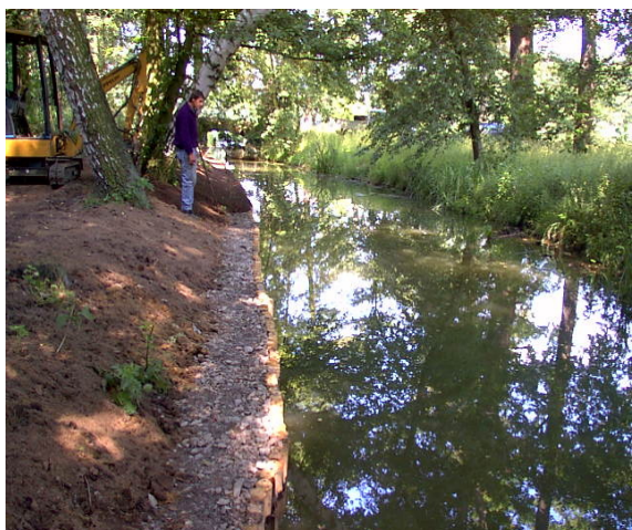
Links: Einbau einer durchgehenden Pfahlreihe mit Hinterfüllung von Wasserbauscotter. Rechts: Bodenprofilierung der Uferböschungen nach historischem Vorbild. Fotos Horst Woche
