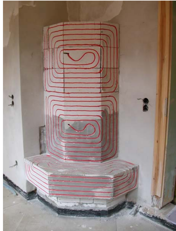
Warmluftöfen an historischer Stelle im Eyserbeckhaus, Heizschleifen im Inneren, eingebettete Heizschleifen an der Außenseite. Fotos Bernd Sitte
