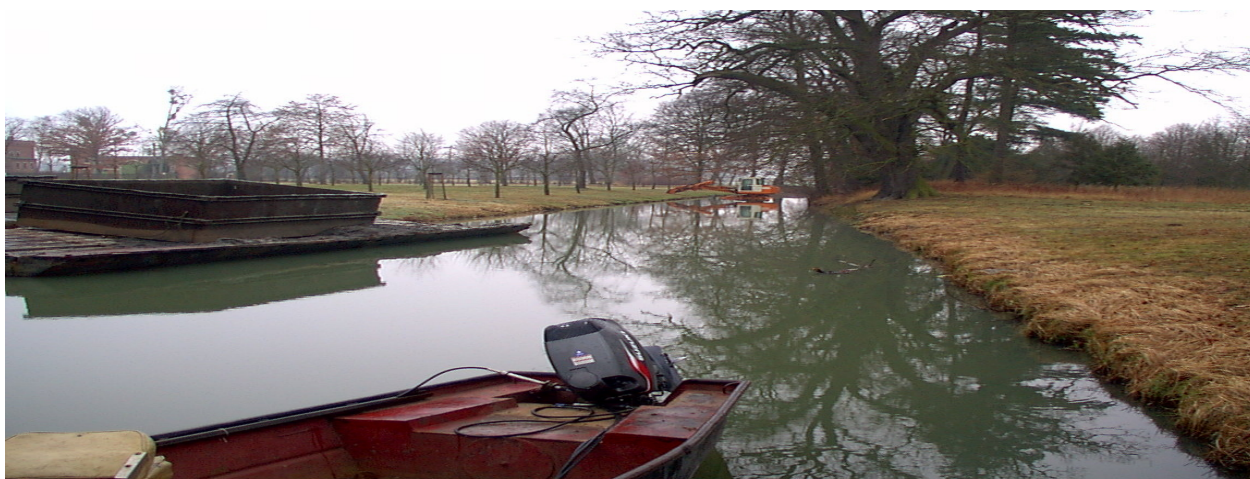
Entschlammungsarbeiten im Kanalabschnitt 3 (Kettenbrücke bis Wasserauslauf). Foto Horst Woche
