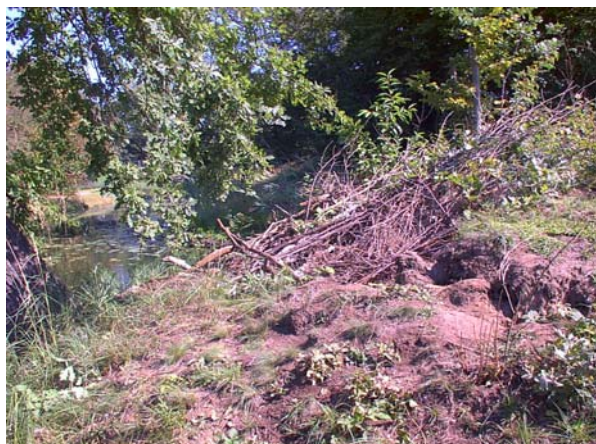
Insel 2: Eingebrochenes und unterspültes Bodenprofil des Inselkörpers. Fotos Horst Woche
