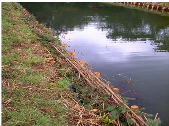
Links: Einbau von Faschinenpfählen und Dreifach-Nadelholzfaschinen. Rechts: Einbau von Wasserbauschotter. Fotos Silvia Matthes
