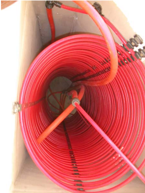
Warmluftöfen an historischer Stelle im Eyserbeckhaus, Heizschleifen im Inneren, eingebettete Heizschleifen an der Außenseite. Fotos Bernd Sitte
