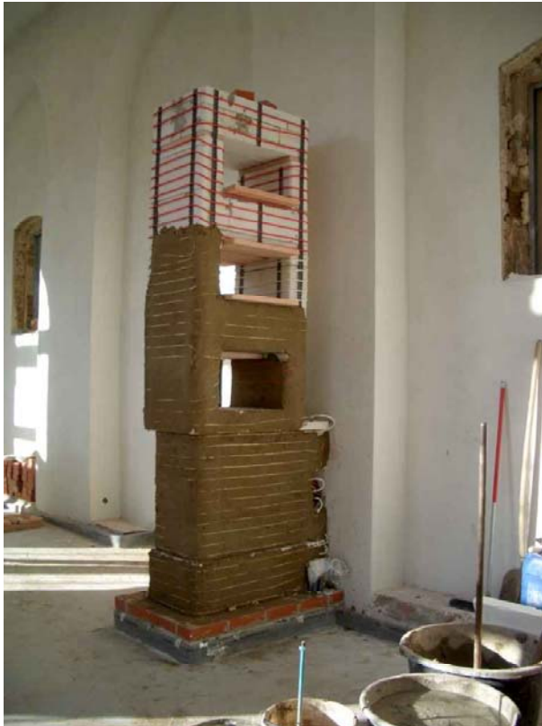
Rekonstruktion zweier historischer Öfen; im Gastraum Integration der modernen Warmwasserheizung in die historische Form des Ofens, im Orangerieteil Holzfeuerung für Havariefälle. Fotos Michael Wetzel
