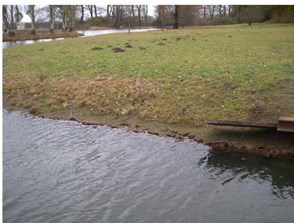
Links: Unterspülte Böschungskante am Wasserauslauf Forthgraben. Rechts: Ausgekolkte Böschung und abgesackte Faschinen- und Schotterpackung. Fotos Horst Woche
