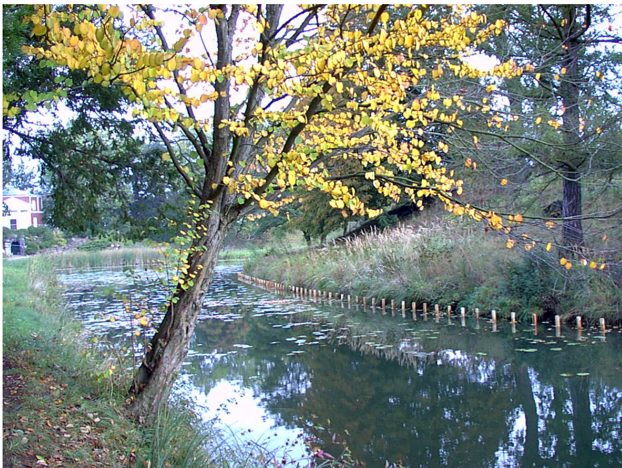
Beginn der Uferinstandsetzungsarbeiten durch das Setzen der Faschinenpfähle unter Beachtung der Wiederherstellung der historischen Uferlinienführung. Foto Horst Woche
