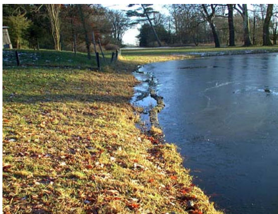
Links: Auskolkung des Ufers an der Goldenen Urne. Rechts: Ausgetrockneter Kanal an der Golden Urne mit abgerutschter Pfahlreihe. Fotos Silvia Matthes
