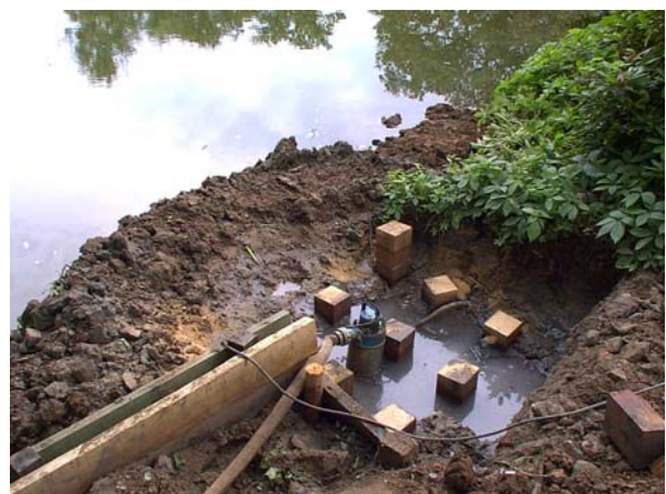
Links: Ausgekolktes und unterspültes Fundament der Stufenanlage vor der Anlegestelle. Rechts: Fundamentgründung aus Eichenkantholz. Fotos Horst Woche
