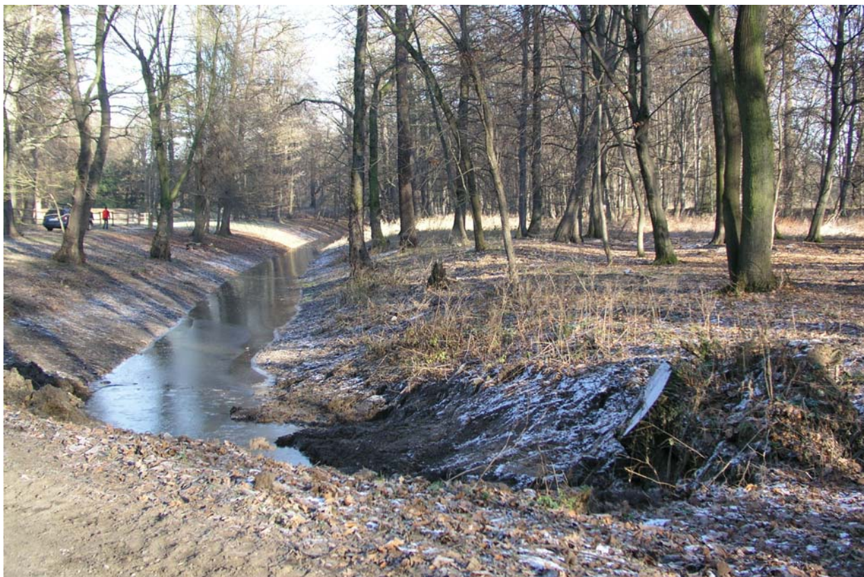
Wiederhergestelltes Bodenprofil der Grabenböschung und Grabensohle. Foto Horst Woche
