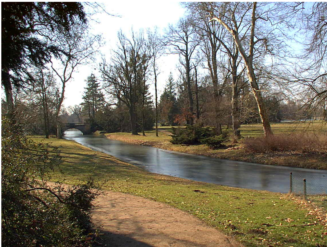
Agneskanal nach Abschluss der Instandsetzungsarbeiten mit Blick von der Goldenen Urne zur Neuen Brücke. Foto Silvia Matthes
