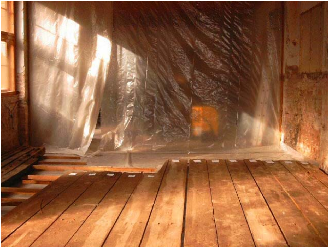
Luisium, Eyserbeckhaus 2002 während der Trocknungsarbeiten, Dokumentation der Dielenlagerung, Ausbau. Foto Michael Wetzel
