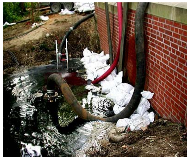
Links: Einströmende, mit Fäkalien, Jauche und Öl gemischte Wassermassen am Einlauf des Wassermühlengrabens. Rechts: Abschottung des Einlaufbereiches und Abpumpen des verunreinigten Wassers. Fotos Ludwig Trauzettel
