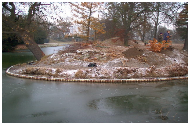
Insel 1 und 2: Restaurierung der historischen Uferlinie mit einer durchgehenden Pfahlreihe. Fotos Horst Woche
