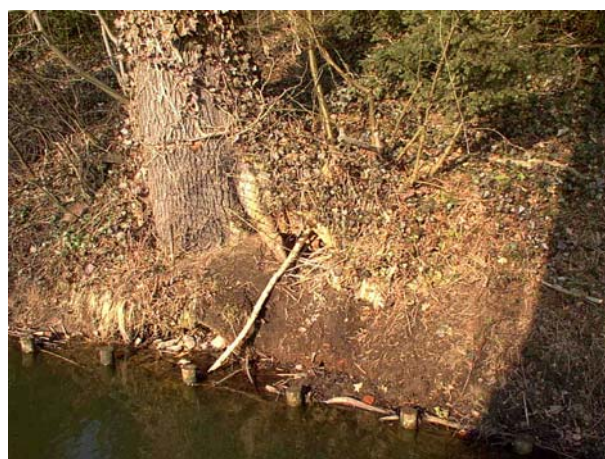
Links: Unterspülte Böschungskante am Wasserauslauf Forthgraben. Rechts: Ausgekolkte Böschung und abgesackte Faschinen- und Schotterpackung. Fotos Horst Woche
