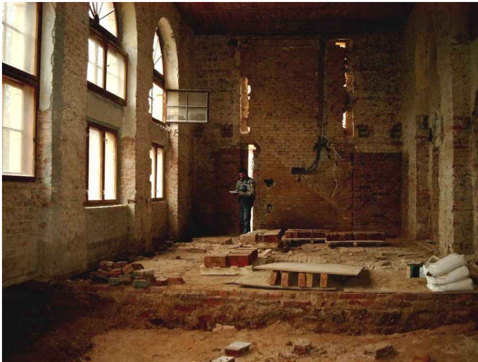
Während der Rückbauarbeiten wurden ein bauzeitliches Tor und Teile des ursprünglichen Ziegelfußbodens aufgefunden. Foto Michael Wetzel
