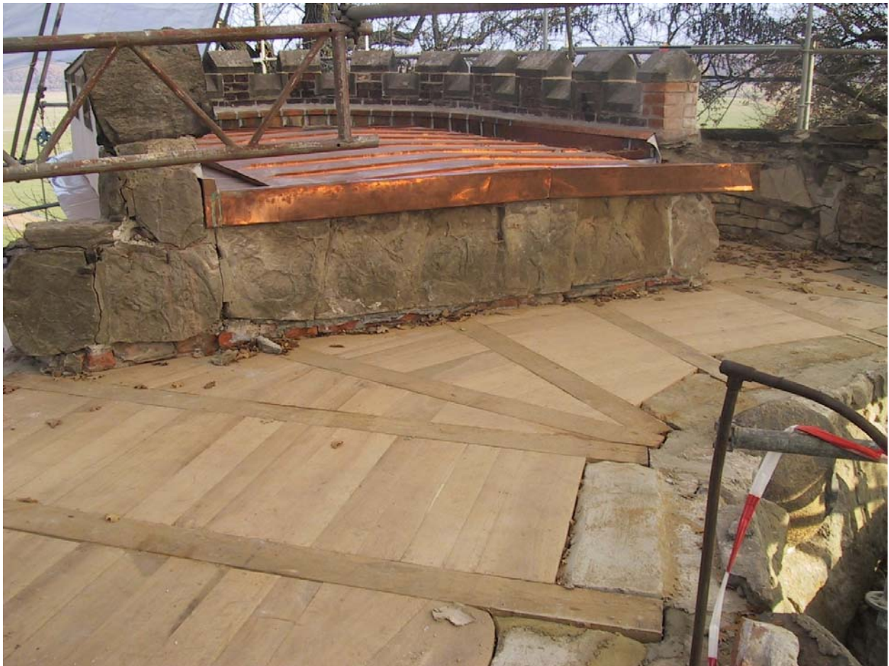
Obere Plattform 2003. Einbau einer Holzbalkendecke über dem Gewölbe der Grotte zur Aufnahme der Dachdeckung und der Verkehrslasten. Rekonstruktion des bauzeitlichen Zustandes. Foto pmp
