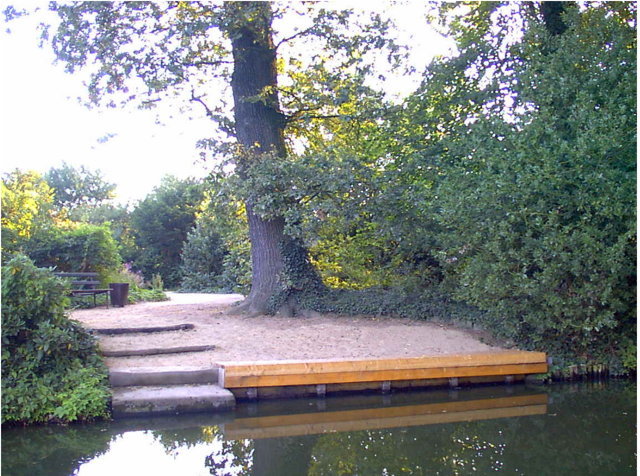
Sanierte Sandsteinstufenanlage und Kahanlegestelle. Foto Horst Woche
