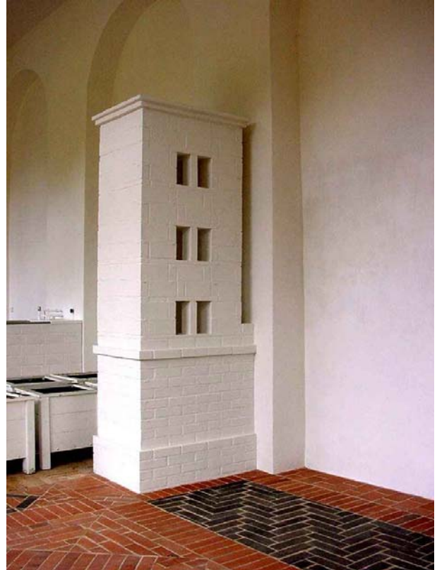
Rekonstruktion zweier historischer Öfen; im Gastraum Integration der modernen Warmwasserheizung in die historische Form des Ofens, im Orangerieteil Holzfeuerung für Havariefälle. Fotos Michael Wetzel
