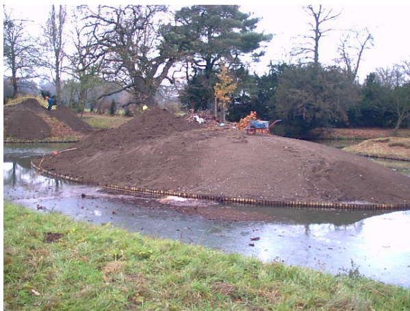
Links: Verfüllung eingebrochener Inselbereiche und Bodenabdeckung. Rechts: Feinprofilierung des Bodenprofils nach historischen Vorgaben. Fotos Horst Woche
