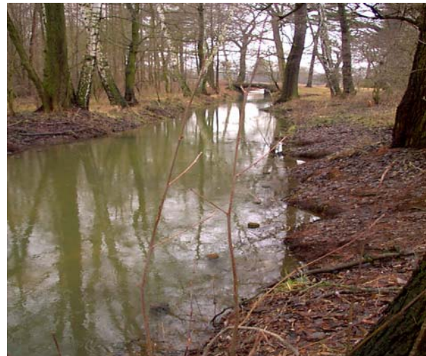
Links: Ausgespülte Uferlinienführung im Bereich des Faschinenverbaues. Rechts: Auskolkung der Uferländer und Uferböschungen. Fotos Horst Woche
