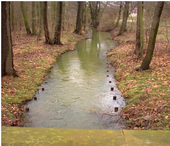
Links: Ausgespülte Uferlinienführung im Bereich des Faschinenverbaues. Rechts: Auskolkung der Uferländer und Uferböschungen. Fotos Horst Woche
