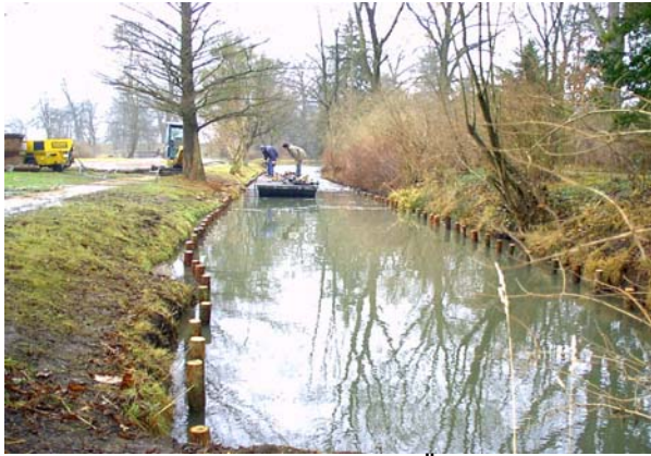
Links: Einbau von Faschinenpfählen. Überdeckung der Nadelholzfaschinen mit Wasserbausteinen. Fotos Horst Woche
