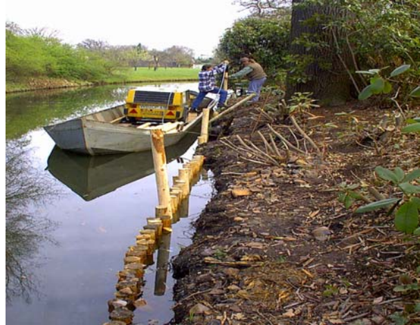
Links: Punktueller Sanierung der Pfahlreihe und des Auskolkungsbereiches. Rechts: Rückbau und Wiederherstellung eines größeren geschädigten Uferbereiches. Fotos Horst Woche
