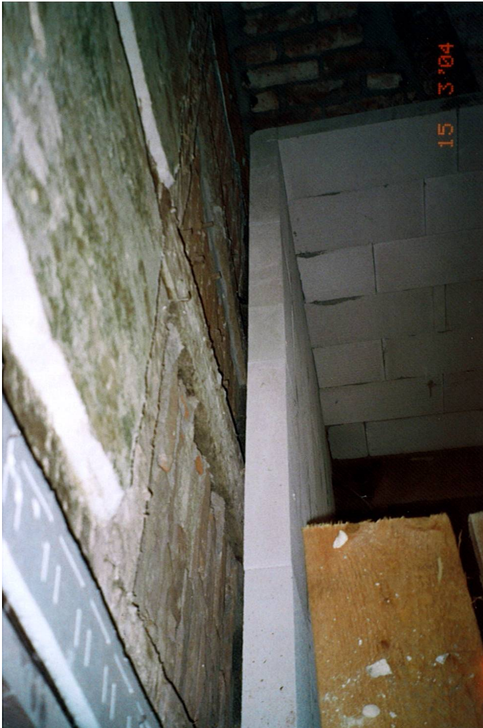
Luisium, Eyserbeckhaus 2004 Fachwerksanierung, Innendämmung mit Cellco-Wärmedämmlehm. Foto Bernd Sitte
