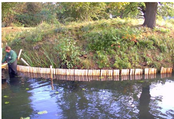
Insel 1 und 2: Restaurierung der historischen Uferlinie mit einer durchgehenden Pfahlreihe. Fotos Horst Woche
