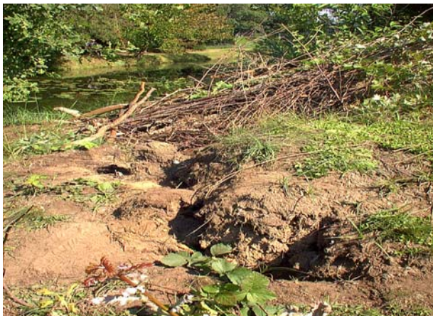
Insel 2: Eingebrochenes und unterspültes Bodenprofil des Inselkörpers. Fotos Horst Woche
