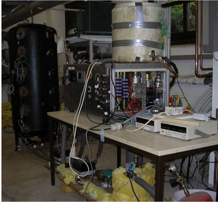
Abbildung 5.10: Messaufbau mit CO 2 -Wärmepumpe und Schichtenlade-Pufferspeicher im Labor des IGS
