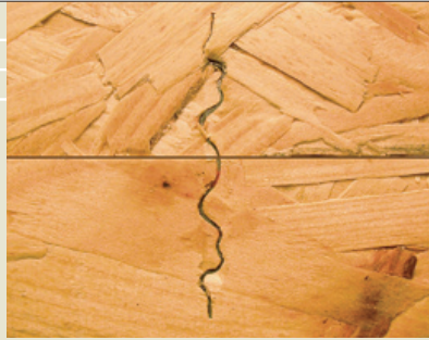
Schubstif verbundener Plattenstoß
