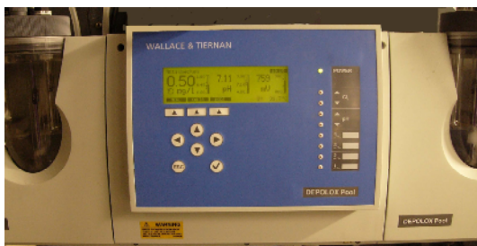
Abb. 4.7: Mess- und Regeleinrichtung für freies Chlor, Redox-Spannung und pH-Wert
