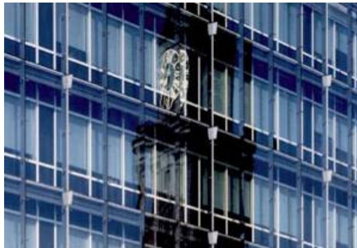
Abbildung 28 Ansicht Doppelfassade (v. Bassewitz, Patschan, Hupertz, Limbrock)
