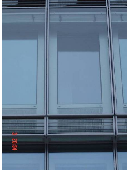
Abbildung 18 festst. Luftleitbleche
