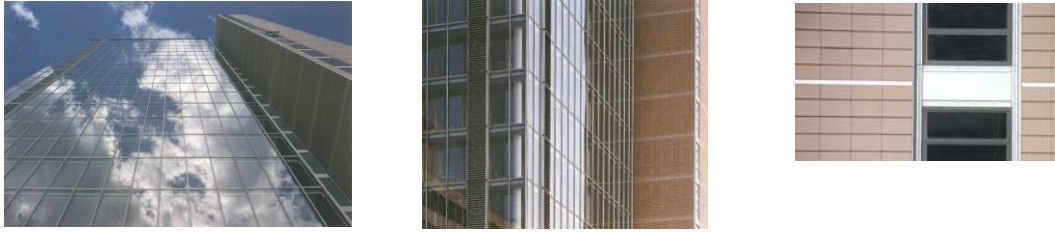
Abbildung 52 Ansicht von außen: Fassadenthemen (Doppelfassade; vorg. Ziegelfassade)
