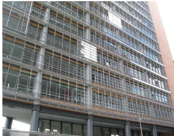
Abbildung 60 Links: Ost- und Westfassade mit geschlossenen Lamellen (AM Burkhardt), Rechts: Ostfassade mit geöffneten Lamellen (Worthmann)
