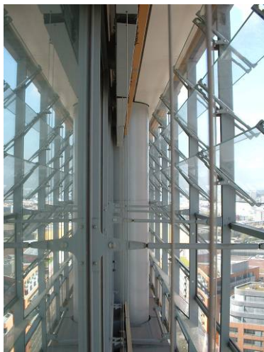
Abbildung 61 Links: Fassadenzwischenraum (IGS) Rechts: drehbare Glaslamellen (IGS)
