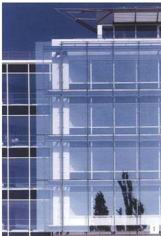
Abbildung 28 Ansicht Doppelfassade (v. Bassewitz, Patschan, Hupertz, Limbrock)
