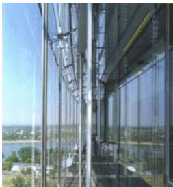
Fassadenzwischenraum
