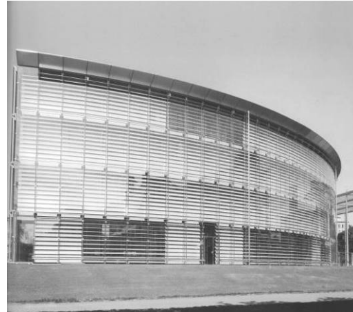
Abbildung 39 Ansicht Doppelfassade Südseite Nordseite (H. Jahn)
