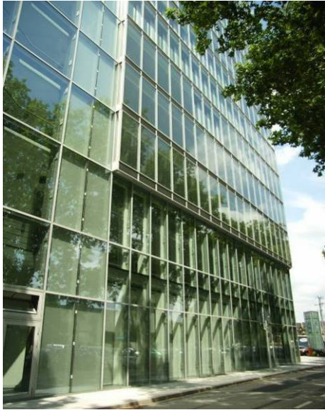
Abbildung 17 Doppelfassade
