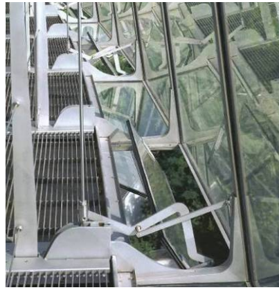
schwenkbare Lüftungsklappen (Birkhäuser)
