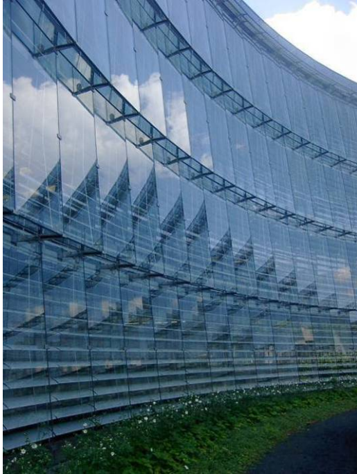
Abbildung 40 schräg gestellte Südfassade geschossweise klappbare Lüftungselemente (Birkhäuser)
