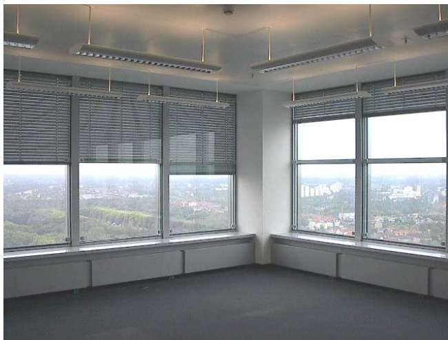
Abbildung 69 Sonnenschutz-Lamellen (Fotos IGS)
