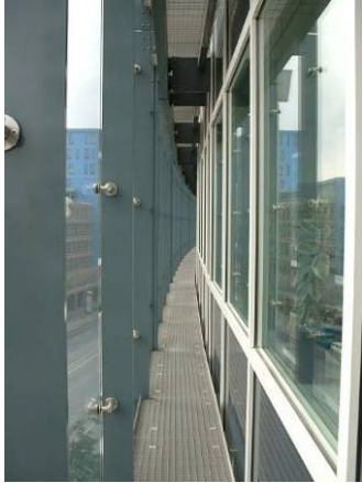
Abbildung 27 Doppelfassade (IGS)
