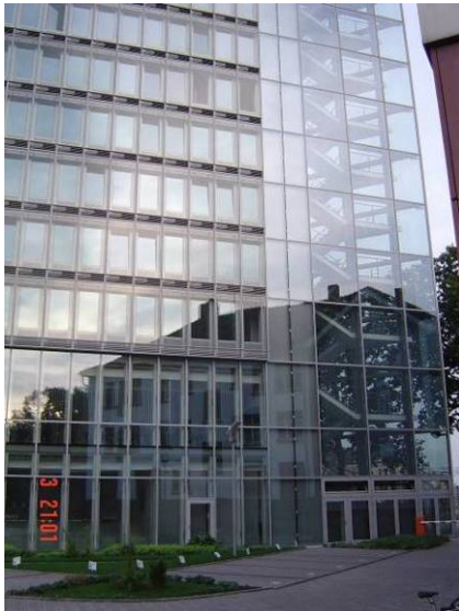
Abbildung 19 Sockelebene und Gebäudespitze
