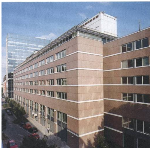
Abbildung 26 Nordansicht Fassade Neuer Steinweg (Fotos Publikation Deutscher Ring)
