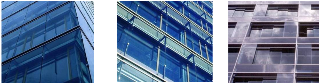
Abbildung 48 Ansicht von außen: Fassadenthemen (Dofa; Fassade auf Treppenhauseite)
