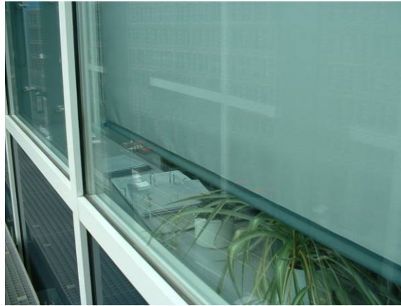
Primärfassade der Doppelfassade (IGS)
