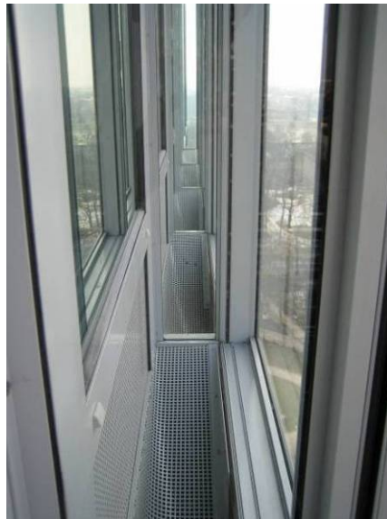
Abbildung 20 Fassadenzwischenraum
