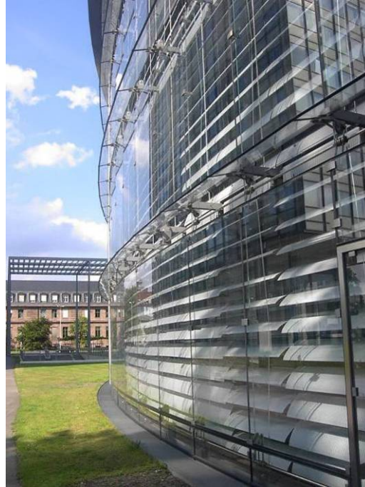
Abbildung 41 Nordfassade (90°, vertikal) geschossweise schwenkbare Lüftungskappen (Birkhäuser)
