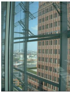
Blick in die Doppelfassade
