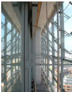
Fassadenzwischenraum
