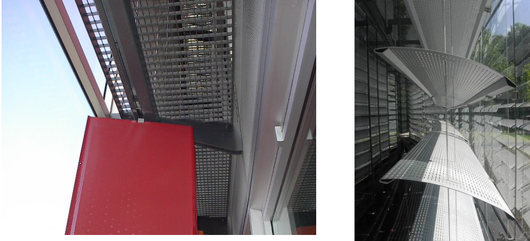
Abbildung 183 Sonnenschutzsystem im Projekt TwinSkin
