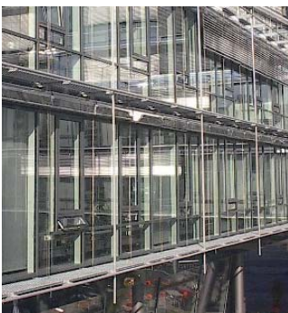
Fassade zu Innenhof
