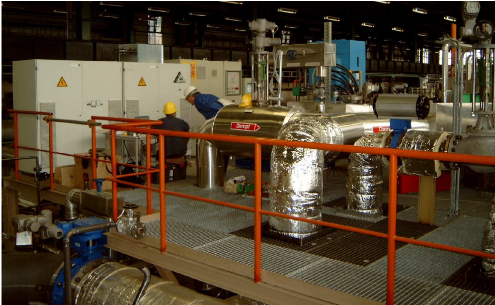
Abbildung 26: Ansicht der Versuchsanlage
