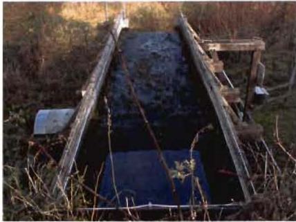
Abb. 34: Auslauf der Kläranlage Warendorf
