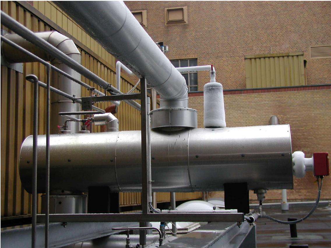
Abb. 5.12 Inertgasblase an der Versuchsanlage
