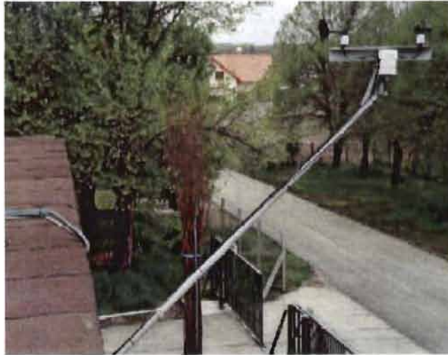
Abb. 3.12: Umgebungstemperaturmessung und Windsensoren (Bildquelle: Solartechnik Dr. Ackermann)
