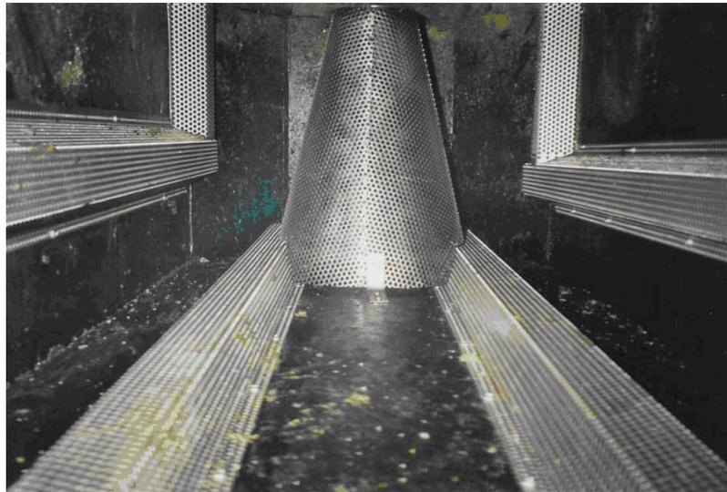
Abbildung 4.5: Innenansicht des hinteren Auffangbehälters (von oben) mit Lüftungsblechen und Sickerwasserabzug [Foto E.Joas 2004]
