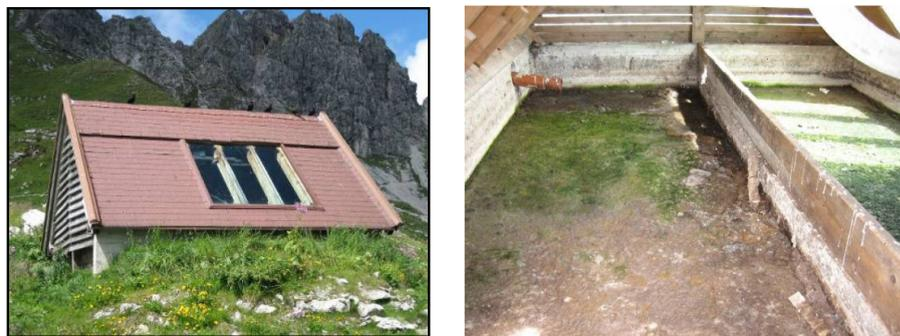
Abbildung A.8: Überdachtes Trockenbeet in Außen- und Innenansicht
