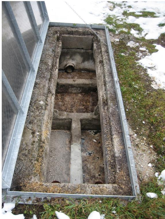
Abbildung 6.3: Sanierte Dreikammergrube der Ostpreußenhütte [Foto F.Schönherr 2007]
