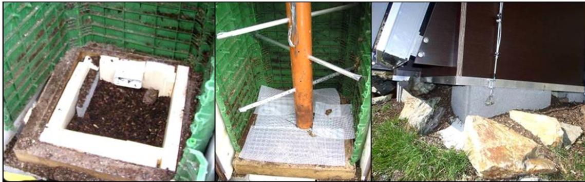
Abbildung 5.10: Wärmedämmplatten und Rindenmulchfilter im Unterbau des Innenbehälters (links), feinmaschiges Netz auf dem Bodengitter und horizontale Lüftungsrohre (Mitte) sowie winddichte Abdichtung der Fundamente mit Steinen und Rindenmulch (rechts) [Foto M.Schön 2008]
