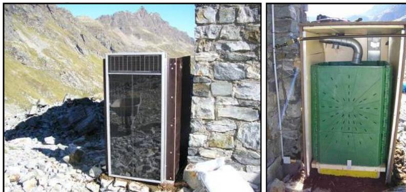
Abbildung A.11: Solar-Komposter in Außen- und Innenansicht
