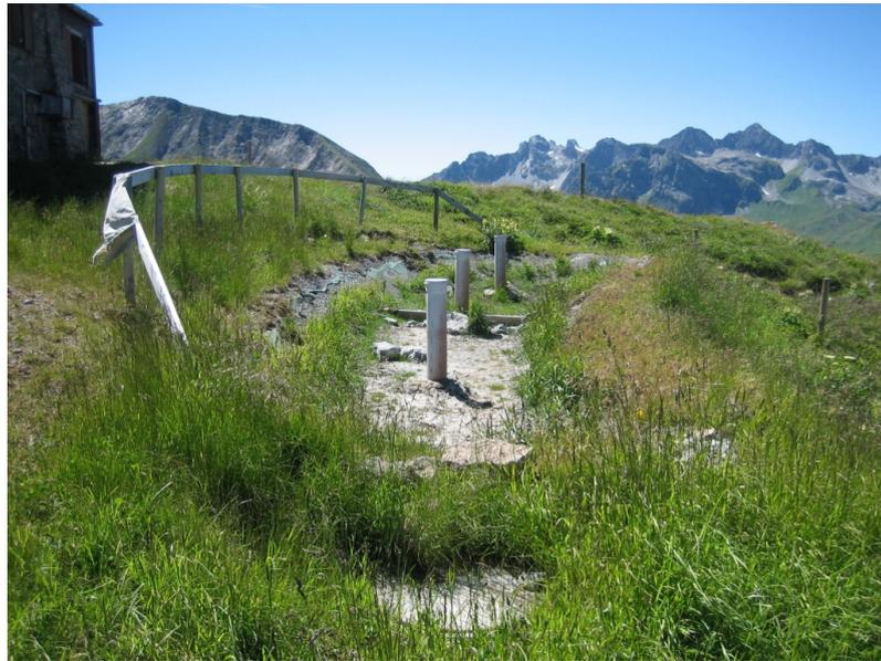
Abbildung 7.5: Pflanzenbeetanlage der Stuttgarter Hütte am 1.8.2007 [Foto F.Schönherr 2007]. Die letztjährig nicht beschickte Polderhälfte ist im Vordergrund zu sehen.
