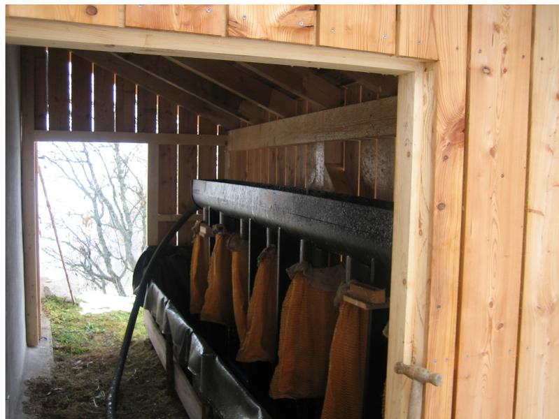
Abbildung 6.4: Holzanbau der Filtersackanlage [Foto F.Schönherr 2007]
