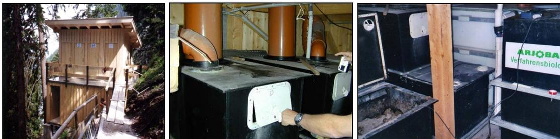
Abbildung 3.1: Links: Ansicht der Toilettenanlage vom Haupthaus [Foto B.Wett 2002]. Mitte: Abwurfschächte und hinterer Lagerungsbereich mit Klappe für Zugabe von Strukturmaterial [Foto R.Ettl 2004]. Rechts: Vorderes Verrottungsabteil [Foto R.Ettl 2004]
