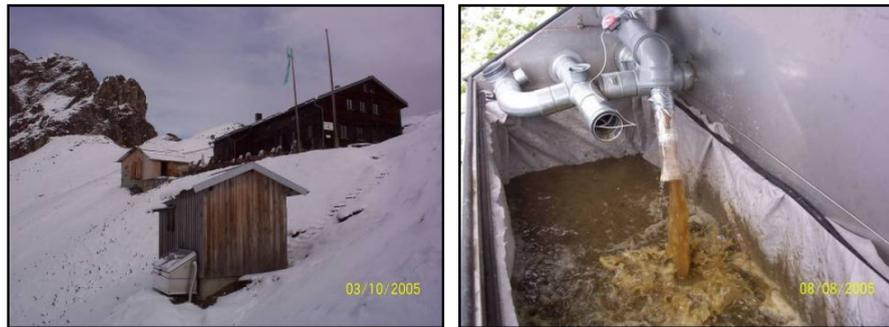
Abbildung A.6: Aufstellung und Befüllung des Solar-Schlammrockners
