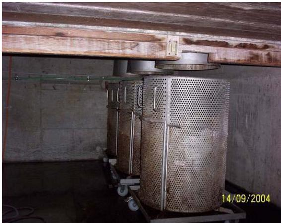
**Abbildung 53: Auffangbehälter aus Edelstahl auf Sickerwassertassen unter Trocken-toilette als "Mechanische Vorreinigung" [Foto M.Vallazza (2004)]**
