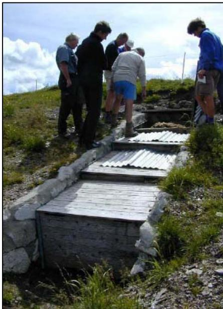
reichert und in verrottbare Transportsäcke aus Jute gefüllt. Diese werden dann händisch in die oberste Stufe eingebracht. Zu Beginn jeder Saison entnimmt der Hüttenwirt das Rottegut aus der untersten Stufe und setzt anschließend den Inhalt der übrigen Stufen jeweils eine Stufe weiter nach unten um. Dadurch werden die Reststoffe gelockert und gemischt. Die zum Saisonbeginn entnommenen Reststoffe der untersten Stufe werden auf einer eingezäunten Ödfläche im Hüttenumfeld ausgebracht und eingesäht.
