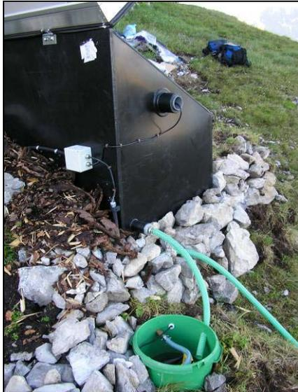
**Abbildung 44: Rückansicht mit Rindenmulchfilter, Pumpschacht, Filtratpumpe und Beschickungsleitung für den ÜSS [Foto W. Becker (2006)]**
