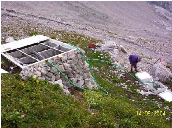
**Abbildung 55: Monatliches Abpumpen von restlichem ÜS2 aus den nachgeschalteten Schächten mit tragbarem Stromaggregat, Tauchpumpe und fliegender Leitung in SEM OST [Foto M.Vallazza (2004)]**
