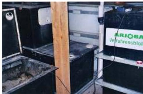
Abbildung 89: Im linken Bildteil ein geöffneter vorderer Teil der Trockentoilette mit nach vor gezogenem Material, im mittleren Bildteil ein mit Deckel verschlossener vorderer Teil der Anlage, im rechten Bildteil der Pumpspeicherbehälter für Abwasser (Grauwasser + Urin) und Kompostsickerwasser [Foto W.Becker (2004)]
