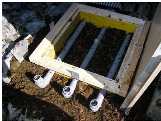
Abbildung 118: Gelochte Rohre zum Einblasen der erwärmten Luft
