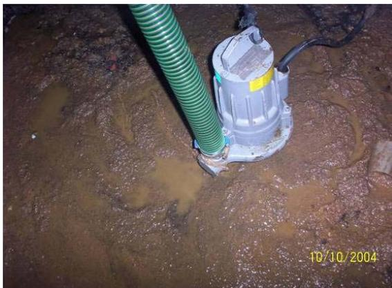
**Abbildung 26: Schneiradpumpe im kompakten Bodenschlamm [Foto M.Vallazza (2004)]**
