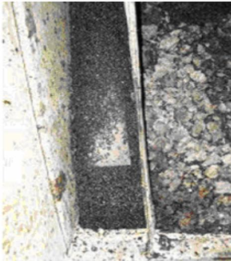
**Abbildung 98: Unter Teil der BERGER-Trockentoilette vom System Berger / linkes Abteil mit Fliegen auf Sickerwasseroberfläche, mittleres Abteil vorwiegend mit Rindenmulch + kompostierten Trockentoiletten-Stoffen über tiefer liegendem SW-Spiegel**
