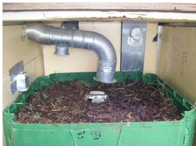
Abbildung 120: Endfüllstand mit Rindenmulch auflage und abgedecktem Zentralrohr
