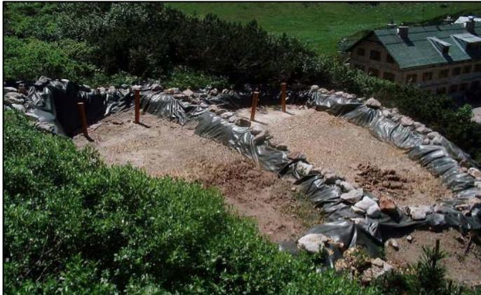
Am Kärlingerhaus (DAV-Sektion Berchtesgaden, 1638 m Seehöhe, Nationalpark Berchtesgaden) ist eine Pflanzenbeetanlage mit zwei Poldern (Fläche je 16 m<sup>2</sup>) installiert. Die Flächen werden zum Saisonende mit Mischschlamm aus der Vorklärung und Schlammwasser aus der Tropfkörperanlage der Hütte beschickt. Zur Abführung von Oberflächen- und
