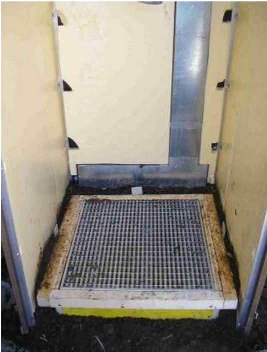
**Abbildung 123: Lüftungsgitter und Seitenwände mit Wärmedämmung**
