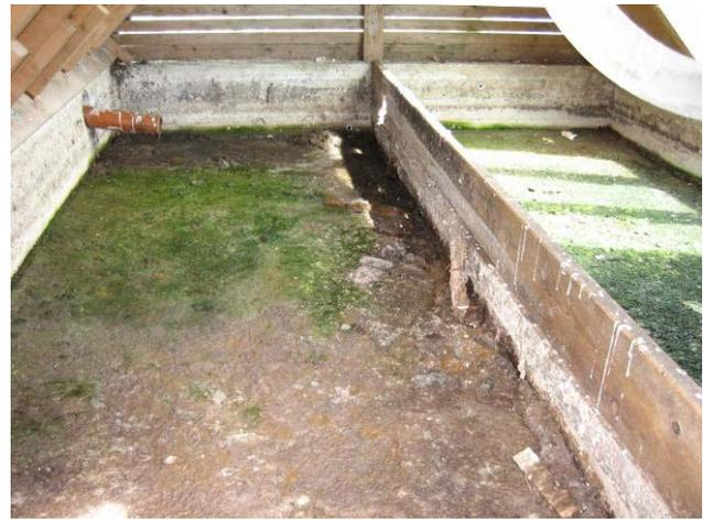
**Abbildung 68: Reststoffe zur Behandlung im Trockenbeet [Foto F.Schönherr (2005)]**
