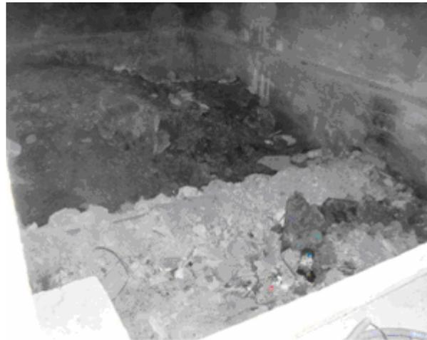
**Abbildung 99: Ableitung von Sickerwasser mittels HT50-Rohren aus dem Mittelteil ins Freie zur dortigen Versickerung in das anstehende Moränenmaterial [Fotos W.Becker (2004)]**
