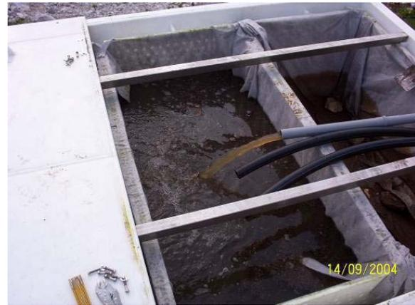
**Abbildung 56: Befüllen von Schlammwässerungsmodul OST mit ÜS2 bei den monatlichen Wartungsarbeiten an der Kläranlage, Überbrückung des nicht beschickten SEM WEST mit fliegenden Leitungen [Foto M.Vallazza (2004)]**
