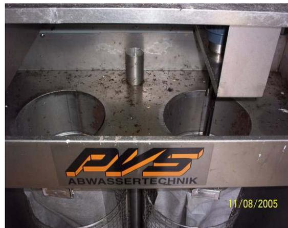
Abbildung 63: Schlammverteilung mit Überwachung durch Sensoren
