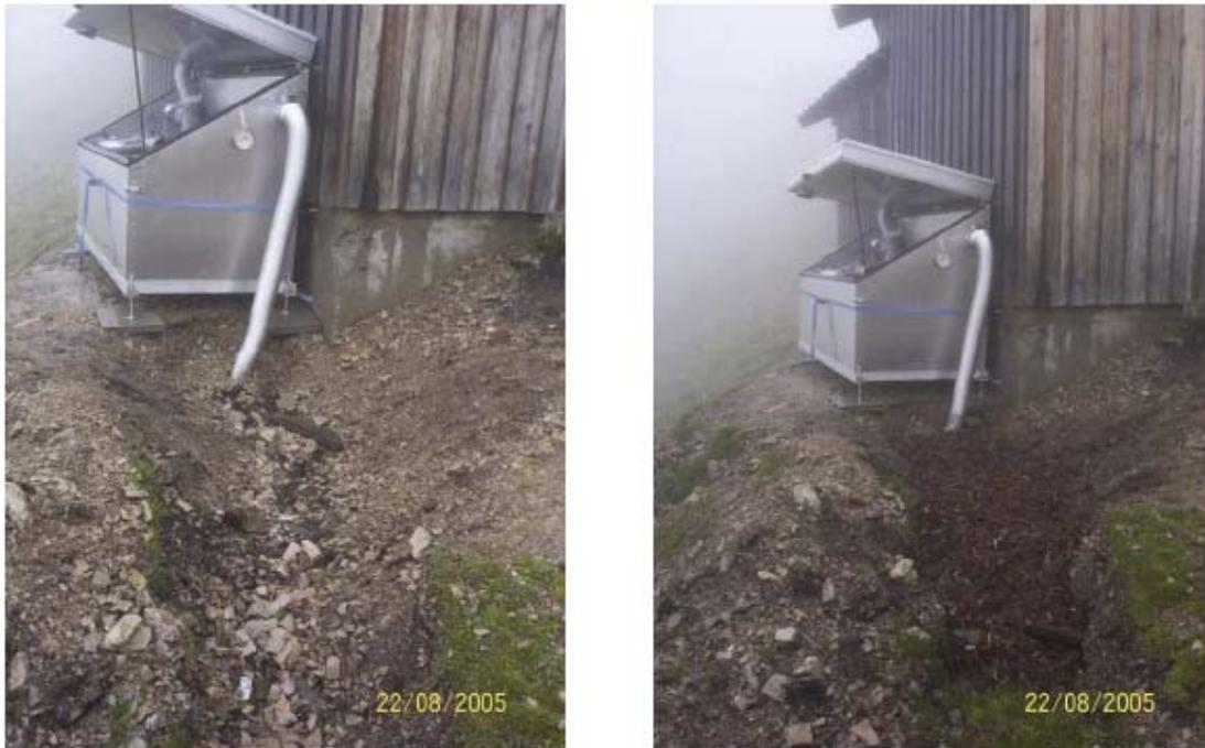
**Abbildung 34: Ansicht des Solar-Schlammrockners nach einer Betriebssaison vor (linkes Bild) und nach (rechtes Bild) der Erneuerung des Rindenmulchfilters [Fotos M.Vallazza (2005)]**
