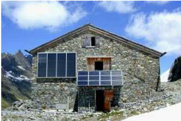
**Abbildung 96: Südansicht der Klostertaler Umwelthütte mit Solar-Luft-Kollektor-Modul und PV-Panelen [Foto W.Becker (2004)]**
