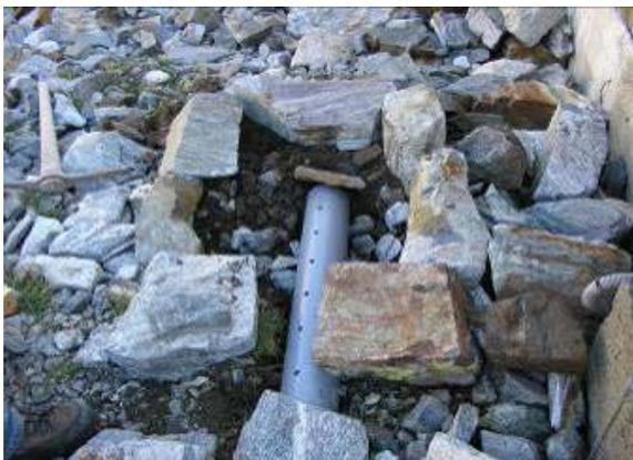
Abbildung 117: Drainagerohr zur Abführung von Sickerwasser und Gerüchen (später mit Rindenmulch bedeckt)
