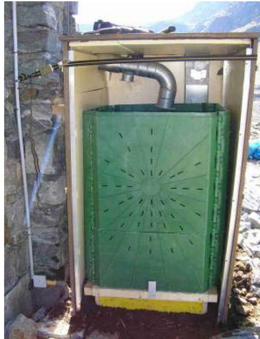
**Abbildung 124: Innerer Kompostbehälter und Sturmsicherung mit Spanngurten**
