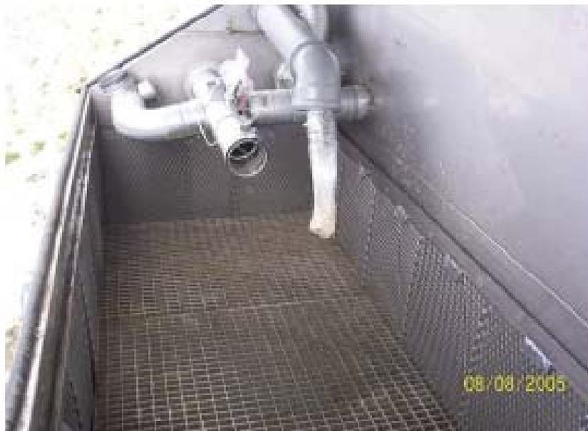
**Abbildung 31: Vergrößerung der Filterfläche durch Anbringung von vertikalen Streckmetallbleche an den vier Seitenwänden [Foto M.Vallazza (2005)]**
