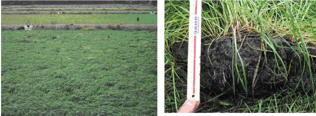
**Abbildung 73: Pflanzenbeetanlage (links) und vererdeter Schlamm (rechts) [Fotos H.Pabsch]**
