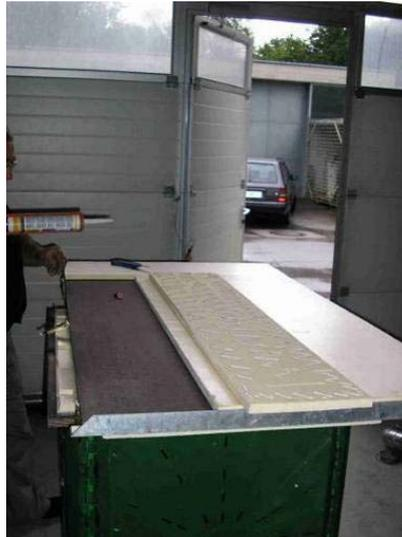
Abbildung 114: Montage der Wärmedämmung
