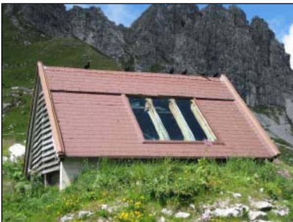
Das überdachte Trockenbeet mit einer Grundfläche von 3,50m · 4,40m = 15,40 m<sup>2</sup> ist so konstruiert, dass eine quasi-kontinuierliche Luftströmung ermöglicht wird, die zum einen für den Abzug von bei der Faulung entstehender Geruchsstoffe und zum anderen für die Feuchtigkeitsabfuhr sorgt. Dabei wird eine Volumenminderung durch die Schwerkraft, klimatische Einflüsse (Verdunstung und Frosteinwirkung) und einer sich ausbildenden Biozönose erreicht.
