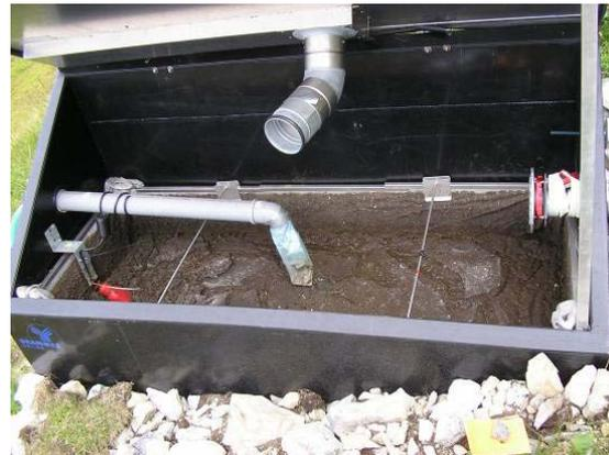
**Abbildung 47: Trockner während der Befüllung + Schwimmerschalter (rot)**
