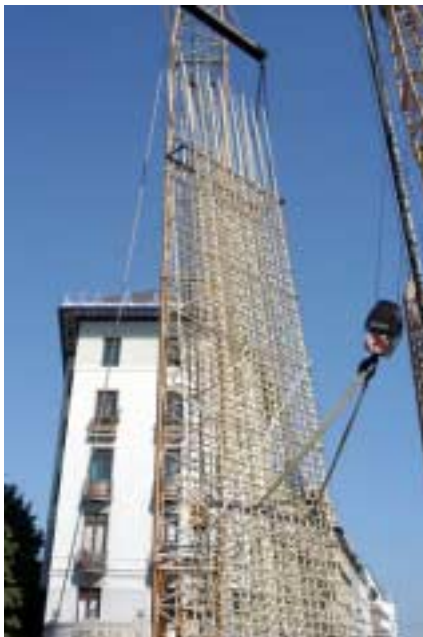
Abb. 31: Aufstellen auf der Baustelle (rechts: Verbinden mit Stahlkorb)
