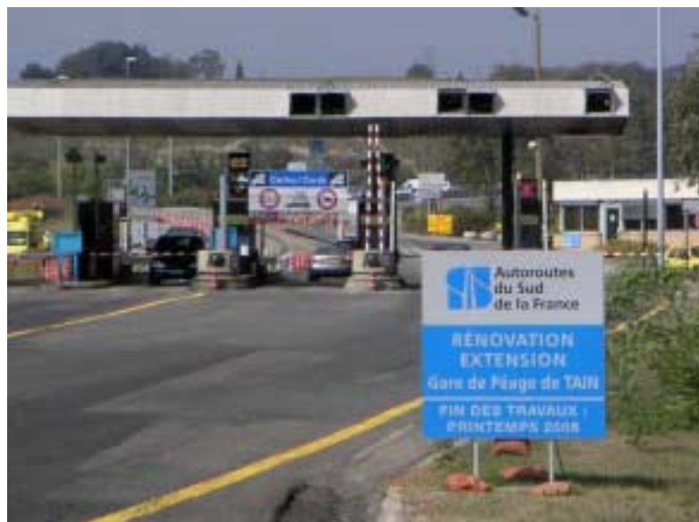
Abb. 36: fertig gestellte Fahrbahnplatte/Mautstation
