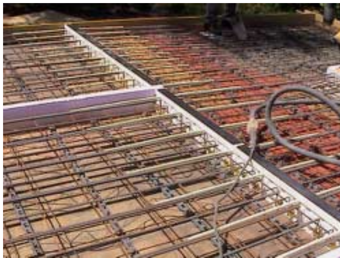
Abb. 26: Versuchsaufbau mit unterschiedlichen Isokörben (Bauphase)
