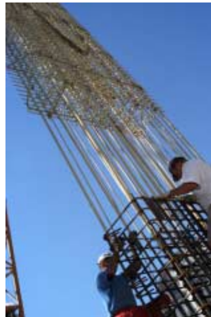
Abb. 31: Aufstellen auf der Baustelle (rechts: Verbinden mit Stahlkorb)
