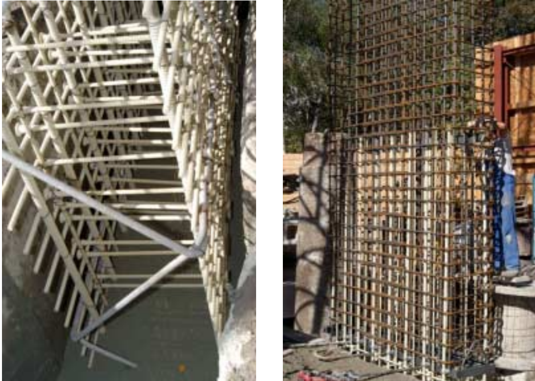
Abb. 32: Absenken des Korbes in den Schlitz und Verbinden mit dem nächsten Stahlkorb
