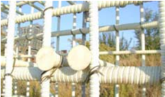
Abb. 30: Aufbau des GFK-Bewehrungssystems
