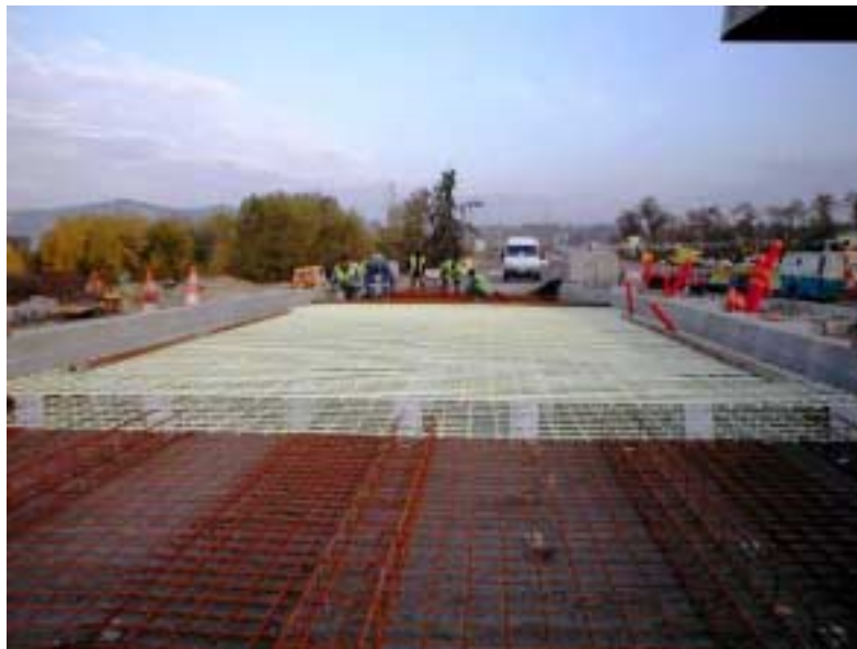
Abb. 35: Einbau des Bewehrungssystems aus GFK-Stäben (Fahrbahnplatte einer Mautstation)
