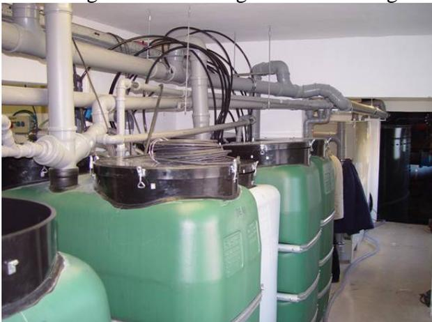
Abbildung 7: v.l. Nitrifikation I und II, Mischbehälter, Denitrifikation I und MBR II
