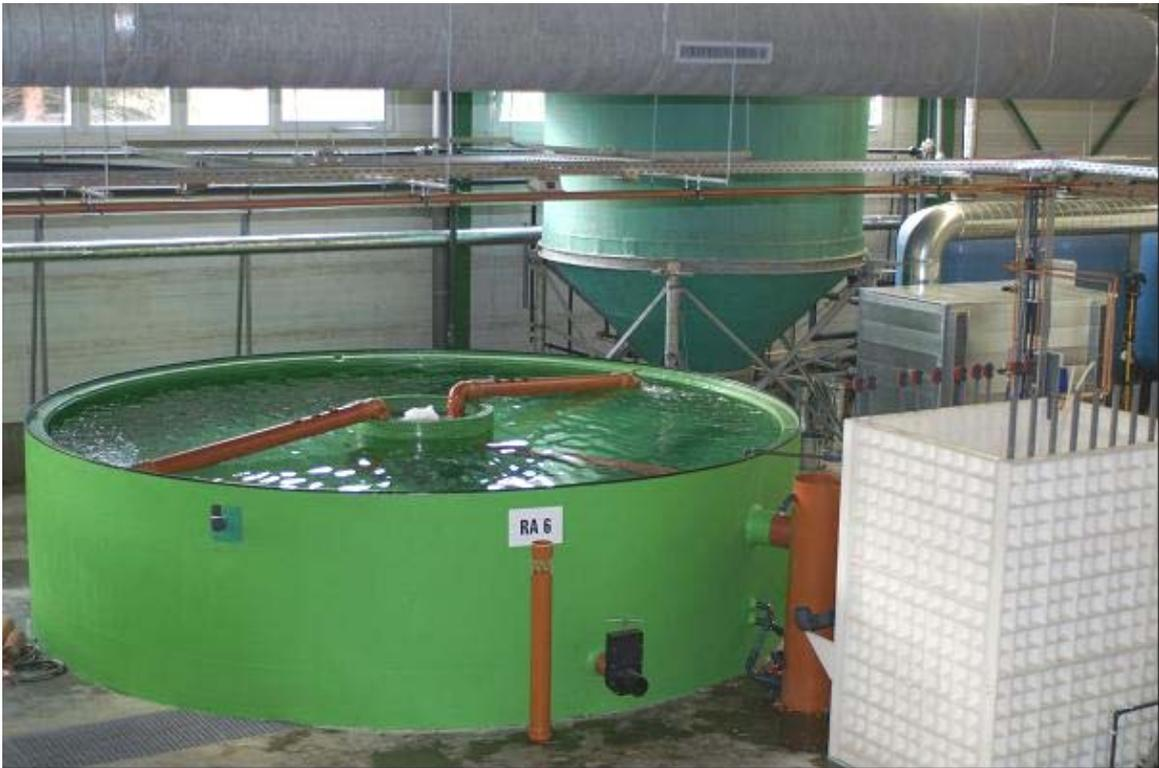
eine von 6 Rundstrombecken-Anlagen (rechts im Bild Membranfilter)
