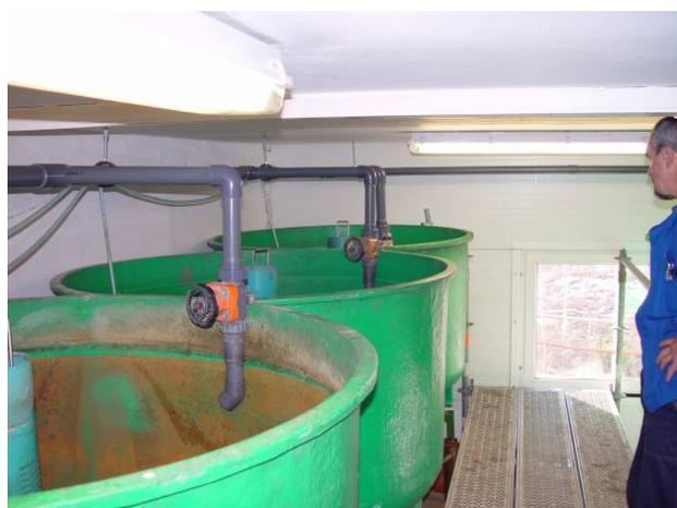
Abbildung 4: Zu- und Abläufe und Unterkonstruktion der Fischbecken.
