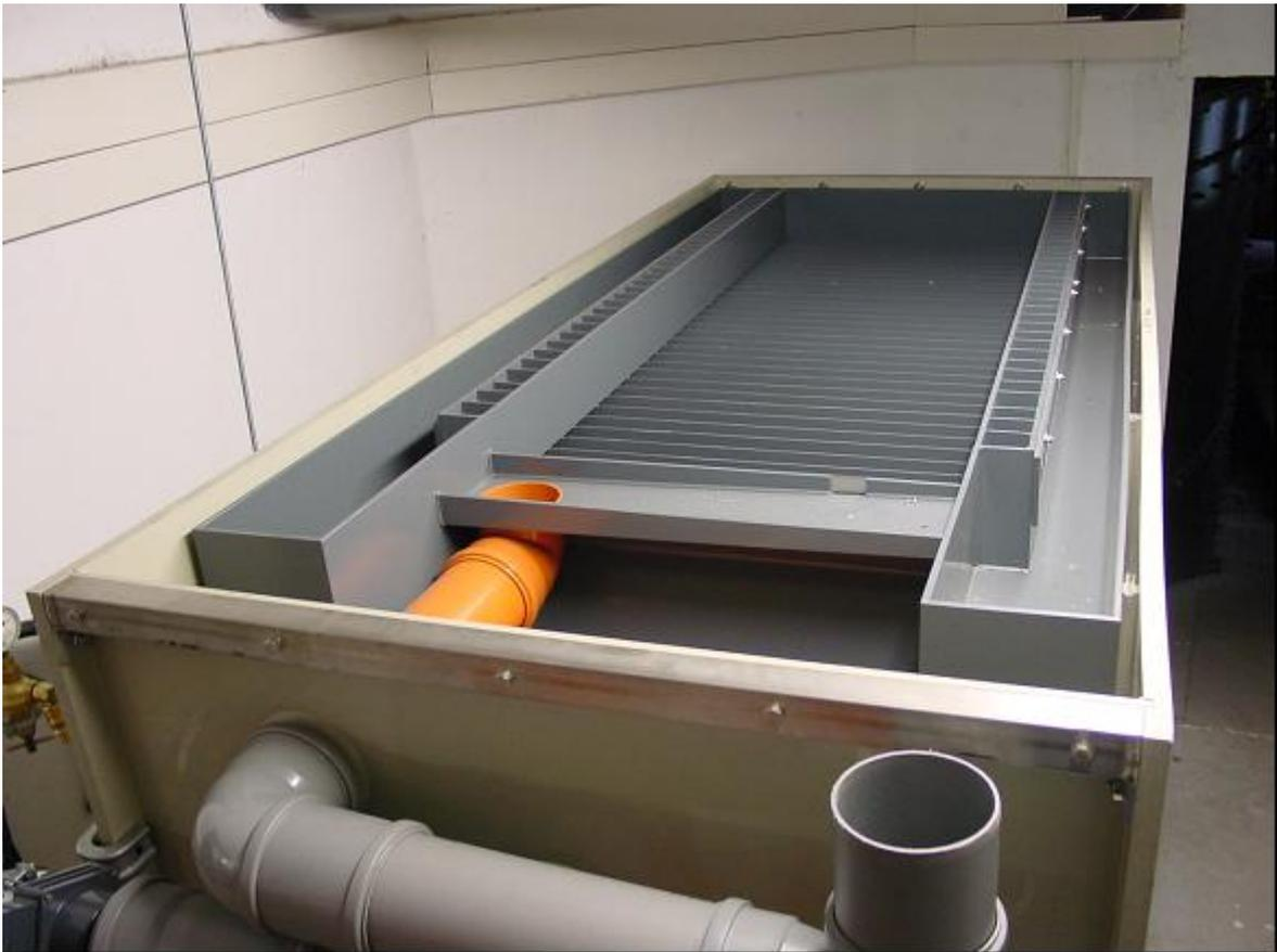
Abbildung 5: Lamellenseparator LMS 7
