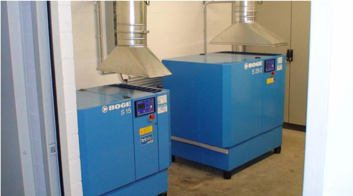
Luftkompressoren mit Abwärmenutzung
