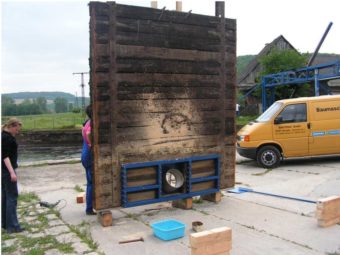
Foto 17: Einbau des bodennahen Bypassrohres in das Schütz des Leerschusses 2005
