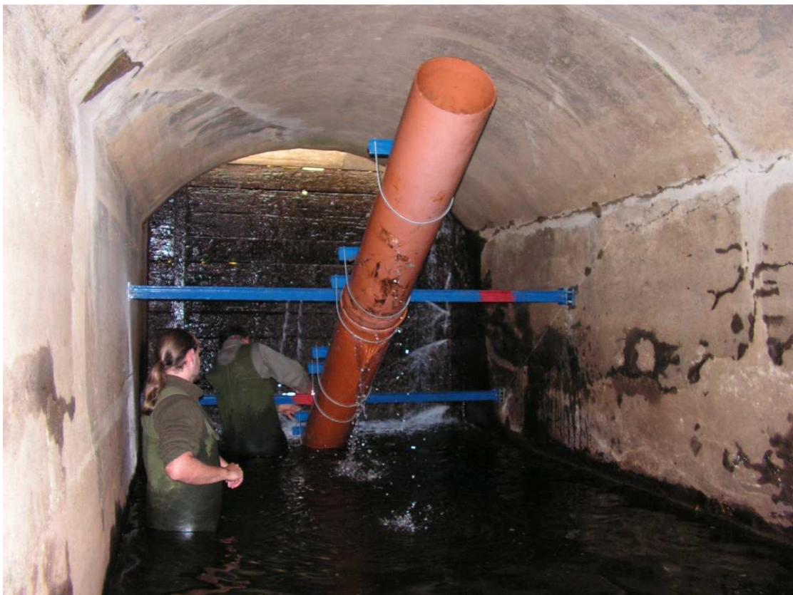
Foto 18: Bypassrohr im Leerschusskanal
