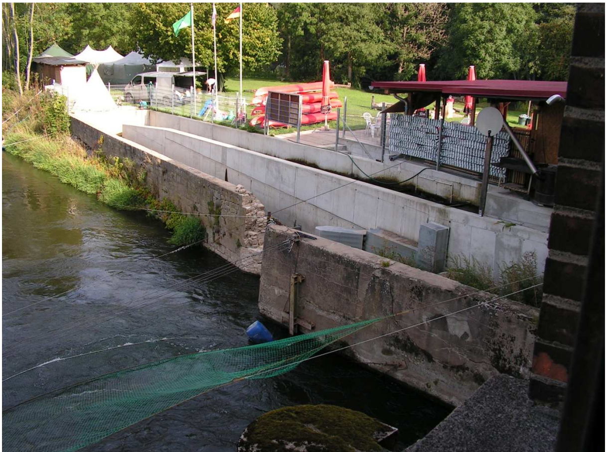
Foto 24: Anbindung des Schlitzpasses unterhalb der Turbinen (hier mit aufgespanntem Hamen)
