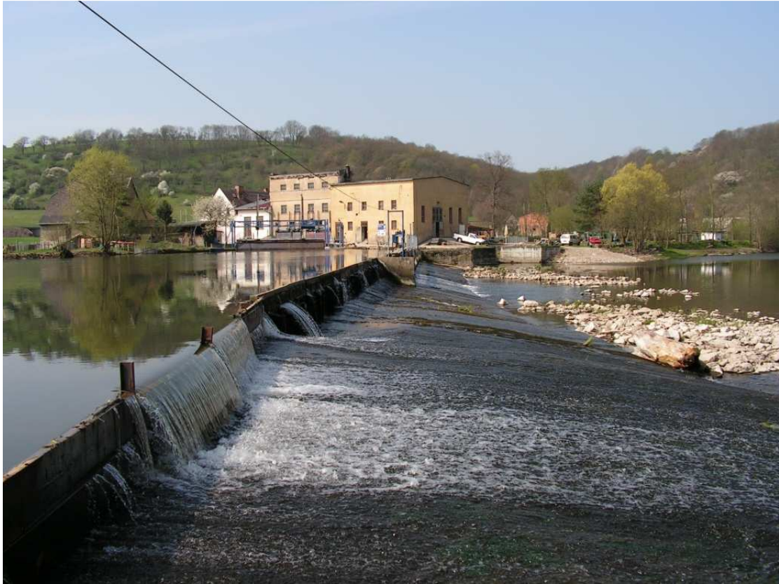
Foto 5: Betonwehr mit Bretteraufsatz, Blick Richtung Wasserkraftanlage
