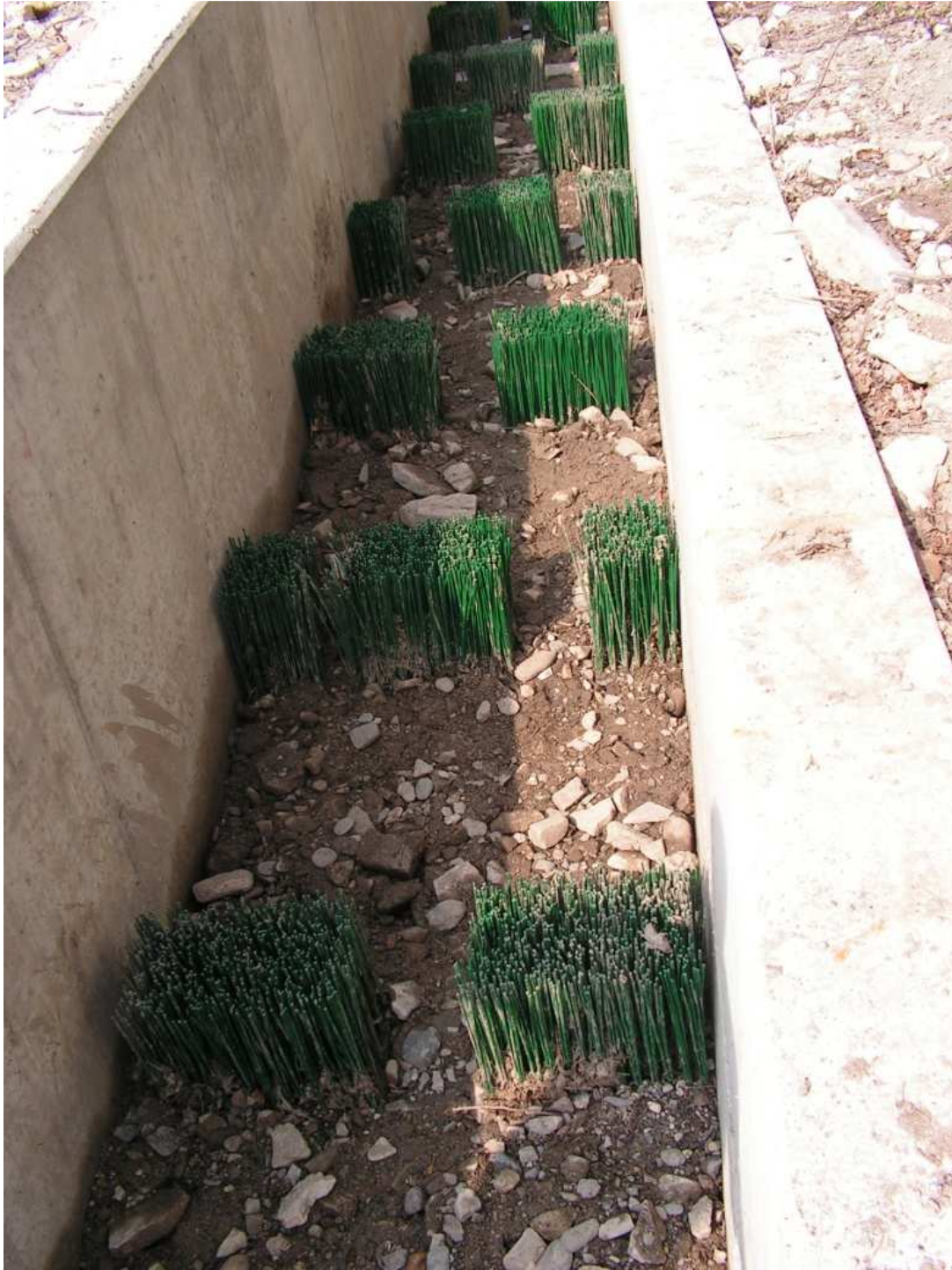
Foto 13: Borstenfischpass vor der ersten Bespannung
