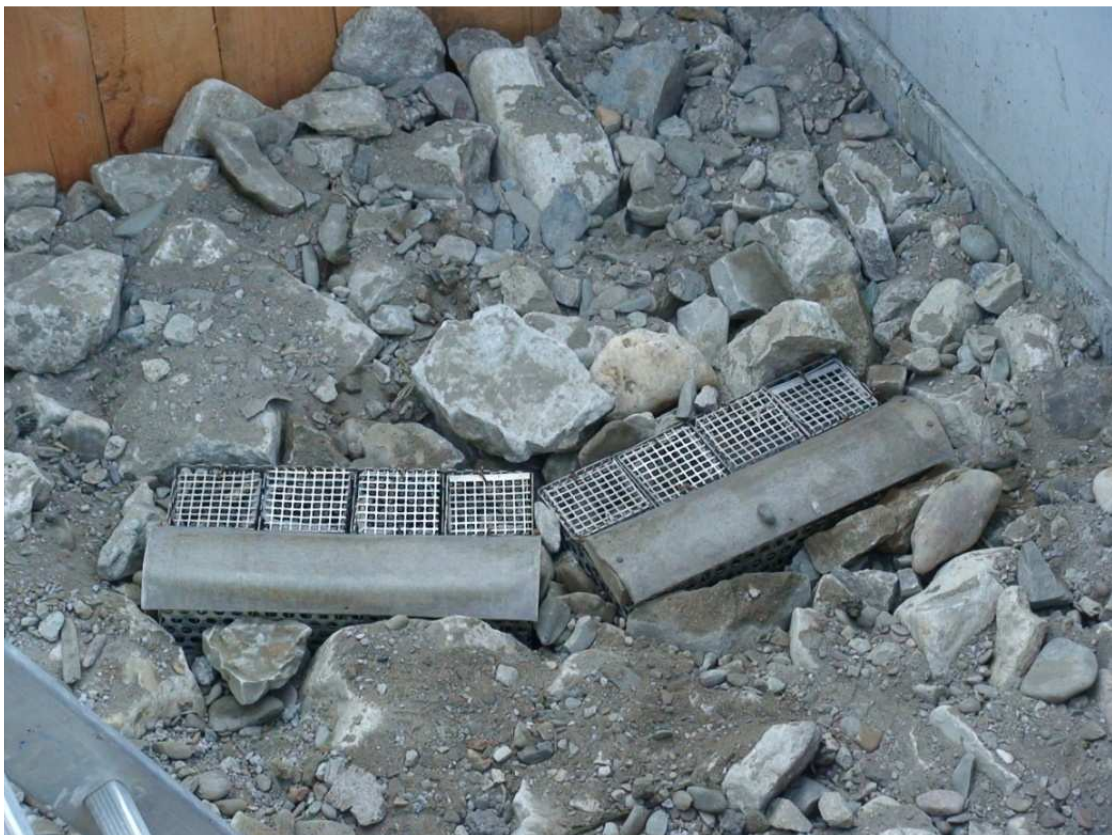
Foto 54: Besiedlungskisten in das Sohlsubstrat eingebaut
