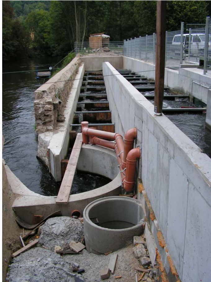
Foto 29: Schlitzpass mit Vorbecken.
