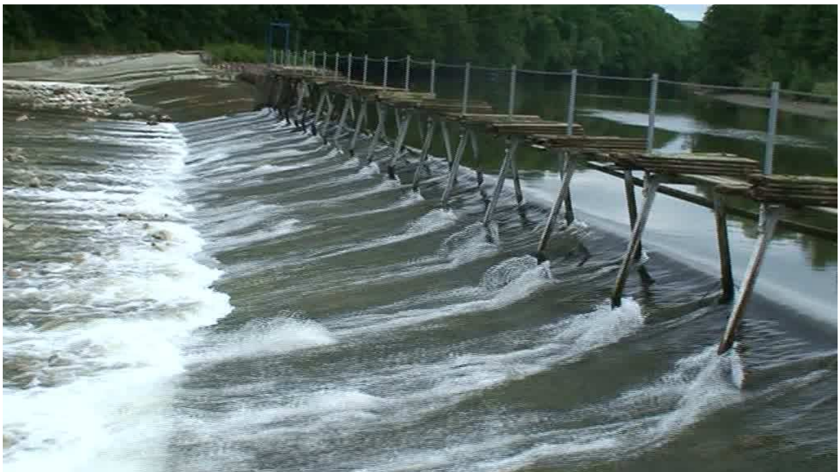
Foto 6: geöffnetes Nadelwehr
