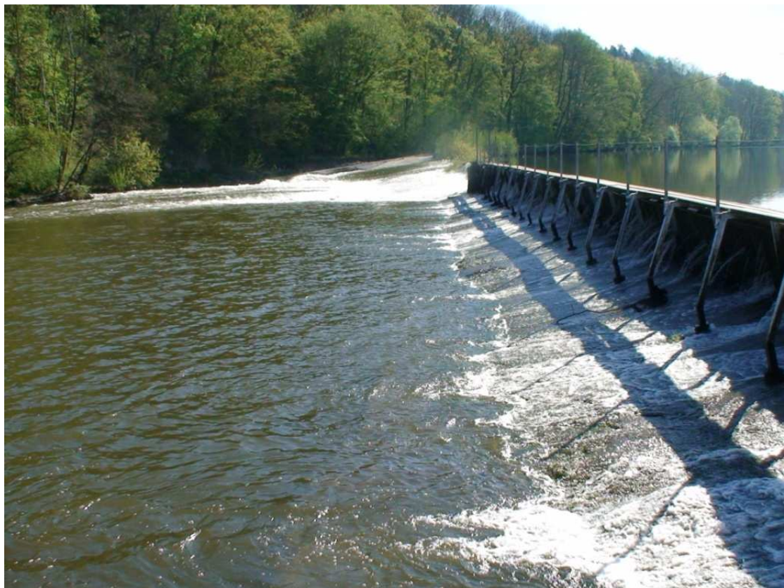
Foto 4: Wehr der WKA Döbritschen, am rechtsseitigen Ufer befindet sich der Borstenfischpass
