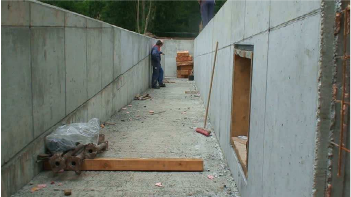
Foto 21: Rohbau des Schlitzpasses mit Öffnung für Sichtscheibe
