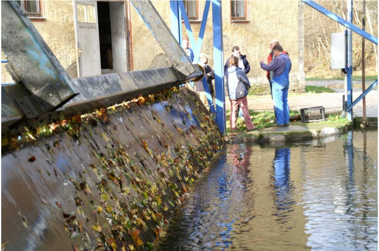
Foto 3: Rechen mit Rechenreiniger
