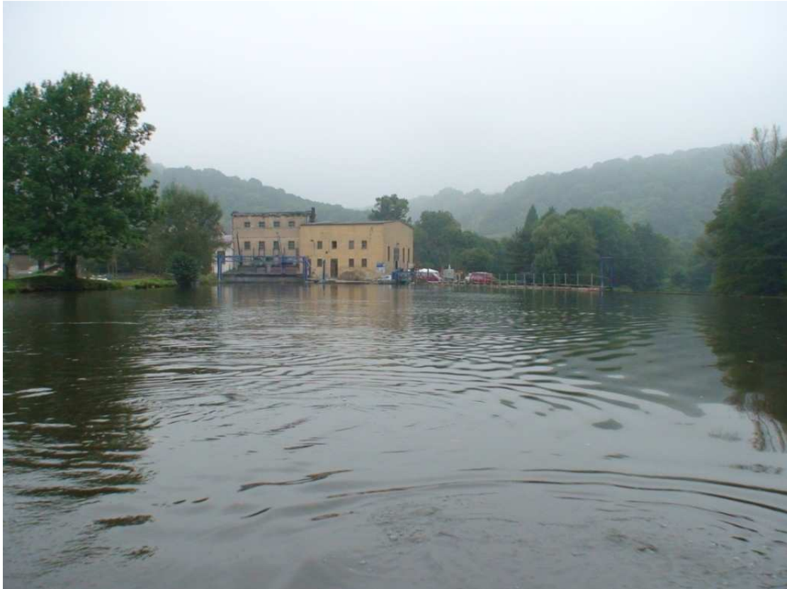
Foto 1: Gebäude der Wasserkraftanlage Döbritschen vom Oberwasser aus gesehen
