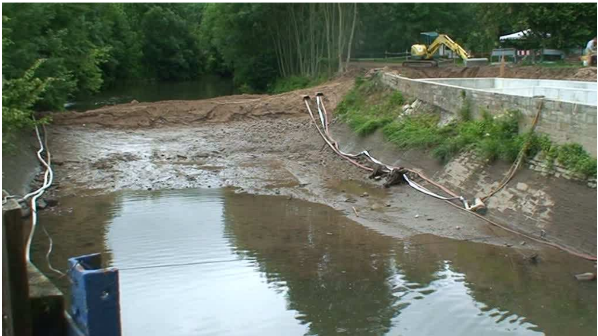
Foto 22: Fangedamm unterhalb der Turbinen
