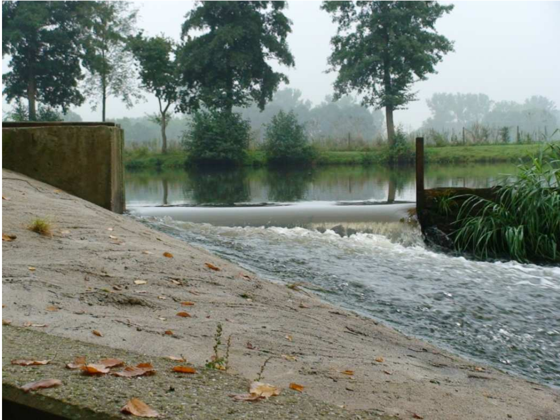
Foto 11: geöffnetes Wehrfeld für die Restwasserabgabe
