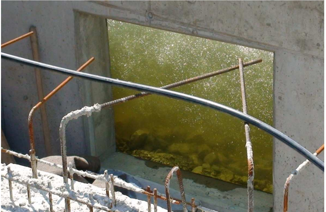
Foto 33: Sichtscheibe im ersten Becken des Schlitzpasses (Beobachtungsraum im Bau)
