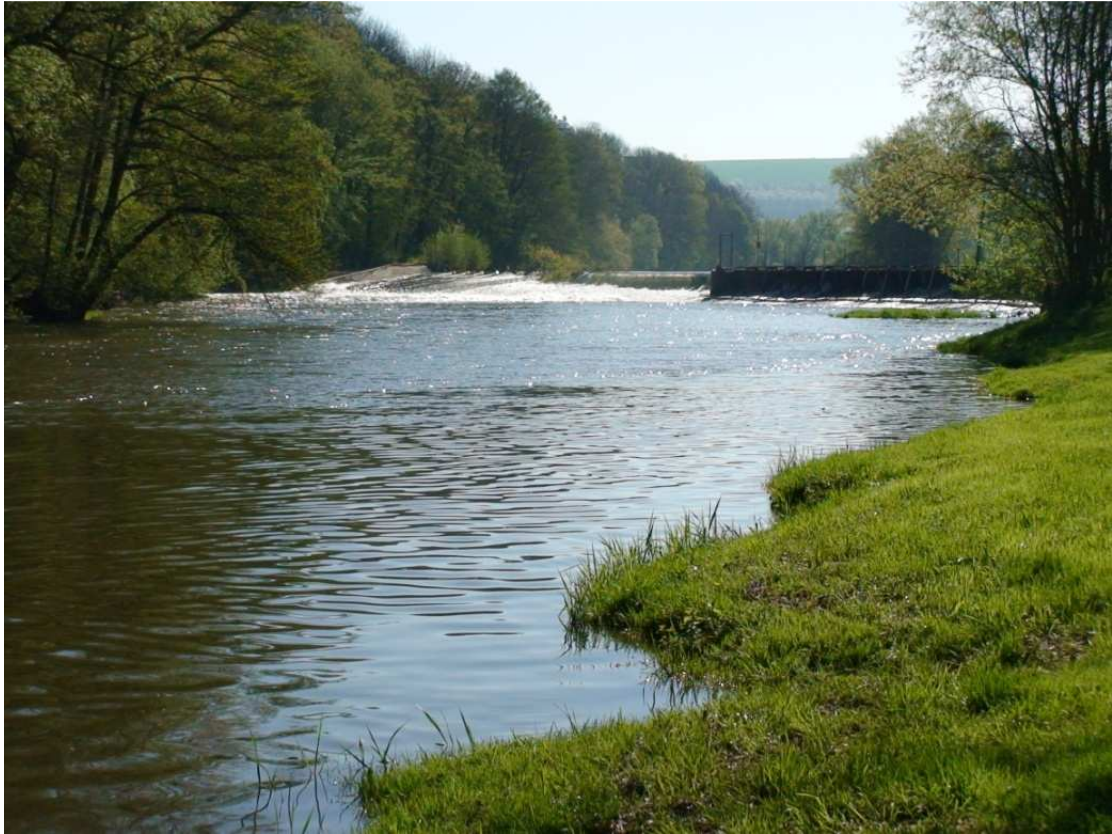
Foto 7: Blick auf das Wehr und den oberen Teil des Mutterbettes
