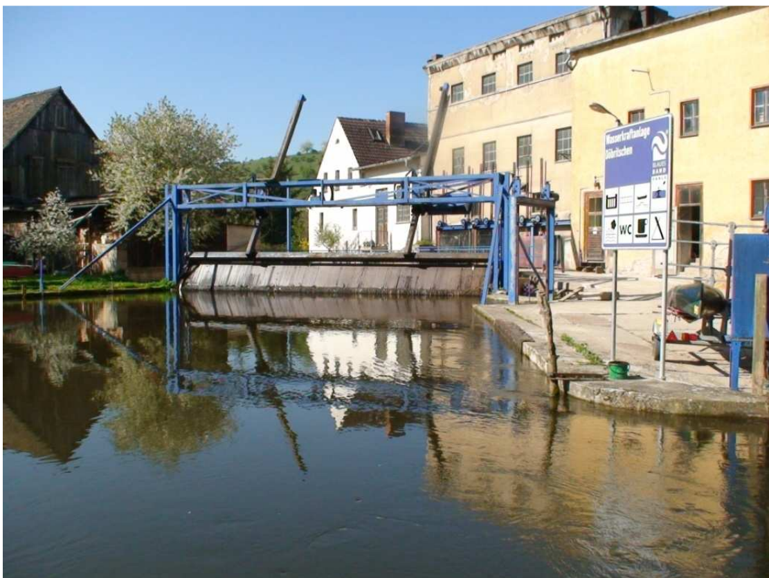
Foto 2: Rechenanlage der WKA Döbritschen
