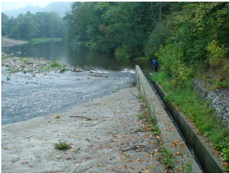
Foto 12: Verstärkung der Leitströmung des Borstenfischpasses(rechts) durch die Restwasserabgabe
