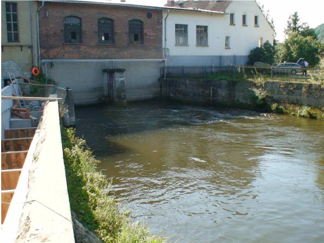
Foto 9: Turbinenkanal, Turbulenzzone unterhalb des Wasseraustritts
