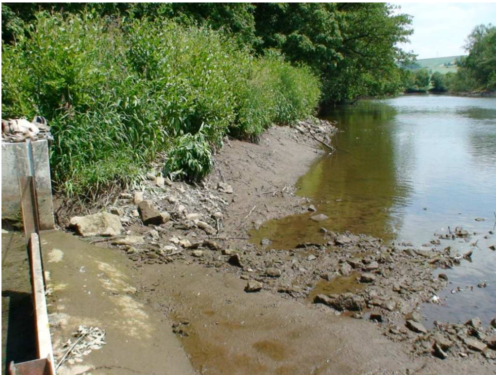
Foto 58: Bei abgelassenem Stauraum wird der Übergang von der Sohle des Oberwassers zum Wehr sichtbar. Absteigende Fische können nahezu sohlgleich abwandern (bei bis unten geöffnetem Bretteraufsatz)
