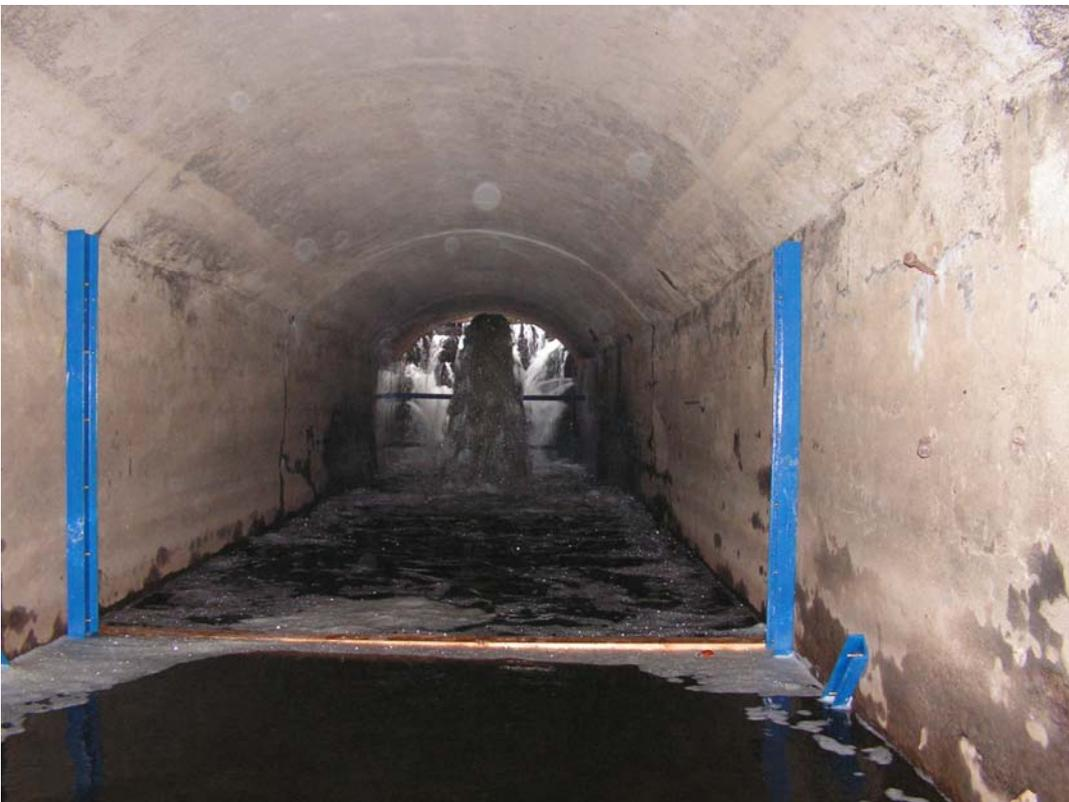
**Foto 38:** unter Holzbalken eingebrachte Schwalgreuse zur Kontrolle des Fischabstiegs über den Bypass
