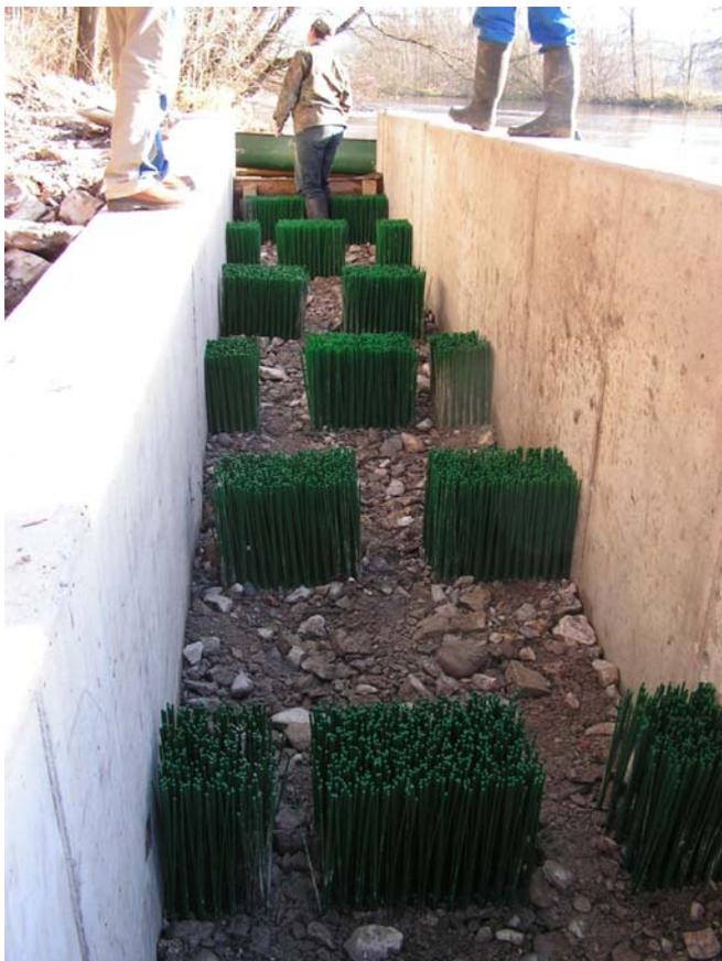
**Foto 4:** mit Borstenelementen und Sohlsubstrat bestückter FKP vor Inbetriebnahme
