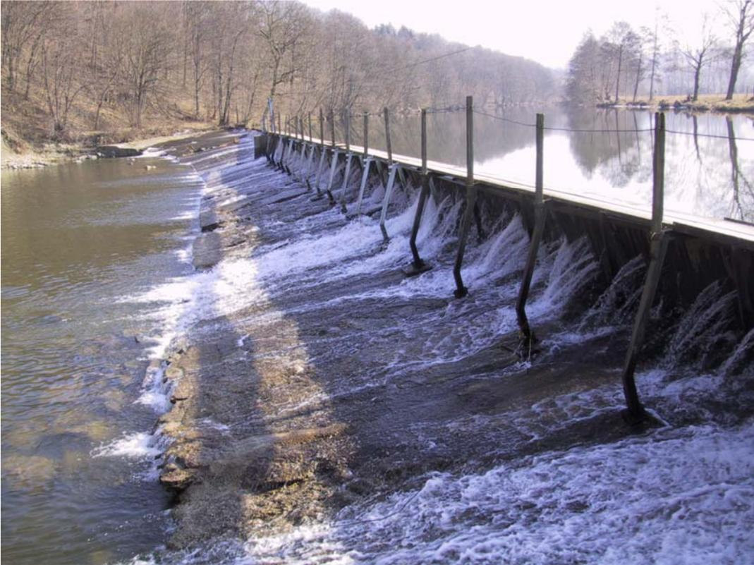
**Foto 1:** Nadelwehr in Döbritschen vor Errichtung der Fischwanderhilfe
