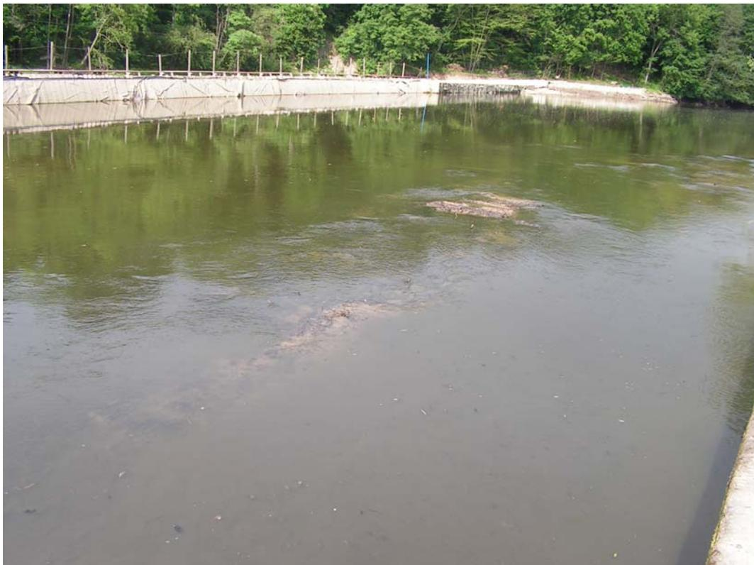
**Foto 47:** Sedimentablagerung vor dem Rechen im Bereich der linken Ufermauer (flussabwärts)
