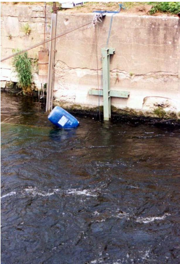
**Foto 22:** blaues Fass als Auftriebskörper zum Aufschwimmen der Hamenecke bei der Demontage
