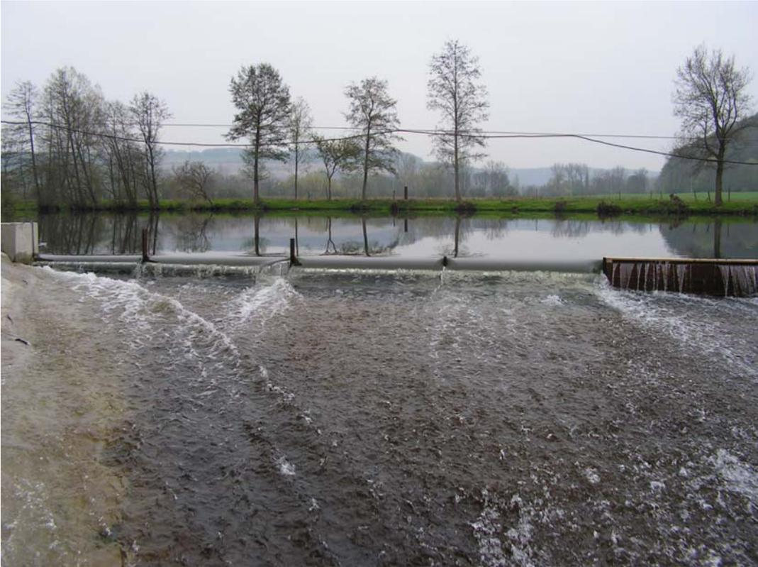
**Foto 41:** geöffnete Wehrfelder zur Abgabe einer zusätzlichen Wassermenge zur Gewährleistung der Mindestwasserabgabe
