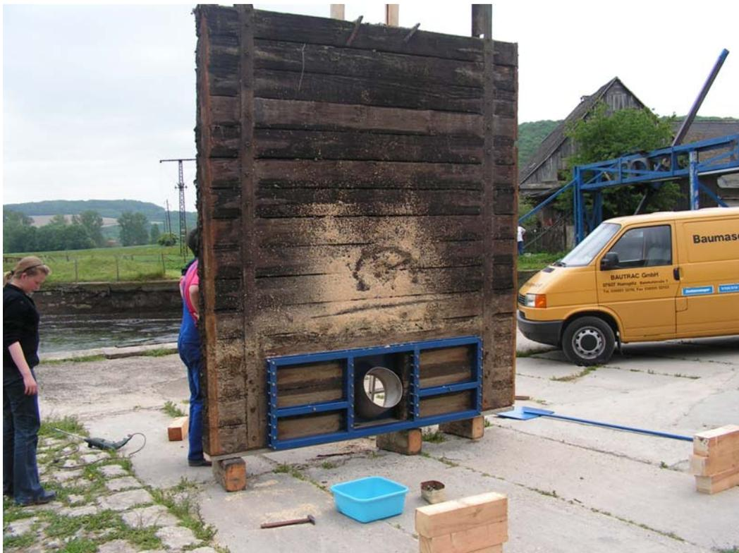
**Foto 8:** in Freischussschütz bodennah eingebrachtes Schlupfloch
