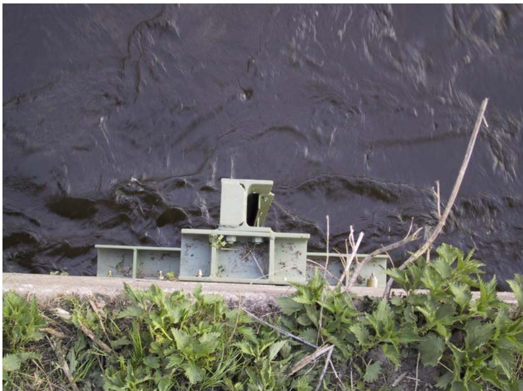
**Foto 20:** rechter Stahlträger mit angeschweißter Führungsschiene
