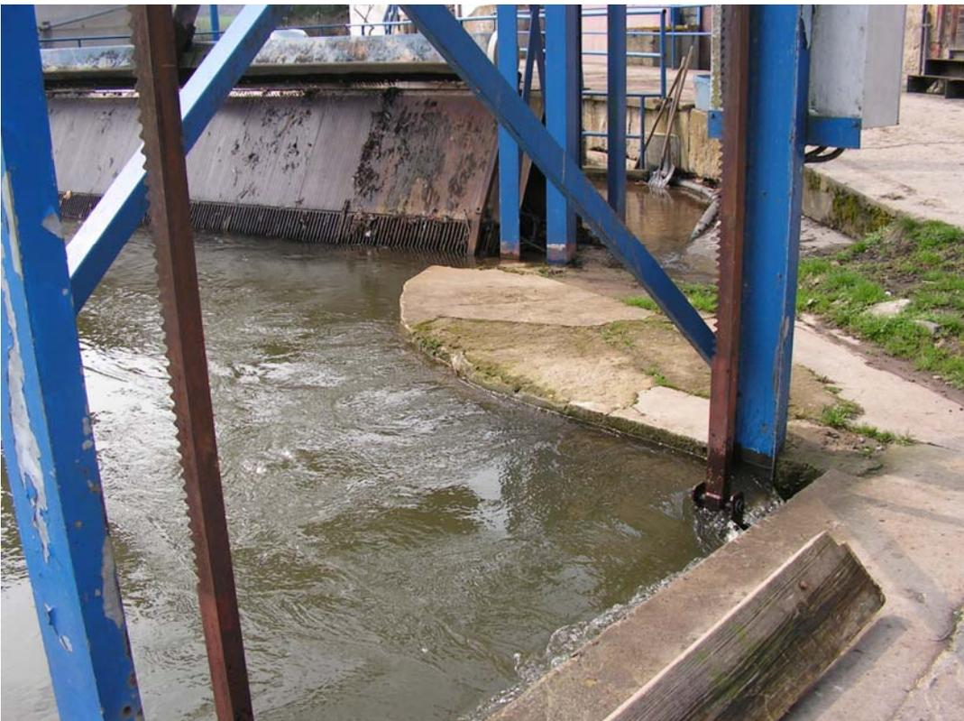
**Foto 42:** das Freischussschütz im unmittelbaren Bereich vor dem Rechen ist optimal für den Fischabstieg geeignet
