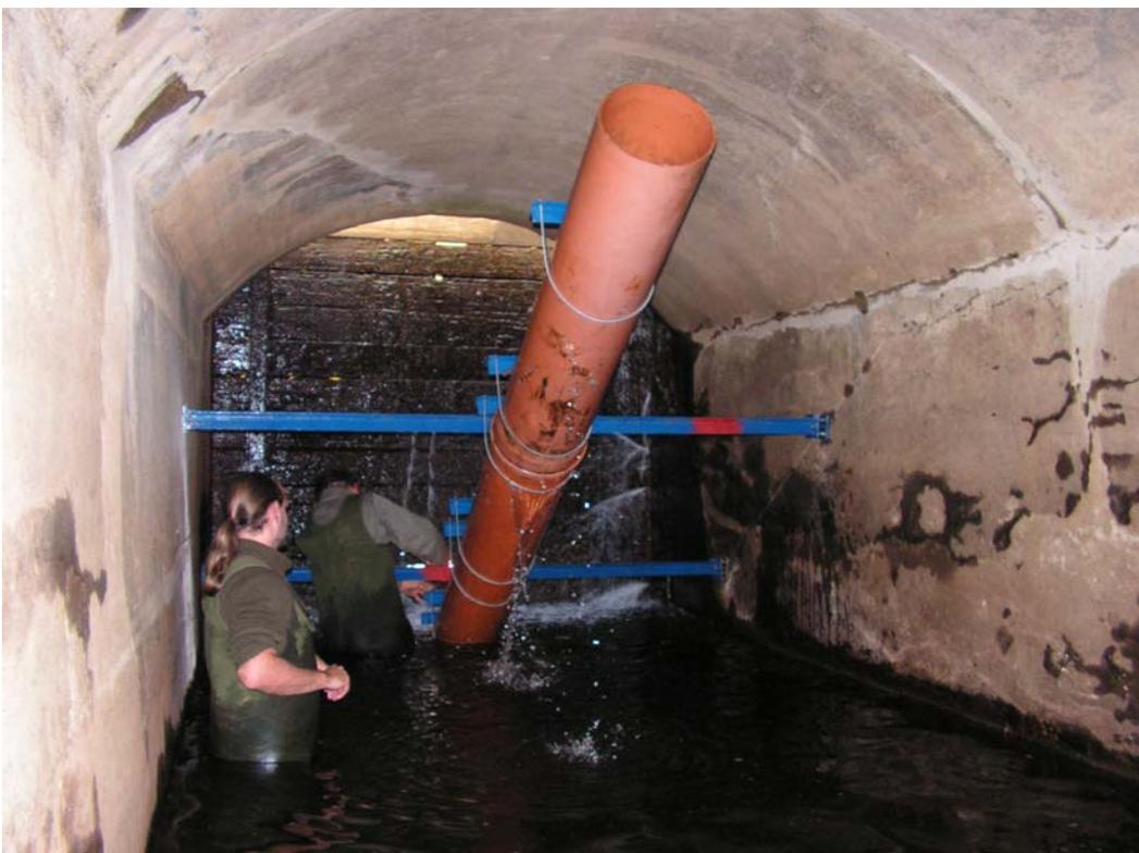
**Foto 10:** montiertes Abstiegsbypassrohr
