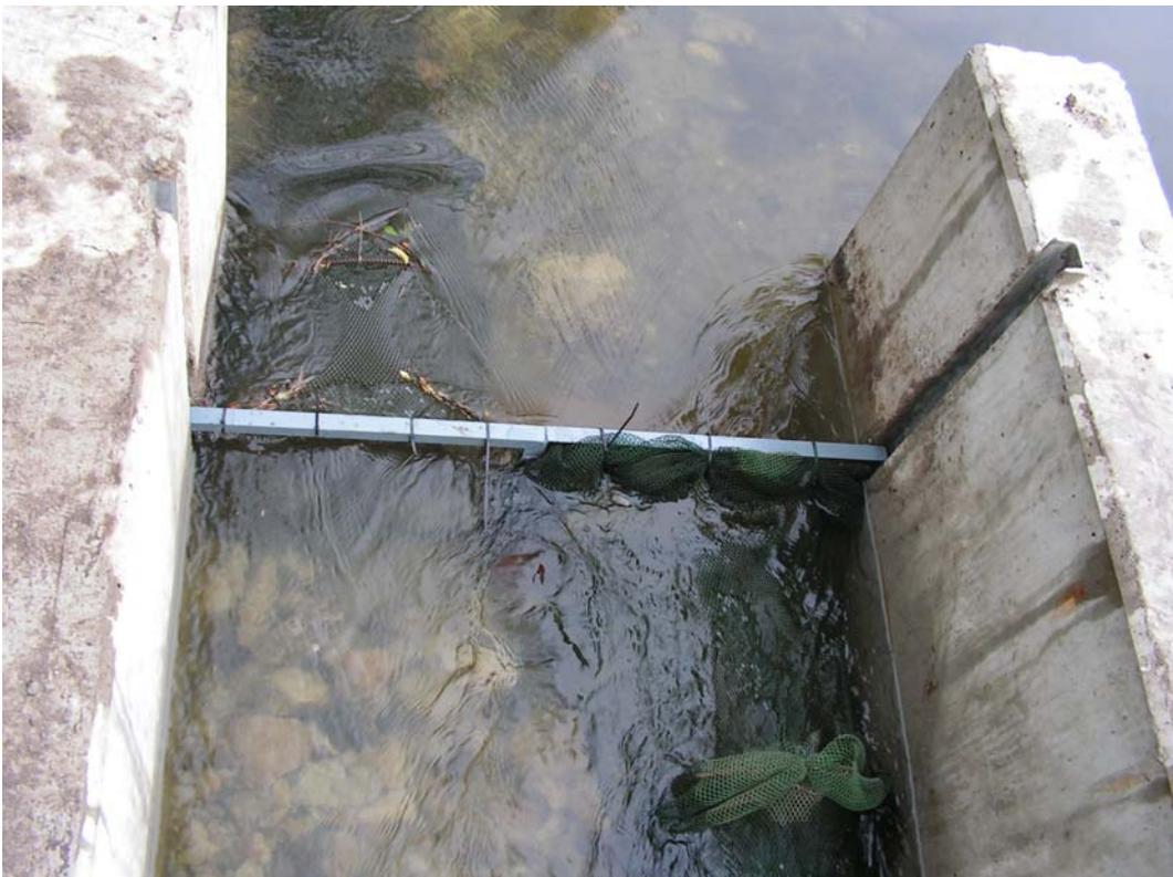
**Foto 36:** Auf- und Abstiegsreuse in den U-Profilen des Einlaufbauwerks des FKP eingesetzt
