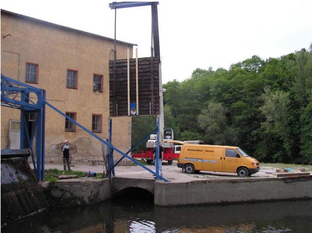
**Foto 9:** das Feischusschütz mit bodennahem Schlupfloch beim Einsetzen in die U-Profile
