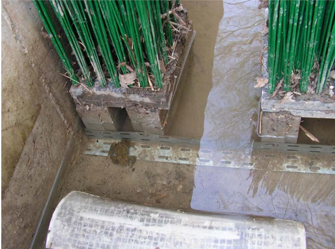
**Foto 50:** mittels Metallwinkel fixierte Borstenelemente
