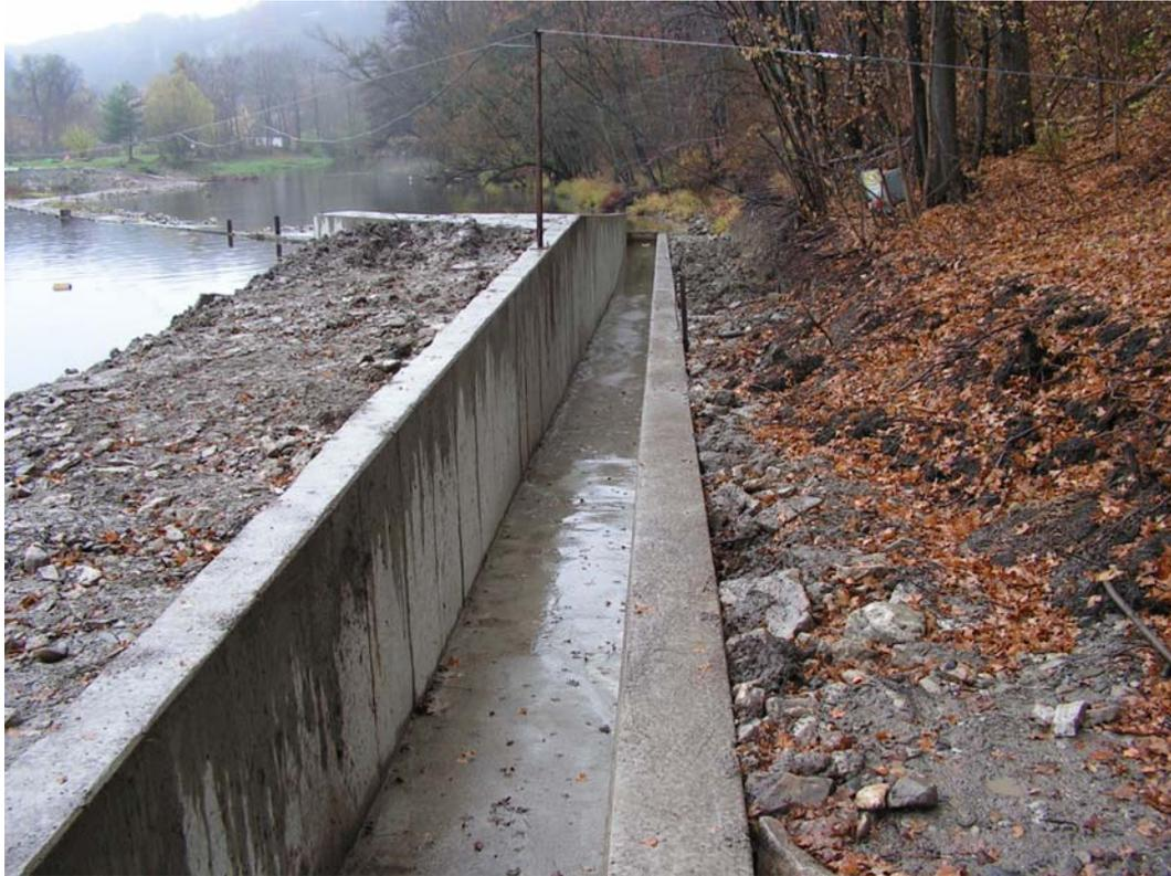
**Foto 3:** fertig errichtete Betonrinne für den FKP
