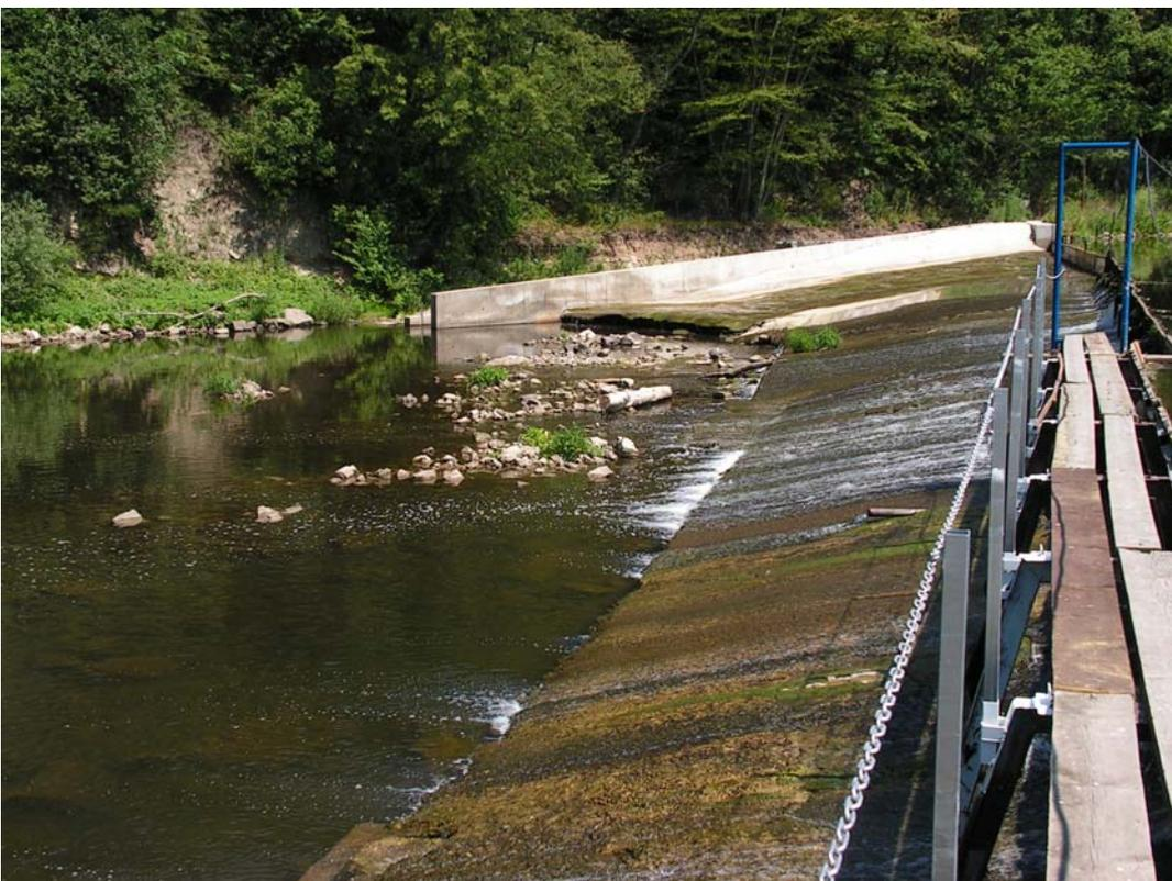
**Foto 53:** FKP im Hintergrund des Bildes ohne paralleler gezielter Mindestwasserabgabe – durch das Wehr fließt unkontrolliert Wasser, welches konkurrierend zum FKP eine Lockströmung erzeugen kann
