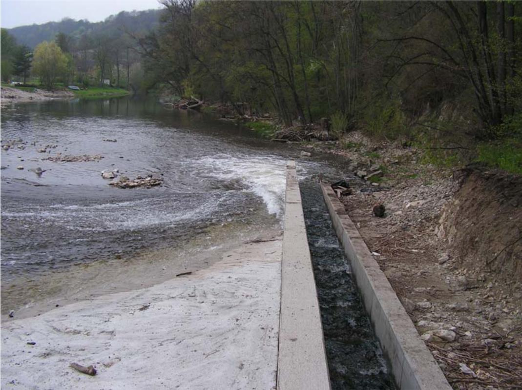
**Foto 37:** zusätzliche Wasserabgabe über das Wehr im Bereich der Fischwanderhilfe zur Gewährleistung der Mindestwasserabgabe
