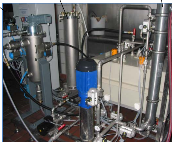
Anlagenaufbau mit Polymermembran
