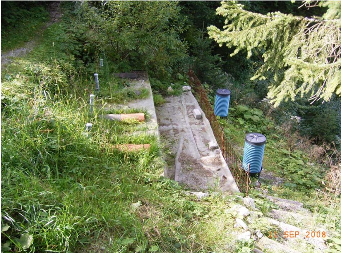
Bild 3: Kaskadenartige Anordnung der Behälter mit Probeentnahmeschacht und Auslauf in Sickerrohre im Hang
