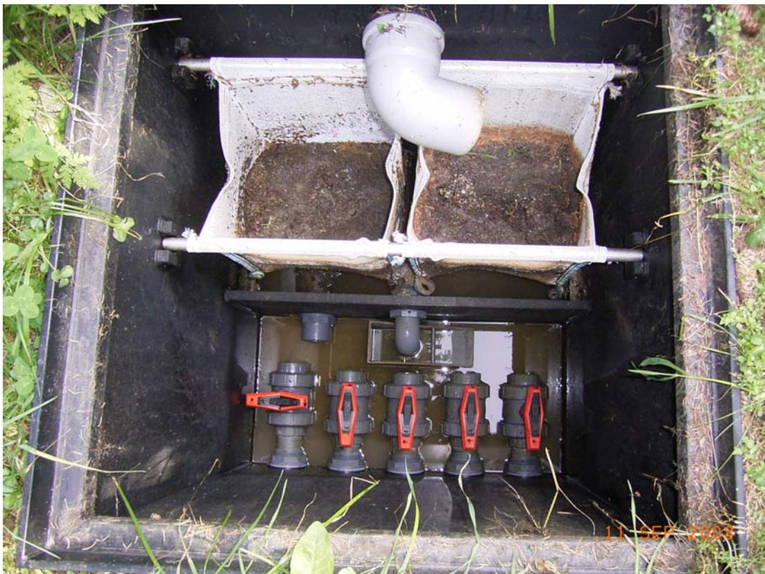
Bild 2: Verteilerschacht mit Filtersäcken, Kippheber und Absperrschieber zu den Verteilerrohren
